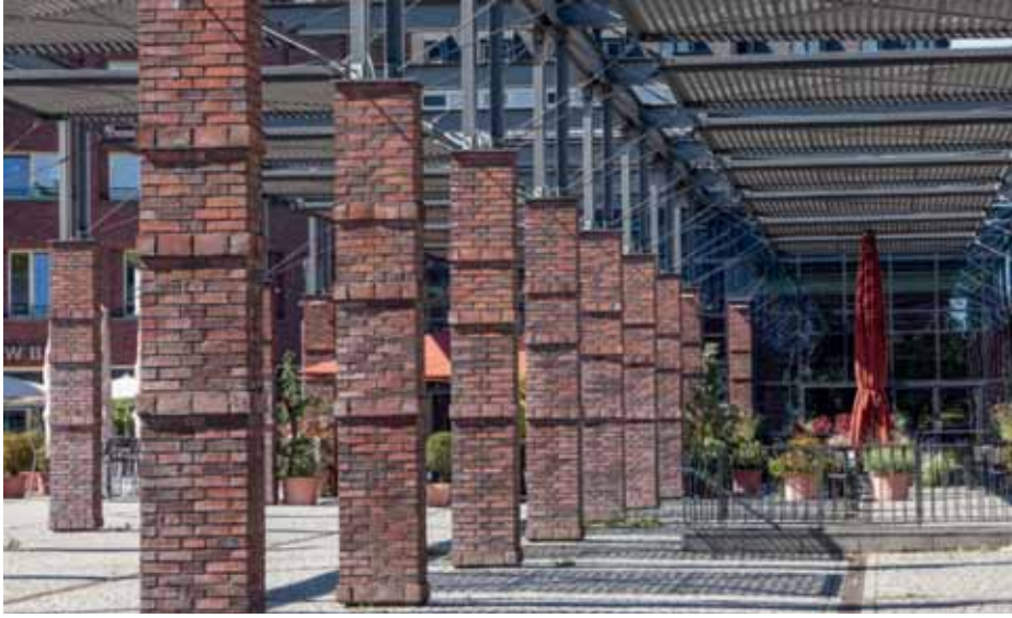
Eine Arkade mit Säulen aus roten Kohlebrandziegeln sorgt für Schatten im Außenbereich der Restaurants.
