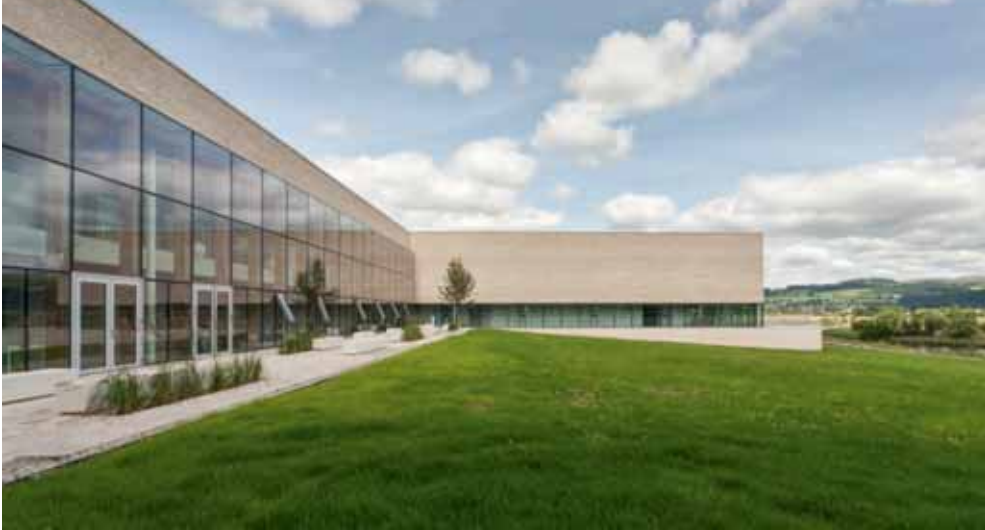
Reiach and Hall ließen sich von den gemauerten Projekten des Architektenbüros aus den 60er und 70er Jahren inspirieren, als sie die Gebäude in Stirling (oben) und Alloa entwarfen.
