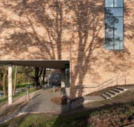
Das Alloa College wurde aus Kohlebrandziegeln D76 in bräunlichen Nuancen gebaut.
