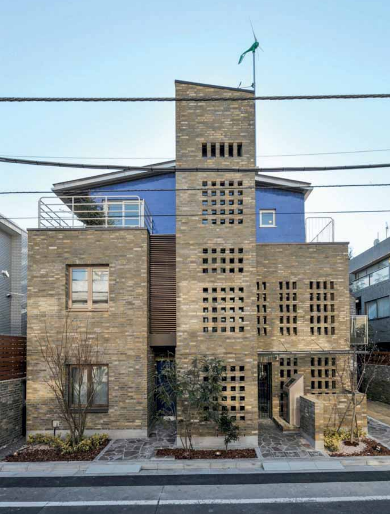
Aufzug und Treppe befinden sich in einem Turm, der über das Dach hinaus in Richtung Straße strebt. Die perforierte Einsteinmauer des Turms sorgt für Tageslicht und für eine natürliche Lüftung.
