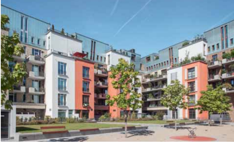
Die Wohnblöcke prägen zahlreiche grüne Dachgärten und Hofanlagen.
