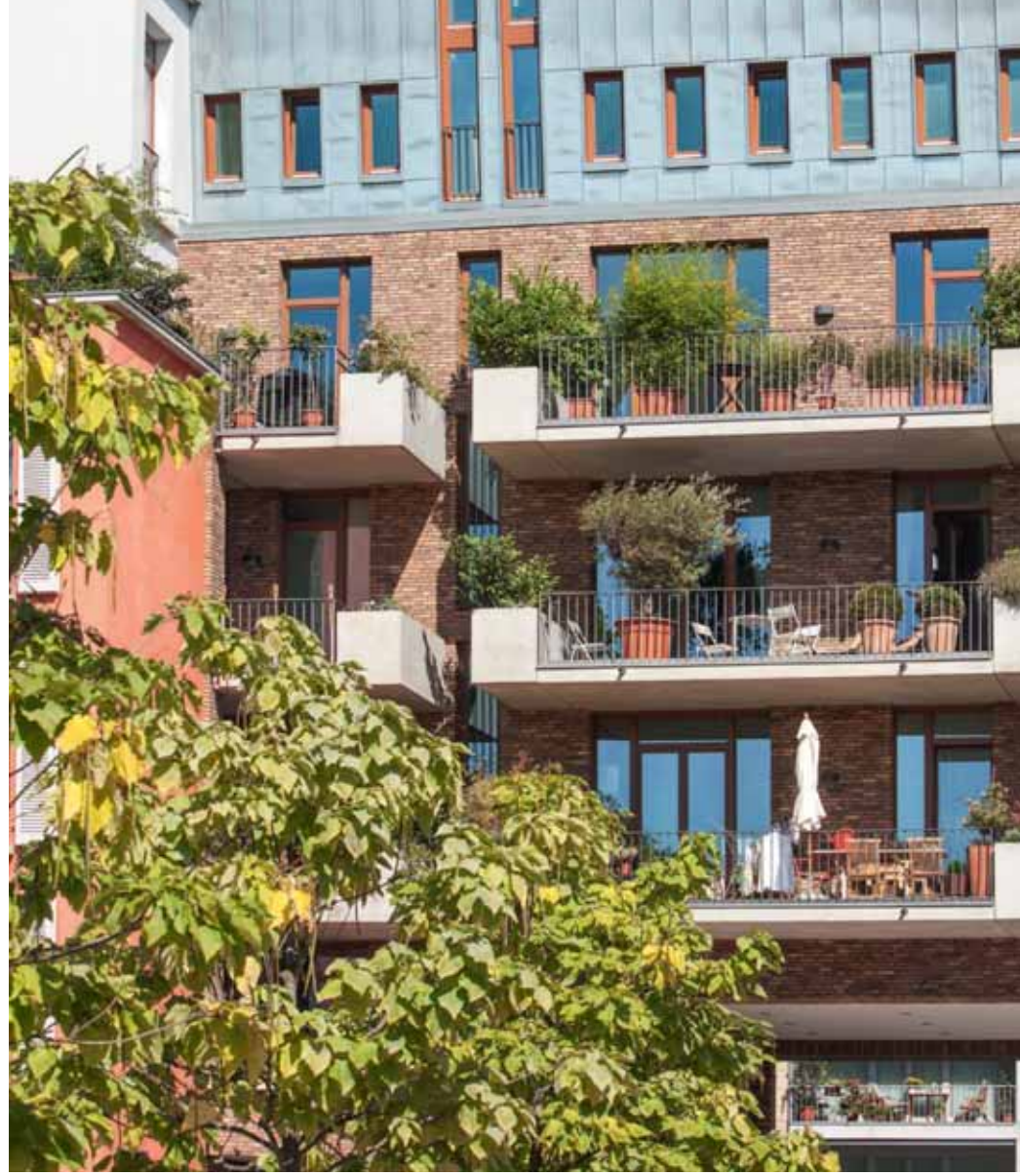
Die Anlage wirkt architektonisch variiert auf den Betrachter, da für die Fassaden Putz, Metall und Mauerwerk in verschiedenen Nuancen gewählt wurden.
