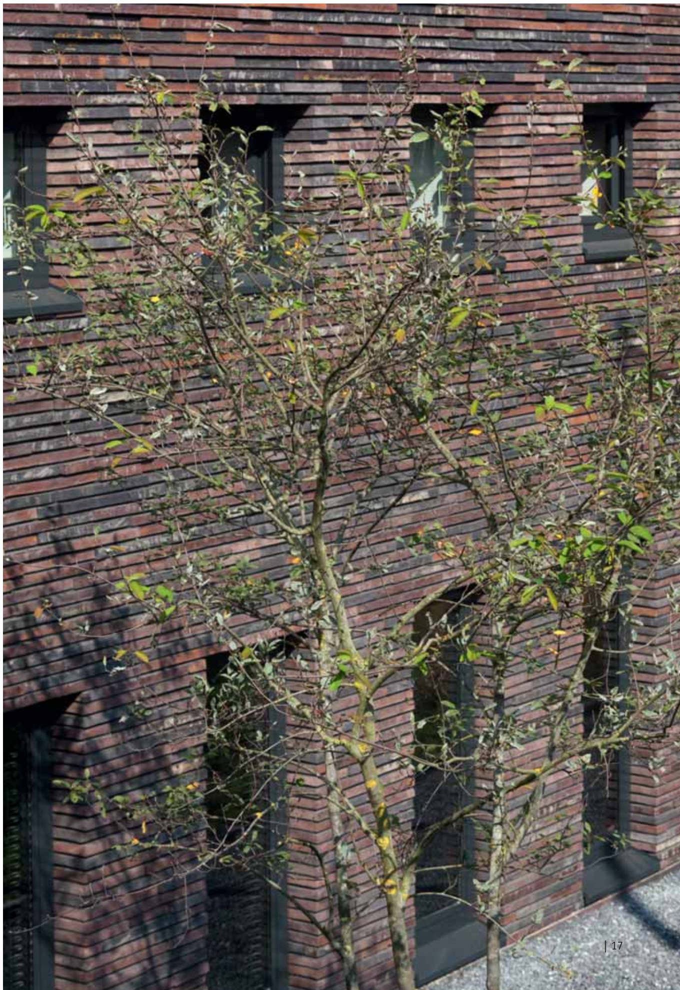
Die geschlossene, schwere Ostfassade ist der Hanglage angepasst. Es konnten daher Fenster vorgesehen werden, so dass Tageslicht in das Untergeschoss dringen kann.
