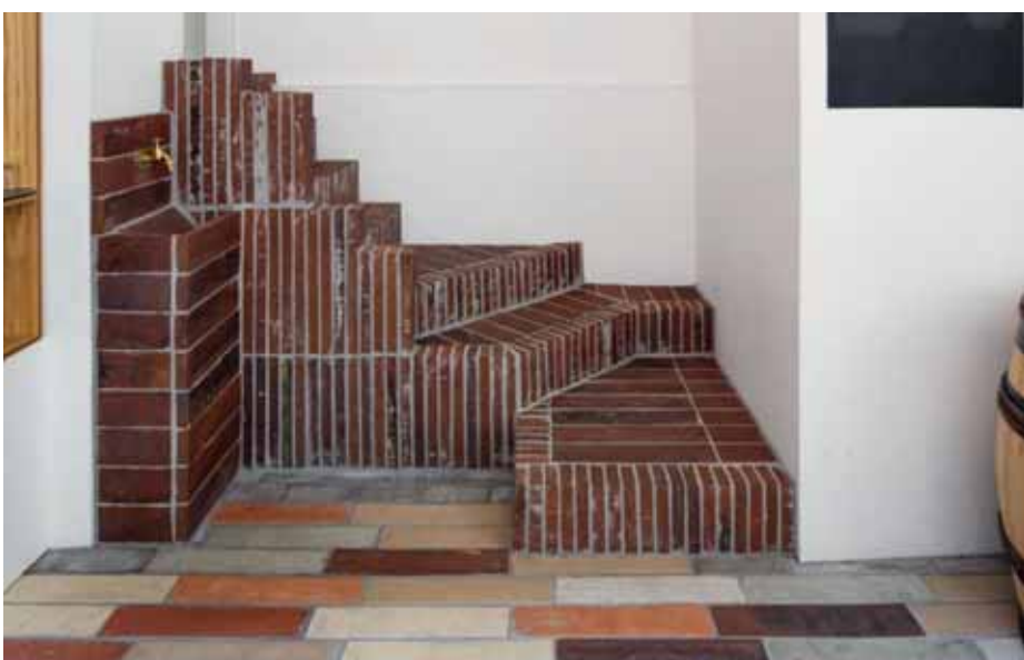
Der Künstler Thomas Poulsen entwarf die Treppe mit dem eingebauten Spülstein aus Kolumba-Steinen, die wie eine selbständige Skulptur im Raum steht.
