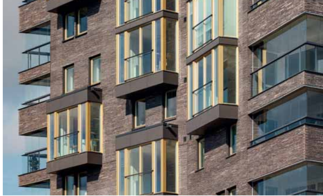
An zwei Ecken befinden sich offene, ausgekragte Balkone, an den beiden anderen trifft Glas ohne Sprossen aufeinander. Beide Lösungen lassen die Ecken schwebend und transparent erscheinen.
