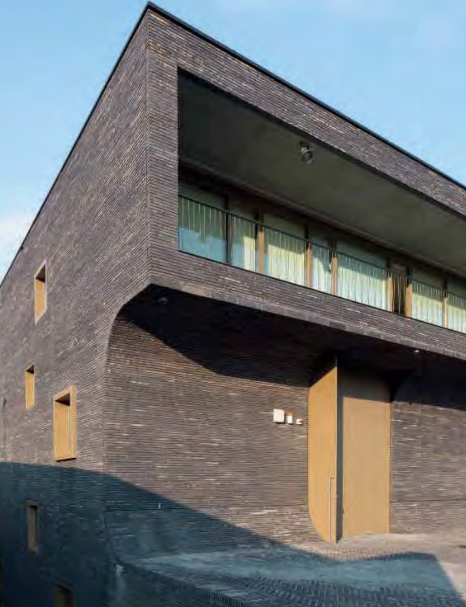
Die Türen und Fenstereinfassungen, beides Sonderanfertigungen aus anodisiertem Aluminium, haben genau den goldenen Farbton, der im Mauerwerk zu ahnen ist.
