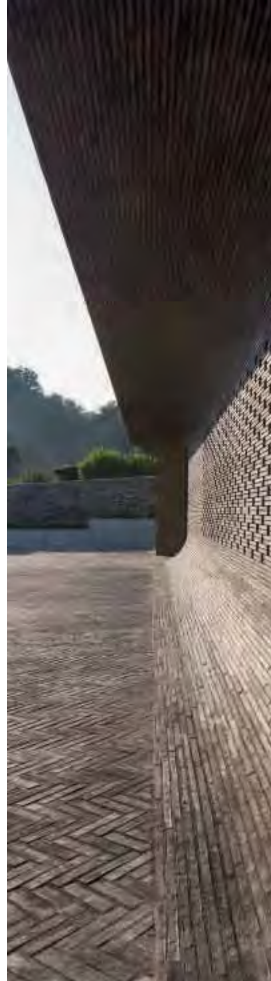
Die dekorative Perforation der Mauer um den nach Nordost gewandten Platz sorgt für Lüftung.
