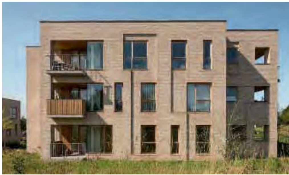
Die Steine der Fassaden wurden in verschobenen Schichten und Linien vermauert und bilden ein abwechslungsreiches, asymmetrisches Muster. Foto: Anders Sune Berg
