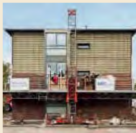
Das Architektenbüro Mangor og Nagel renoviert die gemeinnützige Wohnanlage Sydbyen in Slagelse, Dänemark. Die traditionellen Mauersteinfassaden werden durch den neuen Dach- und Fassadenstein ersetzt.
