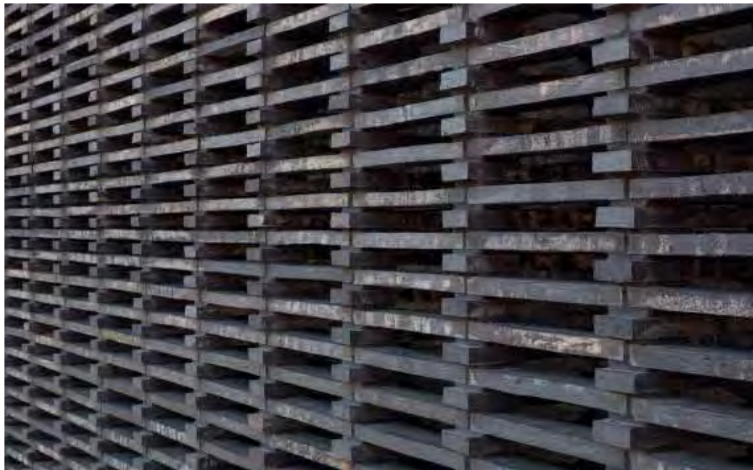
Die Länge des Kolumba-Steins – 58 cm – ermöglicht ein Muster im Mauerwerk, das mit normalen Ziegelstein nicht möglich ist.
