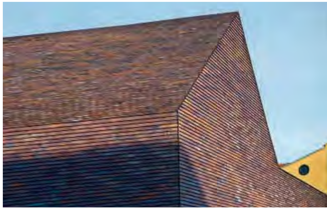
Im Sorø Museum haben Lundgaard & Tranberg es vermocht, die Übergänge so zu bearbeiten, dass Ecken und Giebel von großer Präzision gekennzeichnet sind – trotz der Impräzision der einzelnen Ziegel.
