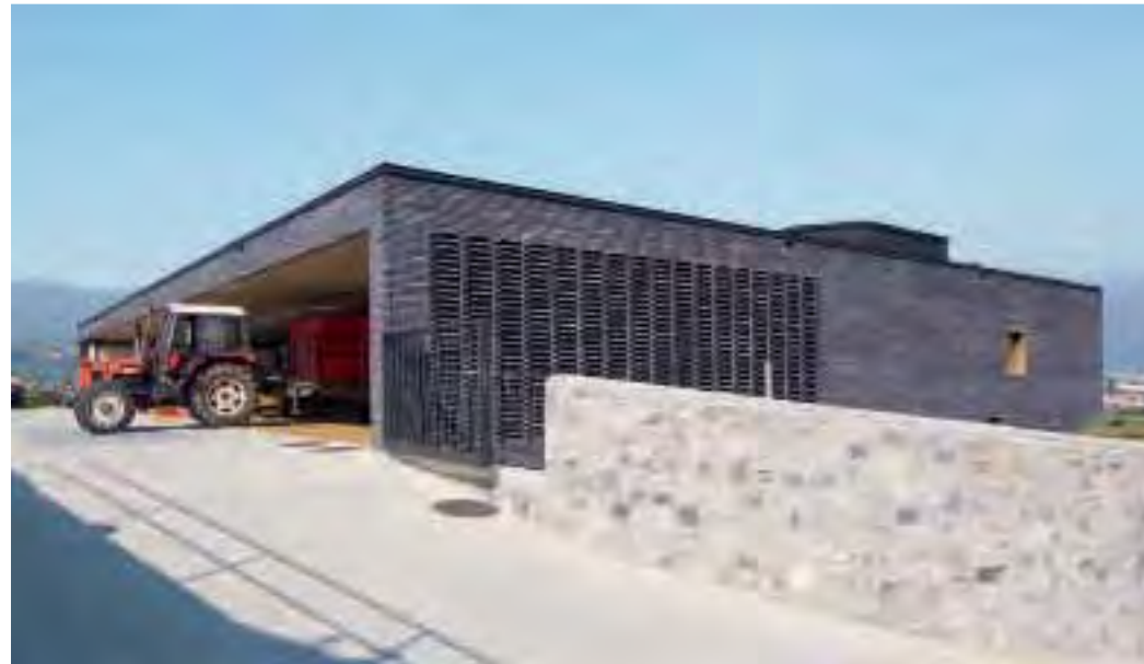
Die perforierten Mauern sind nicht nur schön anzusehen und praktisch. Sie führten dazu, dass der überdachte Vorplatz nicht zur bebauten Fläche gerechnet wurde.
