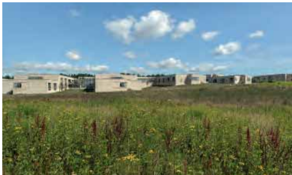
Das neue Pflegecenter wurde mit viel Umsicht auf dem Grundstück platziert und dem Verlauf der Moränenlandschaft angepasst. Foto: Jens Lindhe
