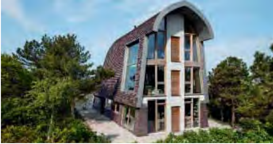
Jetty und Maarten Min bauten ihr Haus im nördlichen Teil der Niederlande ausschließlich aus natürlichen Materialien. Die rotbraunen Nuancen und die raue Oberfläche der eigens für ihr Haus entwickelten Ziegel haben die Farbe von Kiefernrinde.
