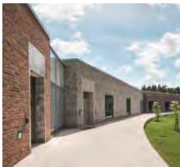
Die Häuser der Klinik werden durch Zwischengebäude aus Glas verbunden.
