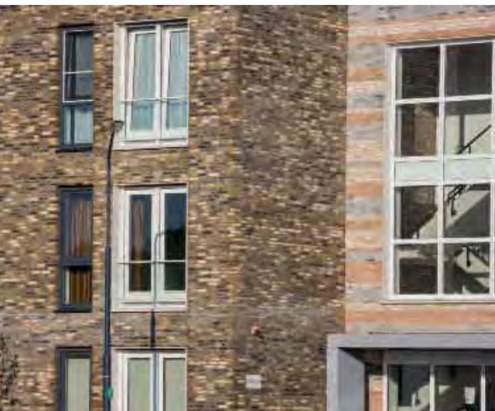
Die Verwendung von Mauersteinen in sehr unterschiedlichen Farbnuancen verleiht der Anlage ein abwechslungsreiches Gepräge.
