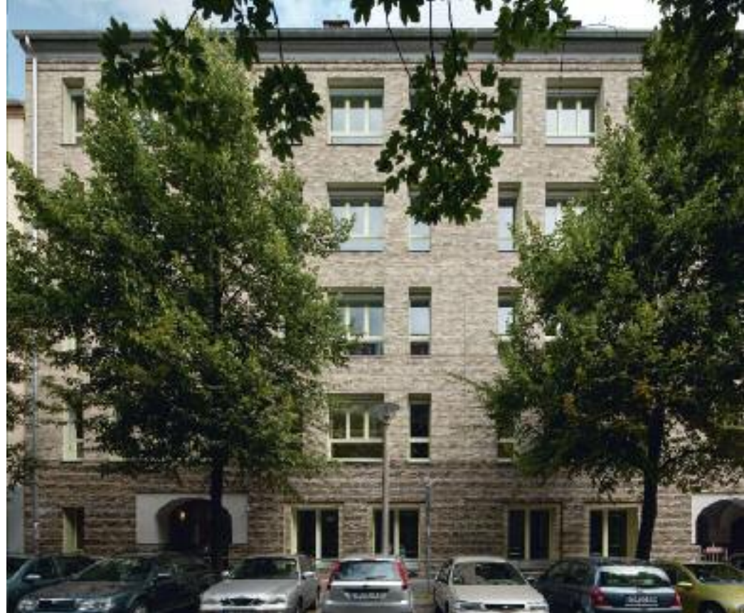
Im Zuge der Renovierung wurden zur Scharnweberstraße neue Schalenmauern vorgesehen.
