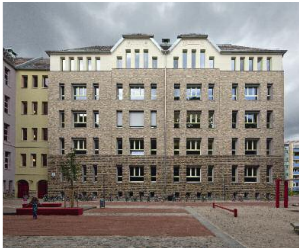
Im Schulhof wurde die Fassade mit den gleichen Steinern verkleidet wie hin zur Straße. Für den Putz der übrigen Fassaden wählte man Nuancen, die sich in den Farben des Mauerwerks wiederfinden.
