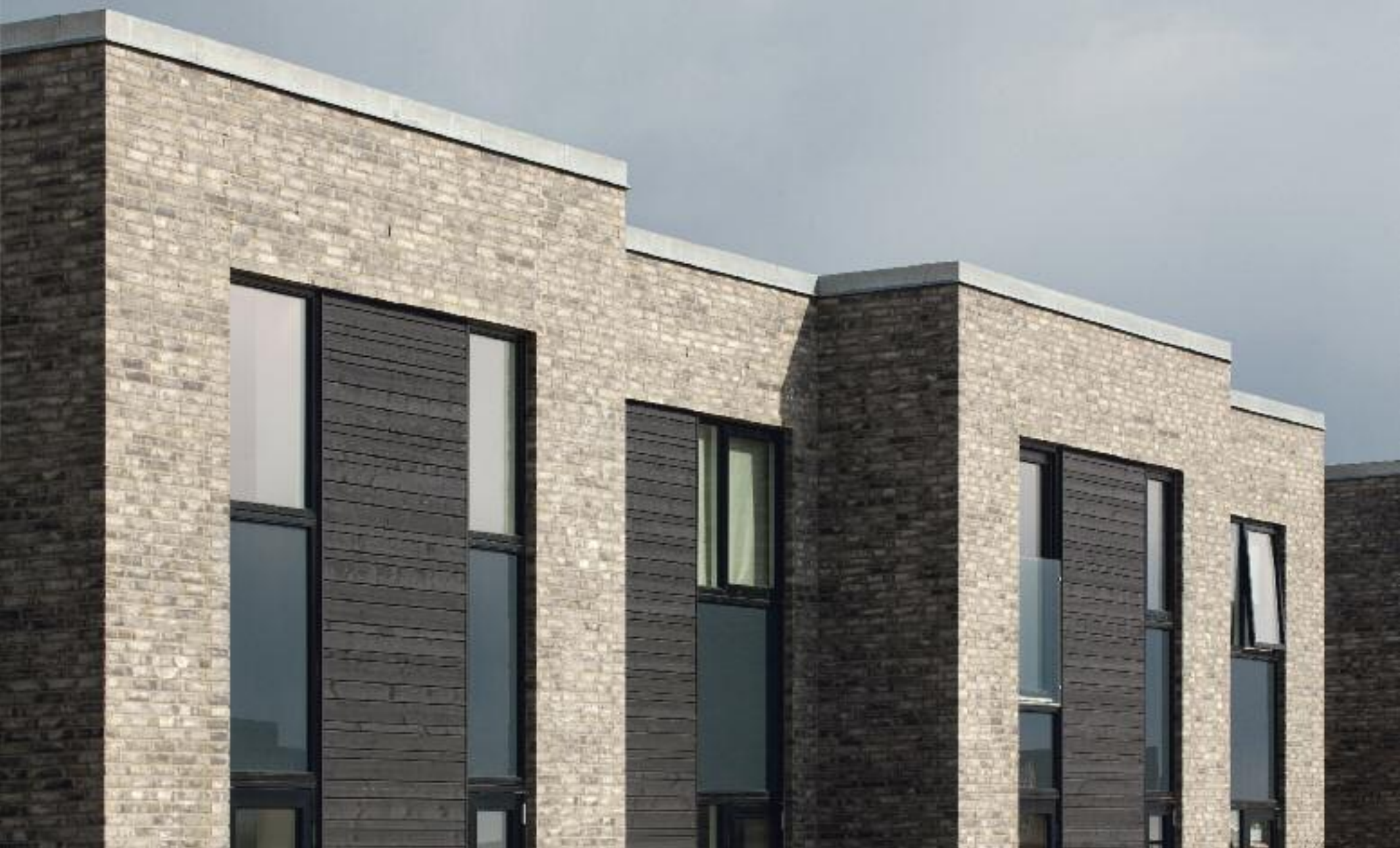
Die Reihenanlage Pilevangen in Solbjerg südlich von Århus wurde mit Fassaden aus blaugedämpften Ziegeln gebaut, kombiniert mit leichten, schwarzen Holzpartien und Alufenstern. Die Wohnfläche beträgt 80 - 114 m 2 . Auch bei der Innenausstattung wurde auf Qualität geachtet.
