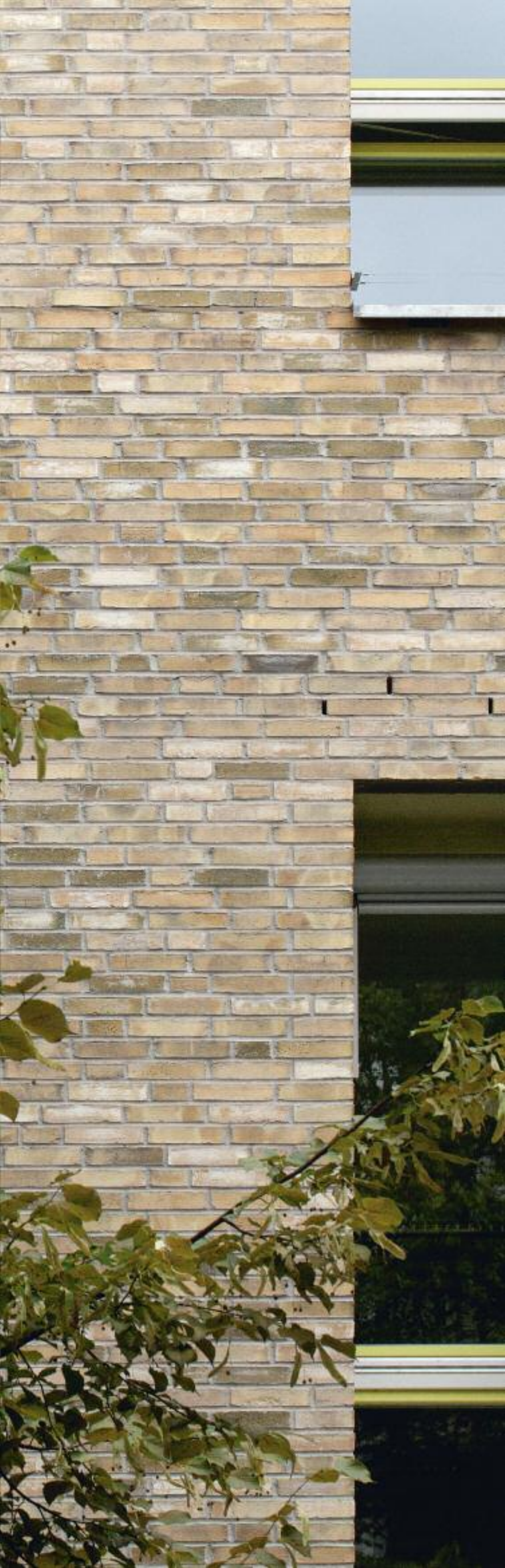
Im Zuge der Renovierung wurden zur Scharnweberstraße neue Schalenmauern vorgesehen.
