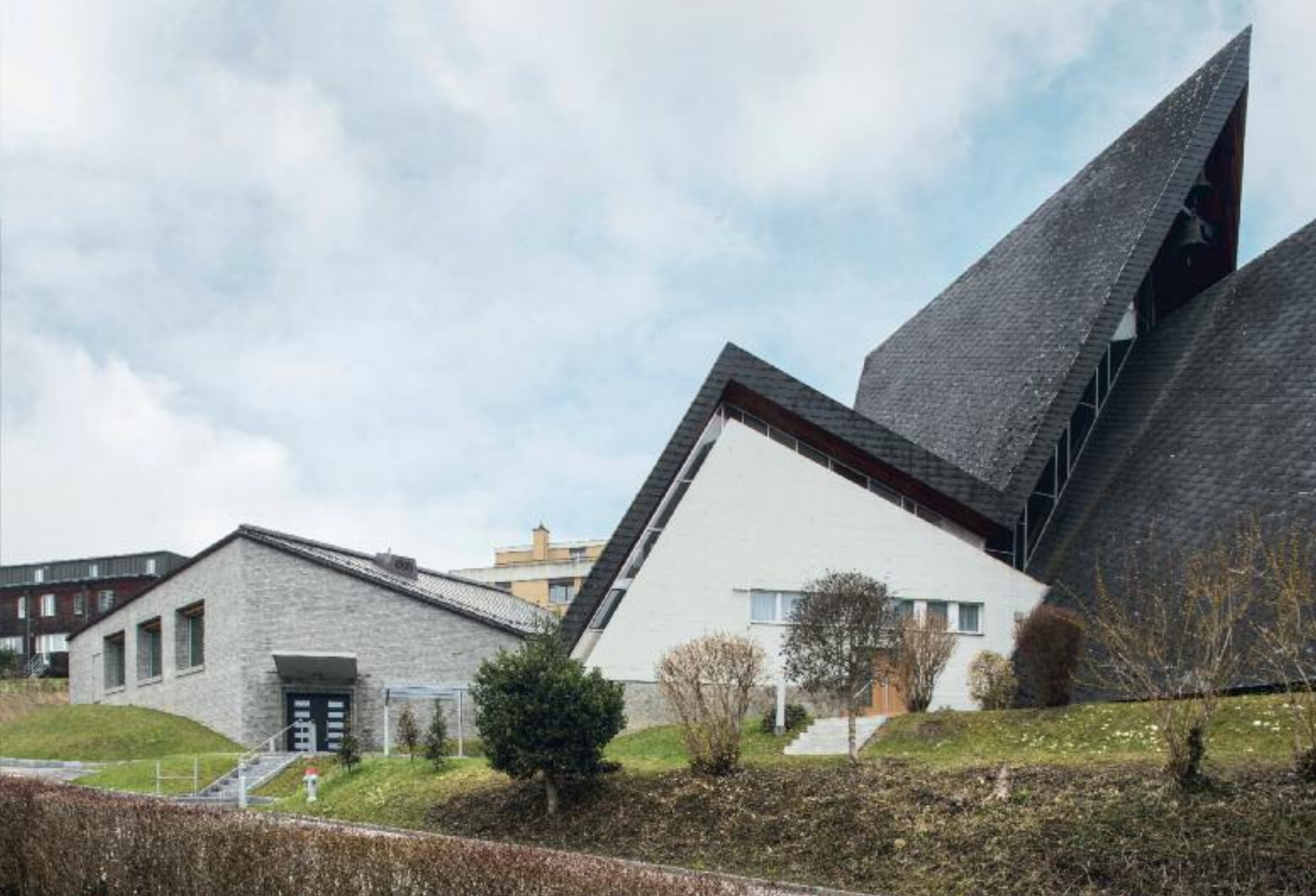
Das kompakte Pfarreizentrum folgt dem Geländeverlauf und erscheint von der Straße und der Kirche aus gesehen als zweigeschossiger Bau. Mit seiner leicht abgeknickten Dachform übernimmt es den Pulsschlag des Kirchendaches.
