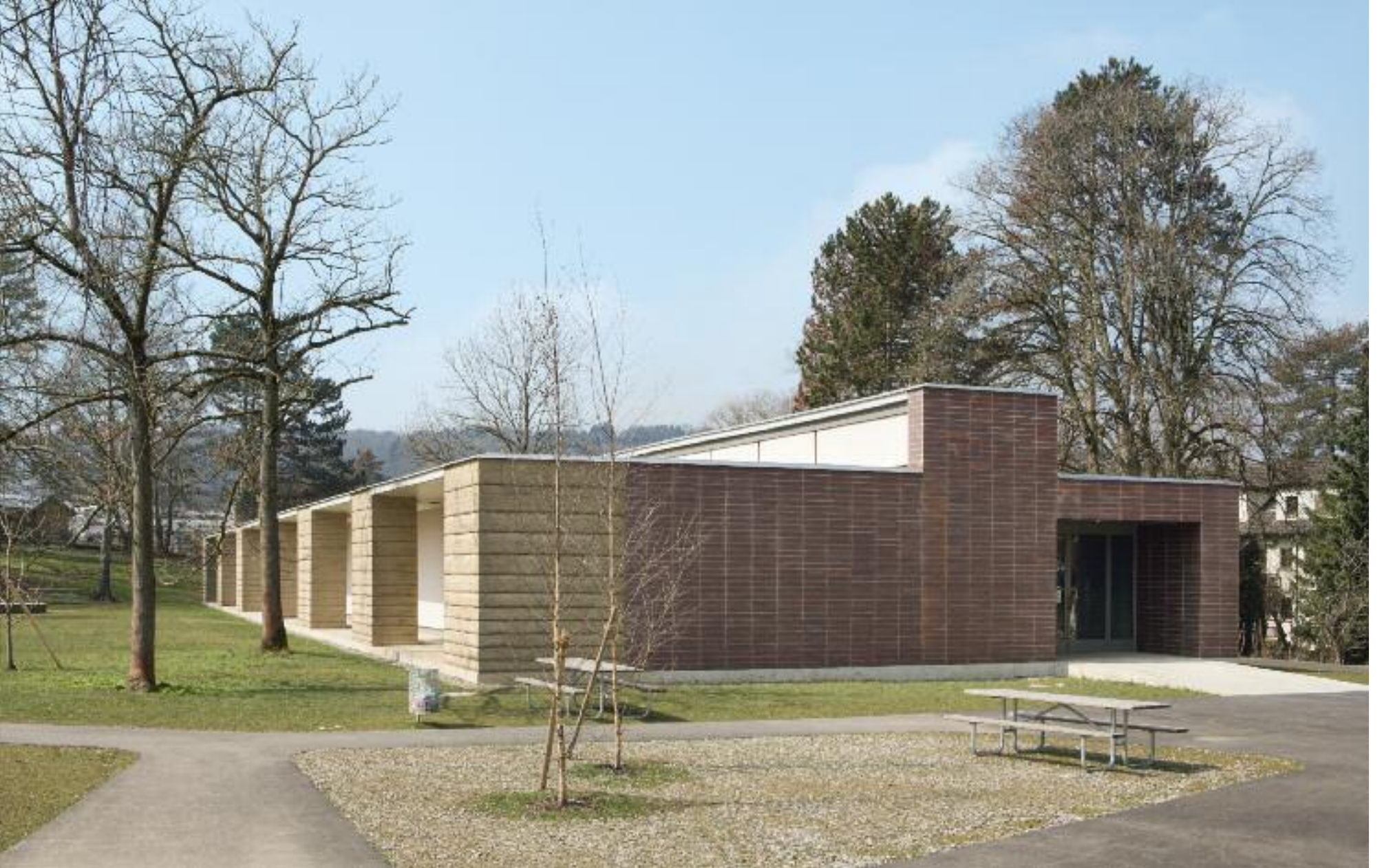
Der Schulpavillon öffnet sich zum Garten hin. Bindeglied ist die von markanten Säulen getragene Loggia. Die Baumaterialien, überwiegend Lehm, tragen zum rustikalen, warmen Eindruck bei.
