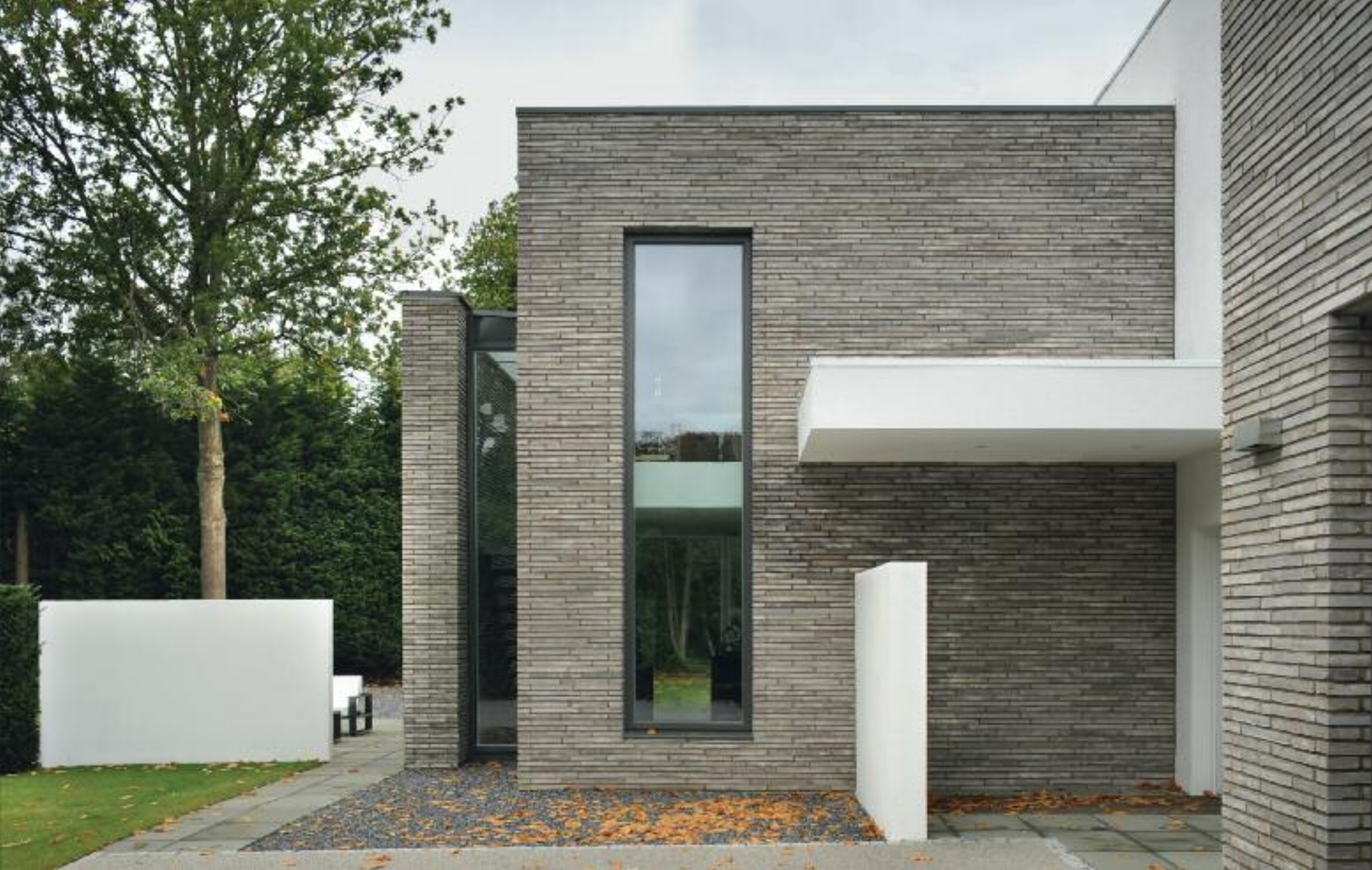
Die Fassade der Villa kennzeichnet weiße, verputzte Flächen und Mauern aus Kolumba. Jede Fassade soll als gleichgewichtige Komposition wirken, deren vertikale und horizontale Flächen versetzt angeordnet sind.
