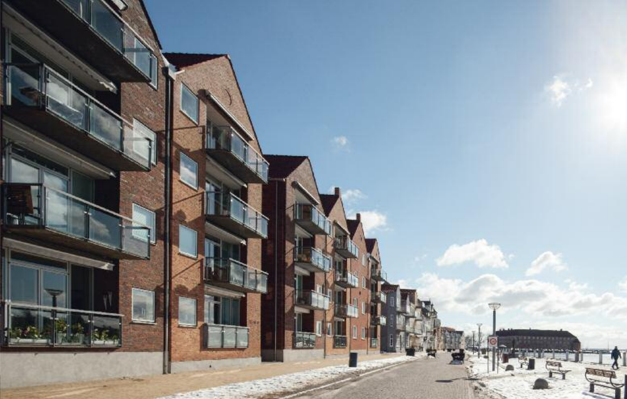
Die Gebäude am Hafenkai wiederholen das Giebelmotiv der übrigen Häuser. Für abwechslungsreiche Fassaden sorgen die verschiedenfarbigen Mauersteine und der Mörtel.
