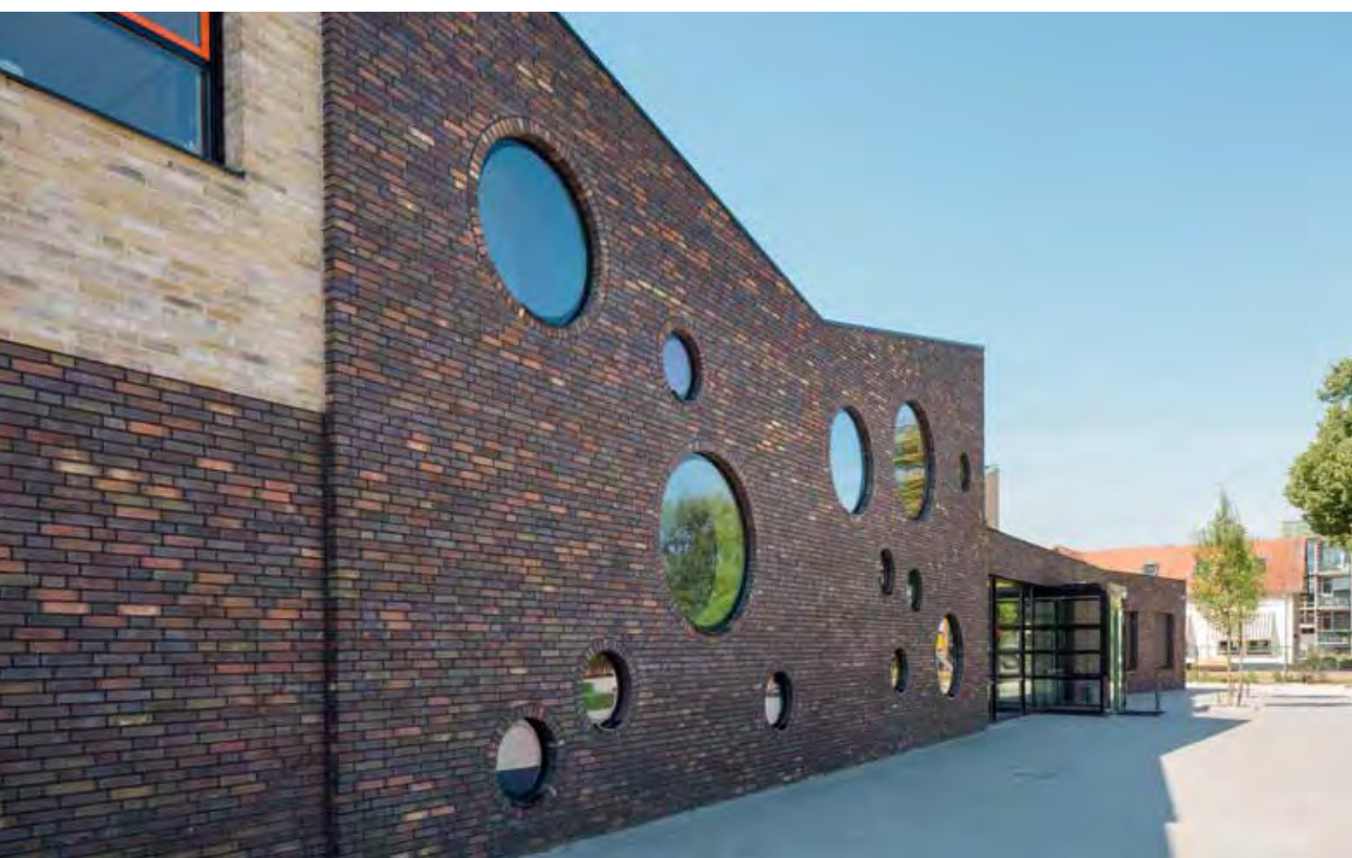
Hinter der nördlichen Fassade mit den an aufsteigende Luftblasen erinnernden runden Fenstern liegt die kleinere Halle.
