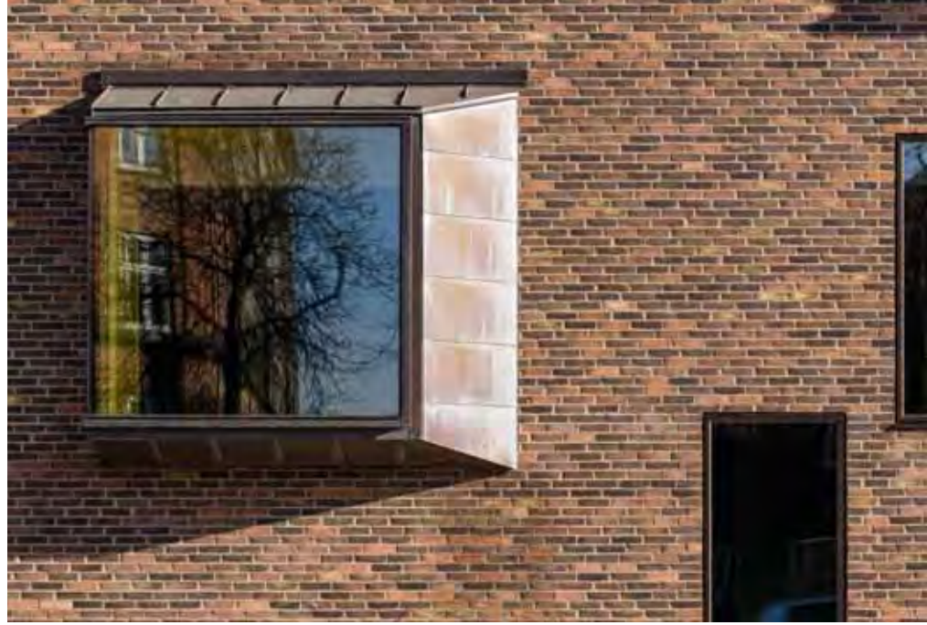
Charakteristisch für das neue, viergeschossige Gebäude sind die mit Kupfer gekrönten Erker an der Nord- und Westfassade.
