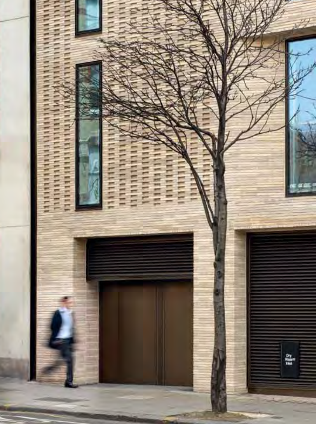
Die handgefertigten Kolumba-Steine sind Unikate, die sich während der Herstellung leicht verwinden und biegen. Beim Entformen bildet sich außerdem eine dünne Lippe entlang einer Kante. Beim Turmill-Gebäude wurden alle Steine mit dieser Lippe nach unten gemauert – dieses kleine Detail verstärkt den einheitlichen Ausdruck mit unterschiedlicher Beschaffenheit.
