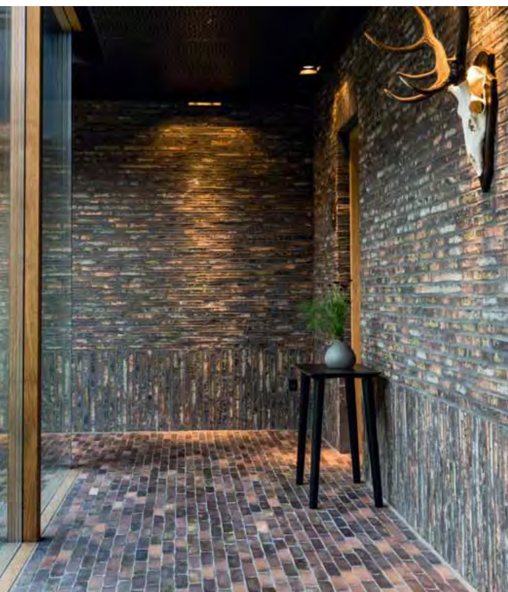
Fassade und Räume des Hauses bilden eine Einheit. Die für die Fassade verwendeten Kolumba-Steine finden sich in den Innenwänden wieder, für die Bodenbeläge wurden im Klinkerbrand hergestellte D48-Steinen verwendet.
