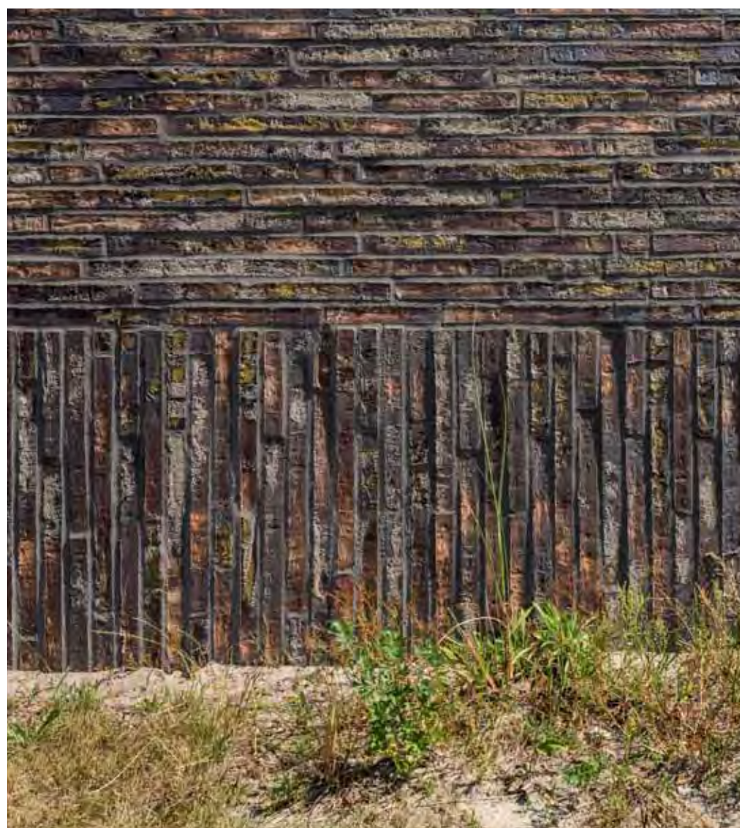
Der gemauerte Sockel liegt direkt auf dem Grund auf. Das Farbenspiel der Steine verstärkt den Eindruck, dass das Gebäude aus der Erde wächst.
