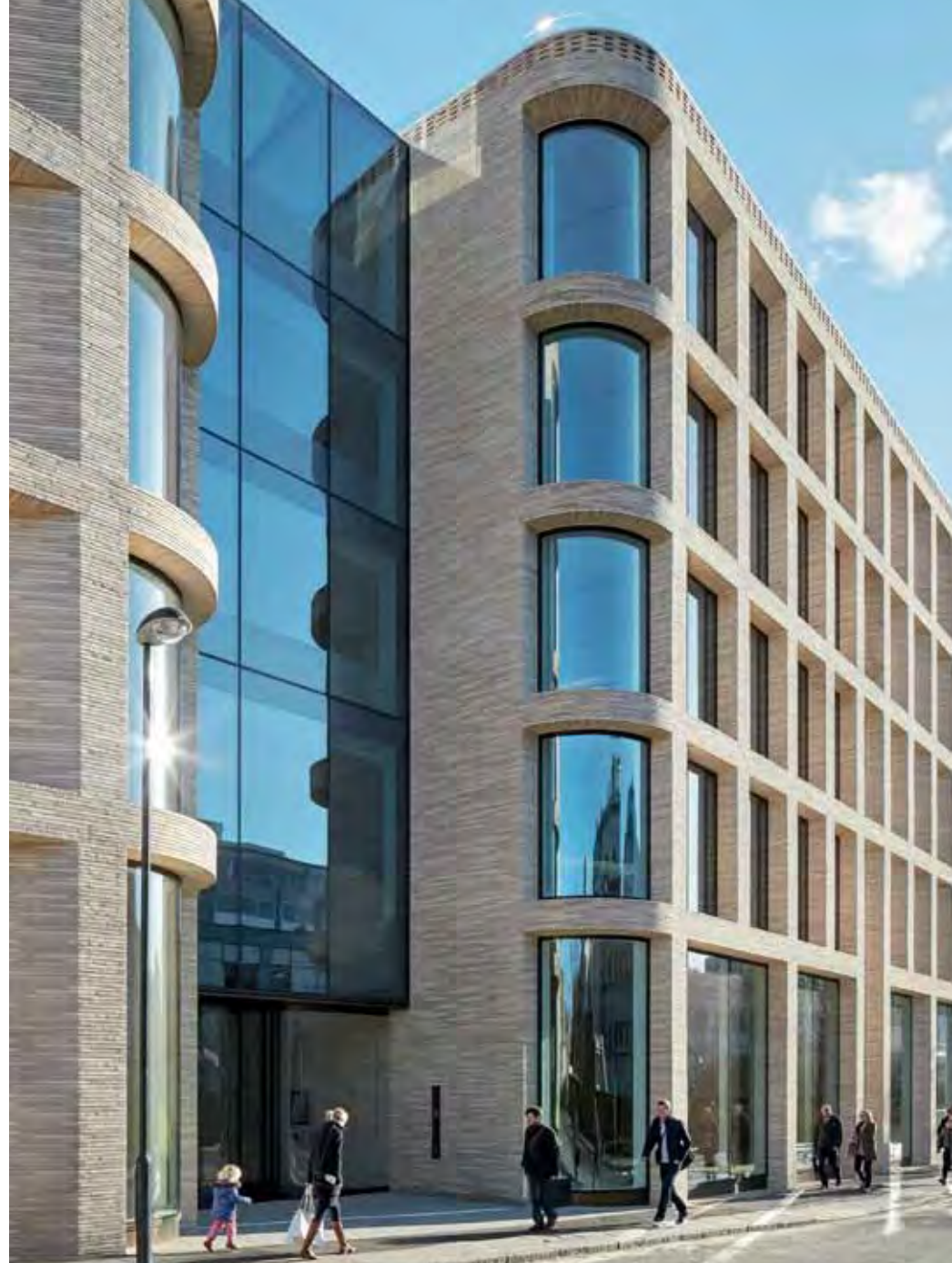
Das 55 Meter lange Gebäude wirkt durch das zentrale Atrium mit Haupteingang in der Mitte der Fassade zweigeteilt. Die gerundeten Eckfenster wiegen jeweils 800 kg und gehören zu den größten ihrer Art in Europa.
