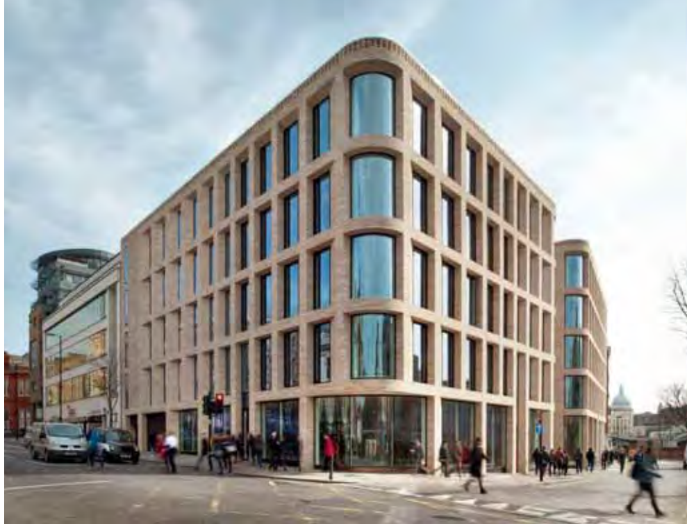
Die zurückgezogenen Fenster verringern zwar die nutzbaren Flächen im Gebäude, das markante Relief macht die Fassade jedoch zu einem Blickfang.
