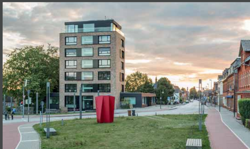
Nach dem Umbau flutet das Licht durch die großen, neuen Fensterpartien in Büros und Treppenhaus. Die dunklen Farben von Dachgeschoss, Sockel und Fensterpartien schaffen eine harmonische Einheit.
