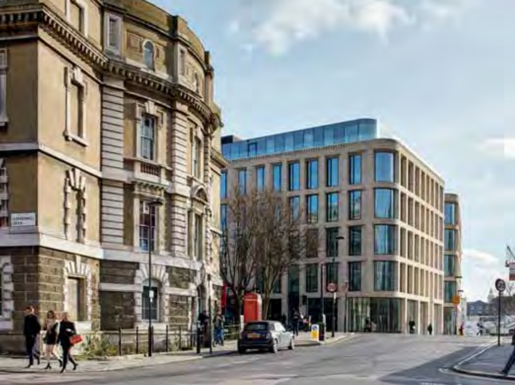
Die Fassade des Session House, 1780, also etwa 10 Jahre bevor Petersen Tegl mit der Ziegelherstellung in Dänemark begann, als Gerichtsgebäude errichtet, besteht aus Sandstein in verschiedenen warmen Grautönen. Sie diente als Richtschnur für die Farbwahl des neuen Gebäudes.
