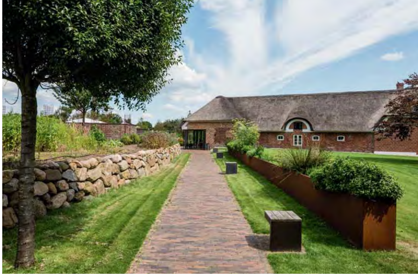
Henne Kirkeby Kro wurde um 1790 als Backsteingebäude aus handgestrichenen roten Ziegeln mit abgewalmten Strohdächern erbaut.
