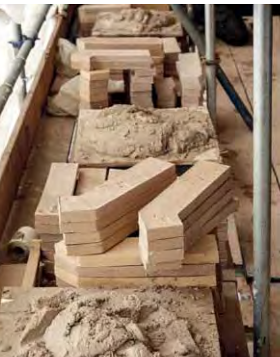
Zur Lösung der zahlreichen anspruchsvollen Teilaufgaben wurden insgesamt 85.890 Kolumba-Steine in 27 Sonderausführungen hergestellt. Mit industriell gefertigten Steinen wäre dies nicht möglich gewesen.
