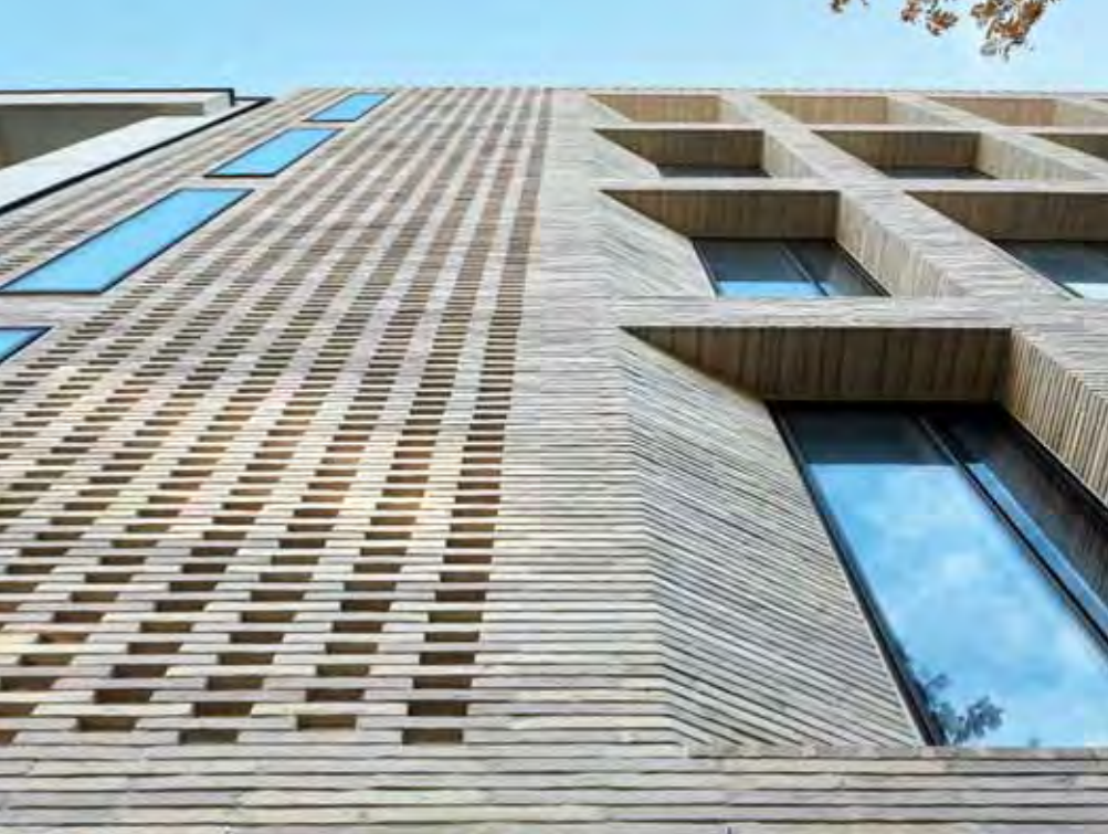
Die eine Seite aller Fensteröffnungen ist abgefast, die Winkel sind durch radiale Linien von zwei Punkten im Inneren des Gebäudes aus festgelegt. So erscheint die Fassade aus bestimmten Winkeln massiv, aus anderen ganz aus Glas. Im Inneren sorgt die Fassade für mehr Lichteinfall.
