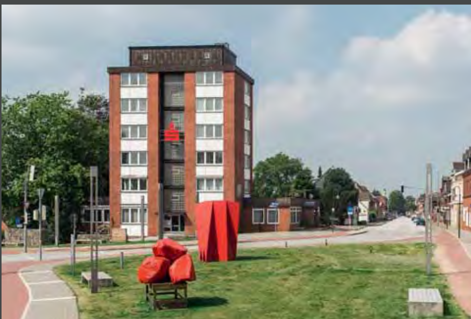
Vor der Renovierung war die Fassade des Käte-Ahlmann-Hauses vertikal unterteilt und von weißen Fensterpartien beherrscht.
