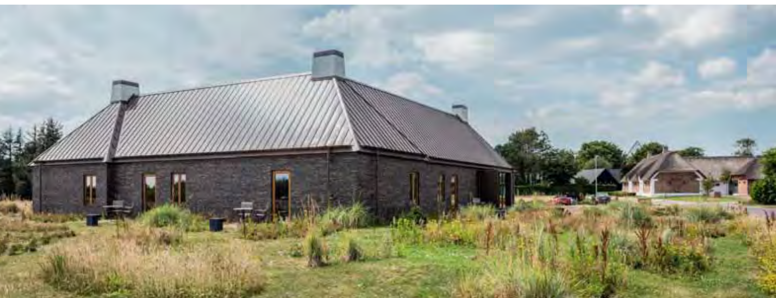
Alle vier Giebelpartien des Hauses schieben sich etwas über die Fassade, sodass das Dach wie ein Walmdach erscheint – wie es für die alten Dünenhöfe typisch ist.
