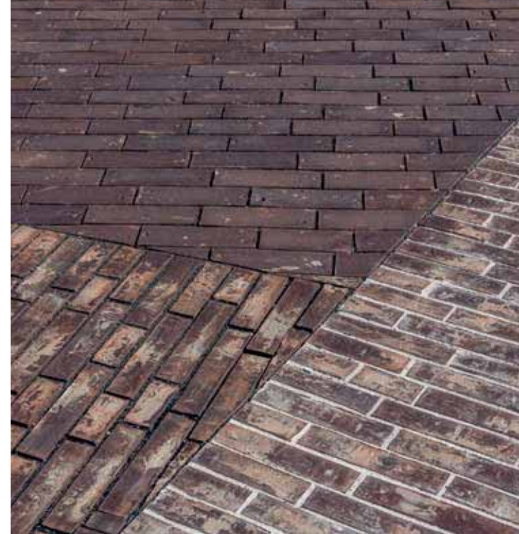
Der Fassadenstein wurde auch auf der Terrasse verwendet, wo er in drei Abschnitte verlegt wurde, jeweils mit einer Konzentration von Lehmschlamm von 30%, 60% und 90%.
