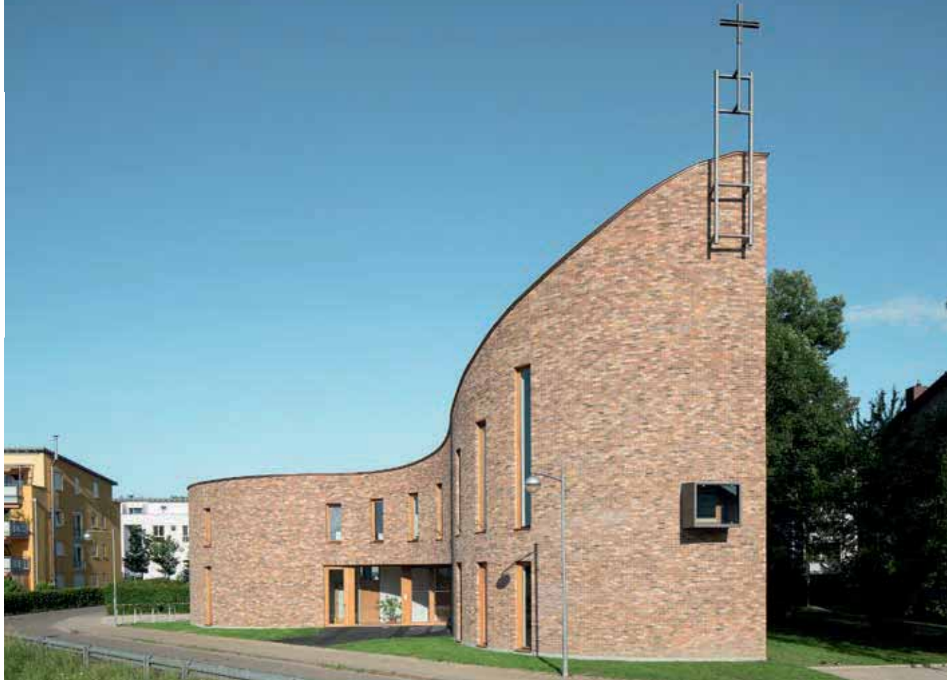
Ein einzelner Verband signalisiert Ruhe, während die Verwendung von Steinen in drei verschiedenen Nuancen der Fassade Stofflichkeit und Farbspiel verleihen. Die Kirchenglocke befindet sich im Fensterkasten platziert. Sie ist von innen wie auch von außen sichtbar.
