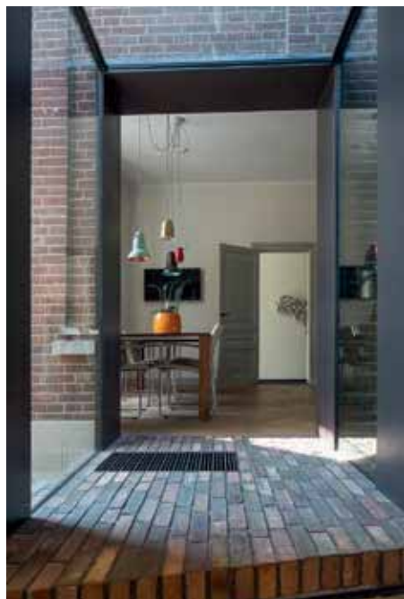
Für den Boden wurden die gleichen roten Kohlebrandziegel verwendet wie für die gemauerten Fassaden.
