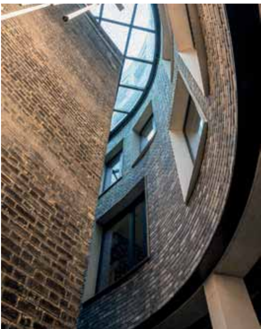
Der gekrümmte neue Raum zwischen The Stanley Building und dem Neubau wurde mit Glas überdeckt.
