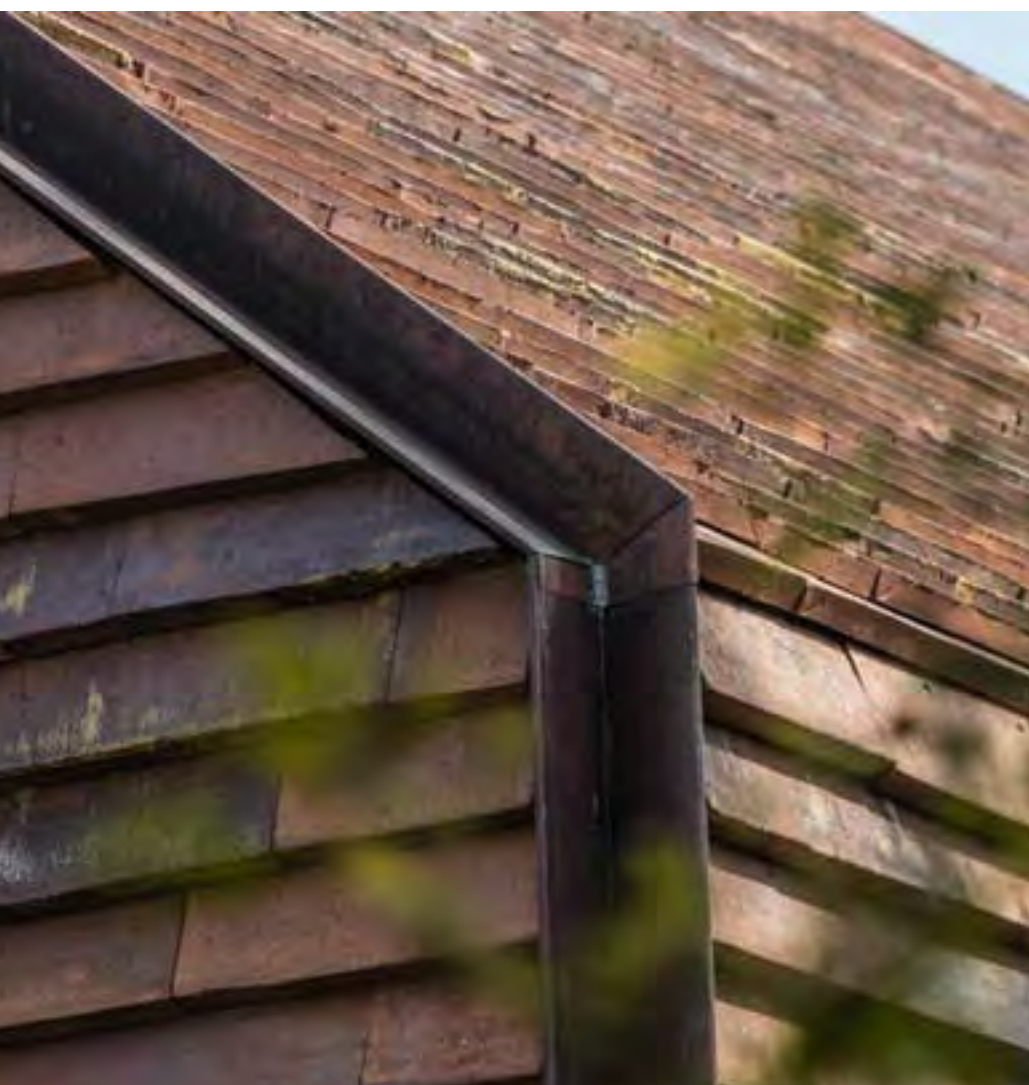
Dort, wo sich Giebel, Dach und Längsfassade treffen, hat Uffe Topsøe-Jensen ein Kupferprofil vorgesehen, auf das die Steine auflaufen.
