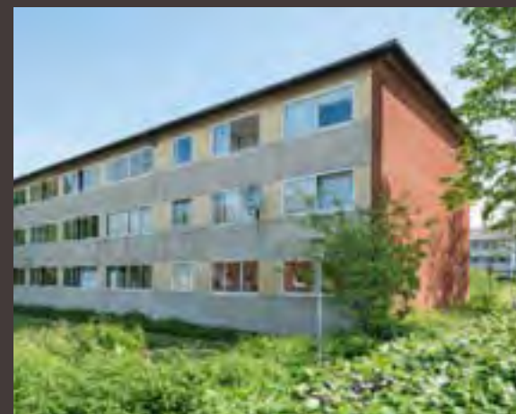
Die Fassaden der Südstadt vor der Renovierung.
