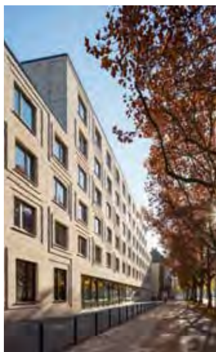
Die Verschiebungen der Fassaden bilden ein mäanderndes Muster um die Fenster des Hotels.
