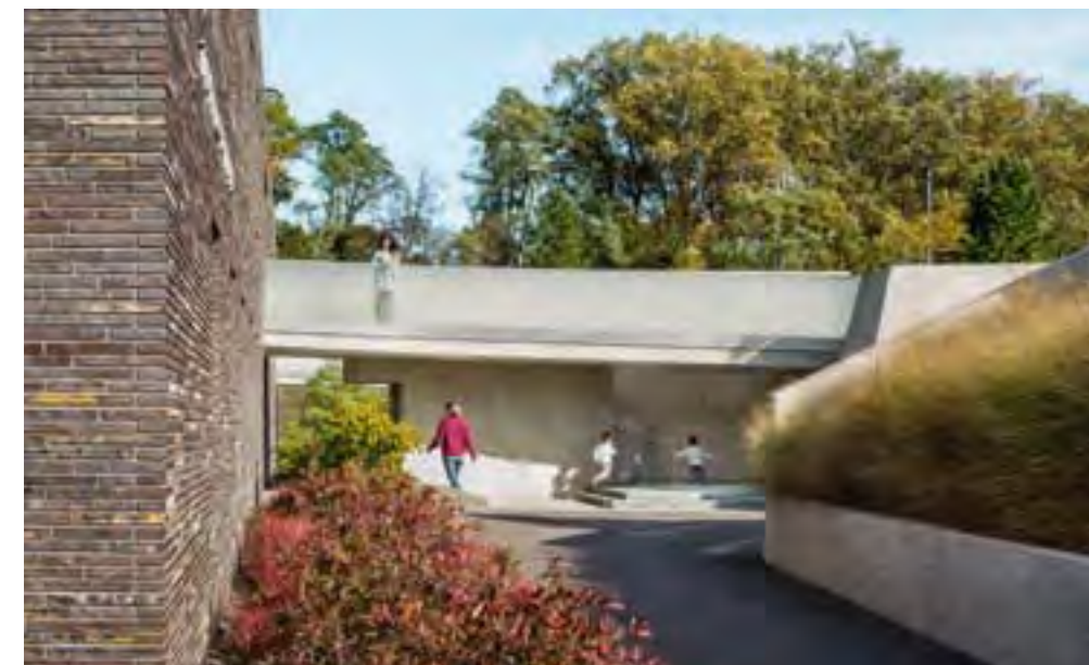
Durch die Außenbrücken konnte auf Fahrstühle und Treppenhäuser verzichtet werden.
