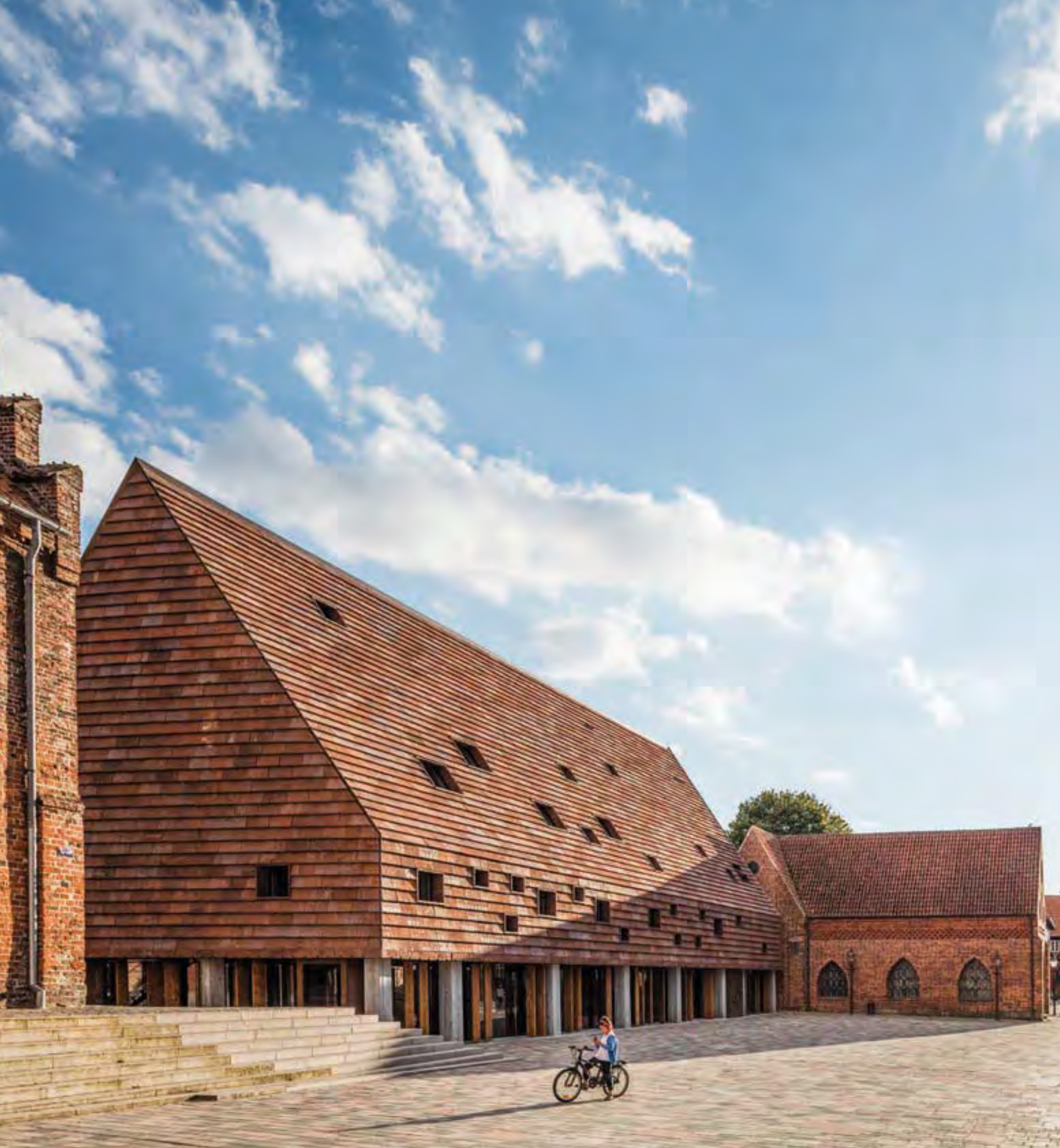
Das Gebäude, ein Langhaus, liegt an der Südseite des Marktplatzes. Durch eine Schleuse ist es mit dem mittelalterlichen Prozessionsgang im Westen verbunden. Das gesamte Erdgeschoss hat eine offene Glasfassade, während die übrigen Fassaden, Giebel und Dächer des Hauses mit den großen Ziegelschalen verkleidet wurden.
