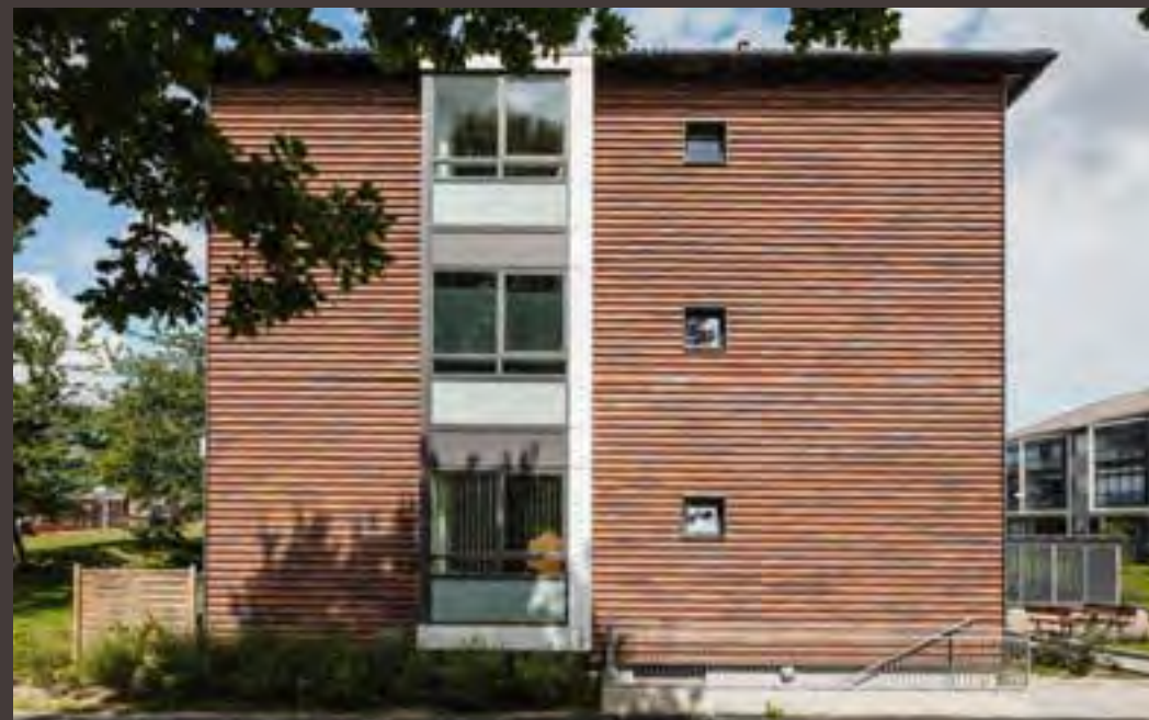
Die Fassaden kombinieren Ziegel von Petersen mit Erkern aus glasfaserarmiertem Polymerkomposit der Firma Steni.
