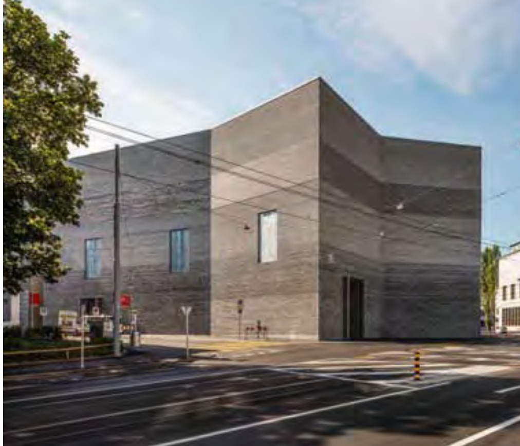
Die markant einspringende Ecke im Volumen des Neubaus ist die Antwort auf die ebenso markant vorspringende Ecke des Hauptbaus, der 1936 von Paul Bonatz und Rudolf Christ, dem Grossonkel von Emanuel Christ, gebaut wurde.
