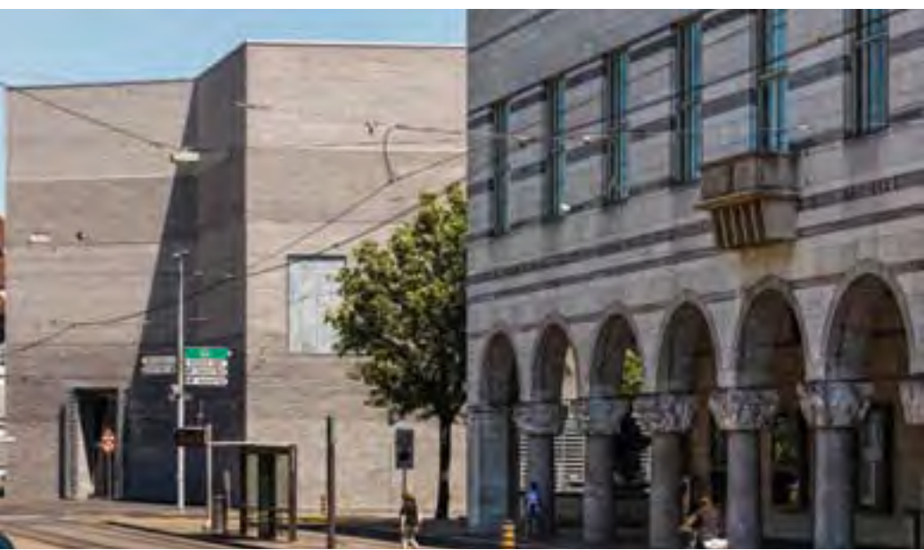
Ähnlich wie die Fassade des Hauptbaus deutet auch die Neubaufassade eine klassische Gliederung von Sockel, Körper und Abschluss an.
