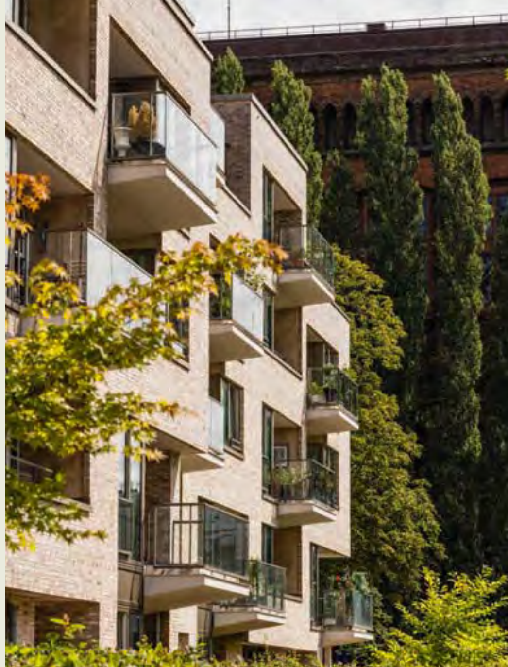
Verschiebungen des Baukörpers und halb ausgekragte Balkone sorgen für variierte Fassaden.
