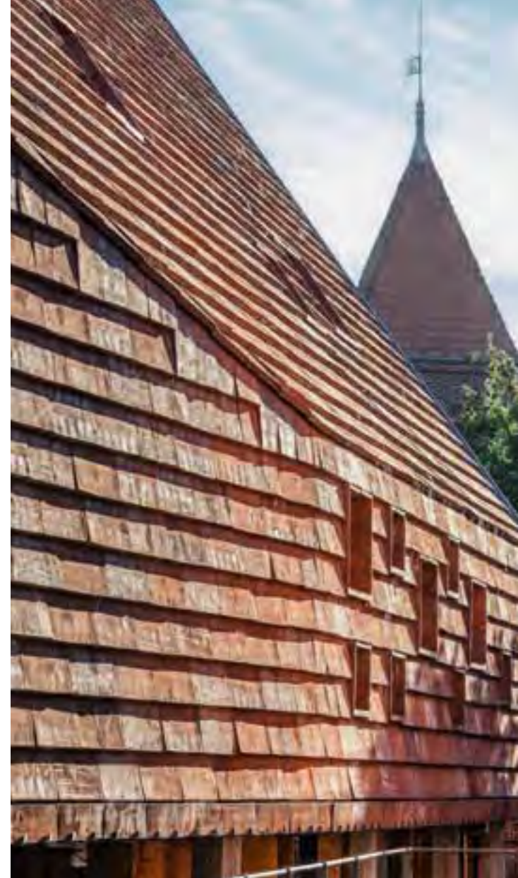
Die Wahl der Größe der Cover Ziegel war entscheidend um entlang des schrägen Dachgrats einen harmonischen Abschluss zu erreichen.
