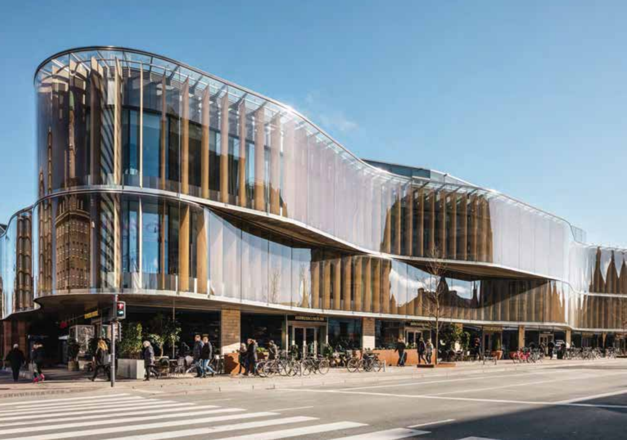
Der obere Teil der Fassaden von „Tivoli Hjørnet“ Bernstorffsgade und Vesterbrogade wurde als zwei wellenförmige Glasbänder mit eingearbeiteten senkrechten Lamellen konzipiert. Die Lamellen können um ihre senkrechte Achse gedreht werden, um so einen Sonnenschutz zu gewähren und Ein- und Ausblicke zu variieren. Das zurückgezogene Erdgeschoss verbindet Glaspartien und breite Säulen. Diese wurden mit speziell gefertigten Kolumba aus dem gleichen Ton wie die Ziegel der Gartenfassade verkleidet.
