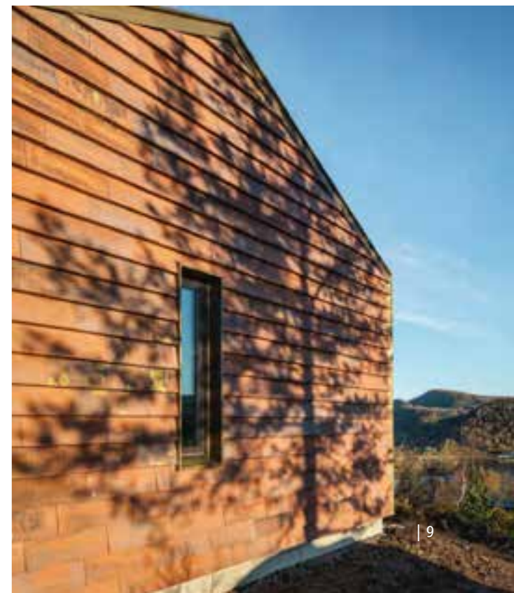
Die Cover wurden überlappend auf die Holzkonstruktion montiert. Die Fassade erinnert an ein traditionelles norwegisches Holzhaus.
