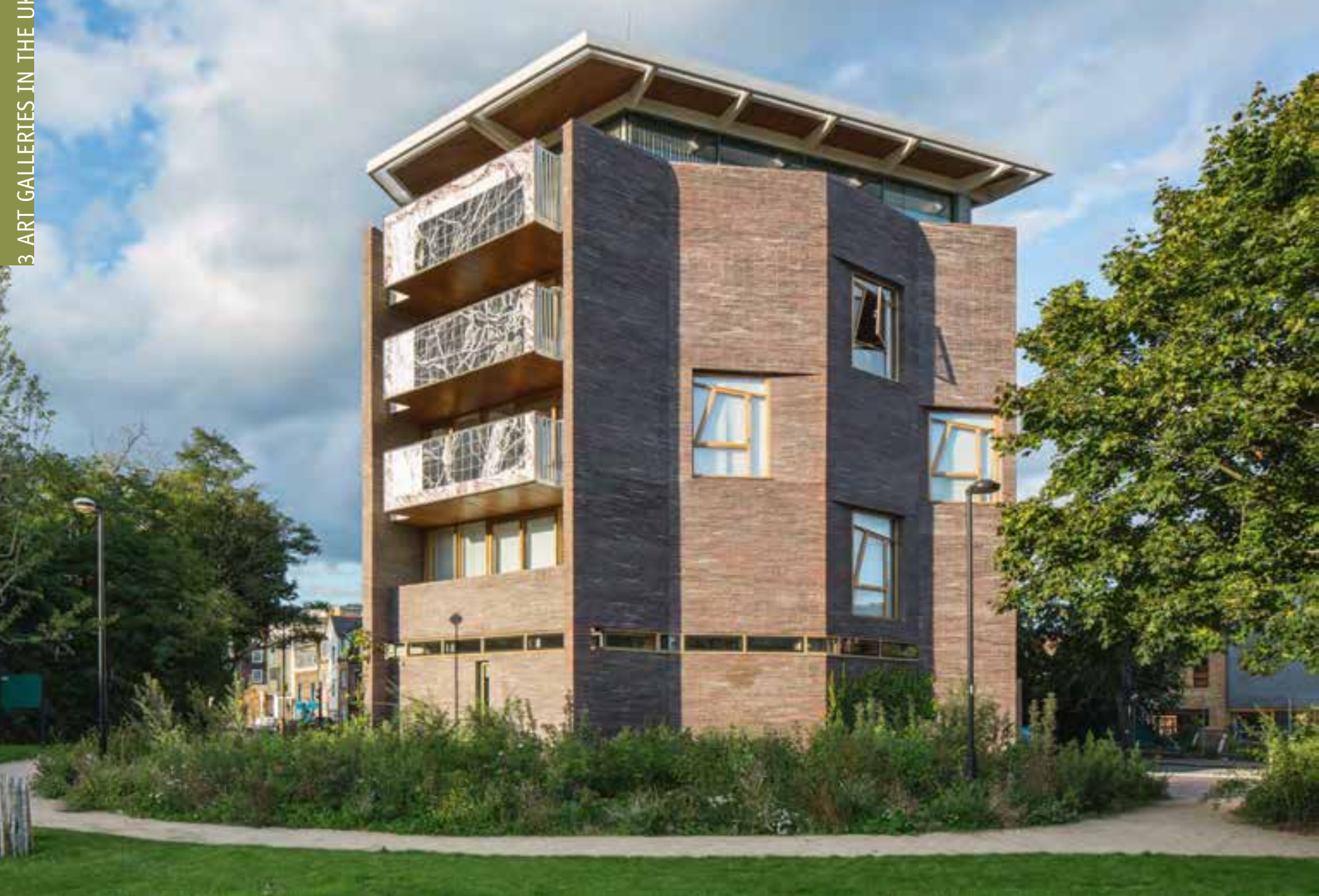
Das zwölfeckige Asprey-Gebäude – ein modernes Beispiel eines Gesamtkunstwerks – wird von gefalteten Ziegelfassaden geprägt, die nach Westen in den großen Balkonen der vier oberen Geschosse Giebel bilden. Das zurückversetzte Penthousegeschoss mit einem Rundblick über London ist für Kunstevents reserviert.
