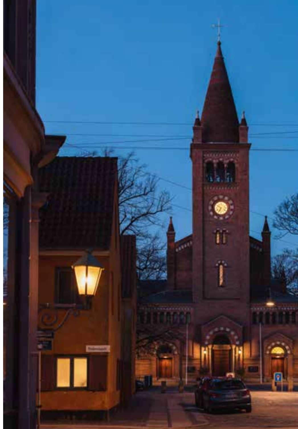
Im Zuge der Restaurierung wurde hinter den neuen gläsernen Zifferblättern der Turmuhren Licht installiert.
