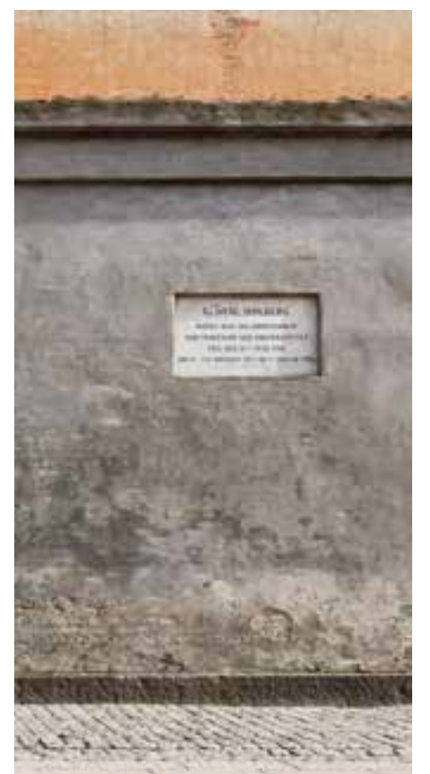
Referenzmauer in der Straße ‚Fiolstræde‘
