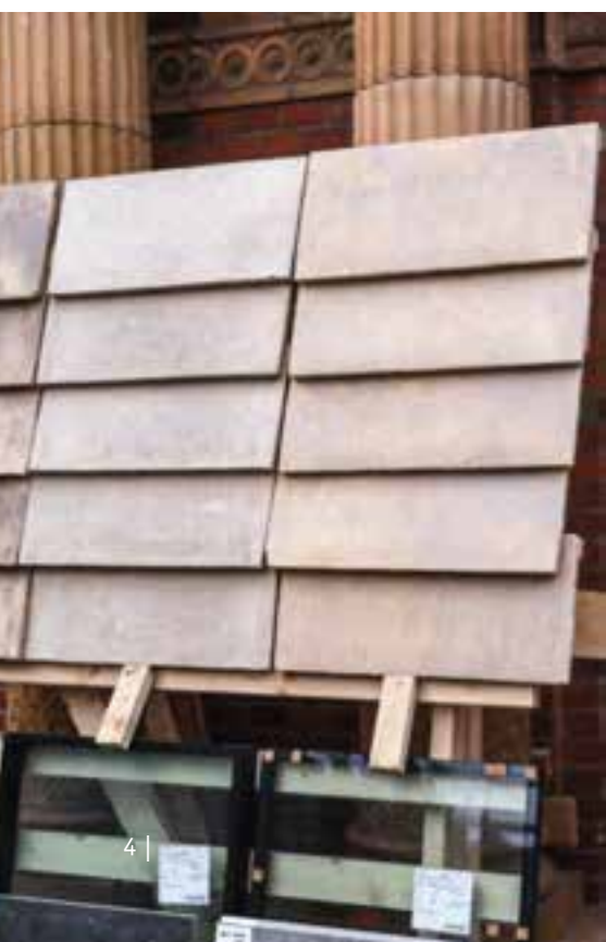
Die Muster des Cover in unterschiedlichen Farbnuancen wurden mit der Terracottaverkleidung des Haupteingangs verglichen.
