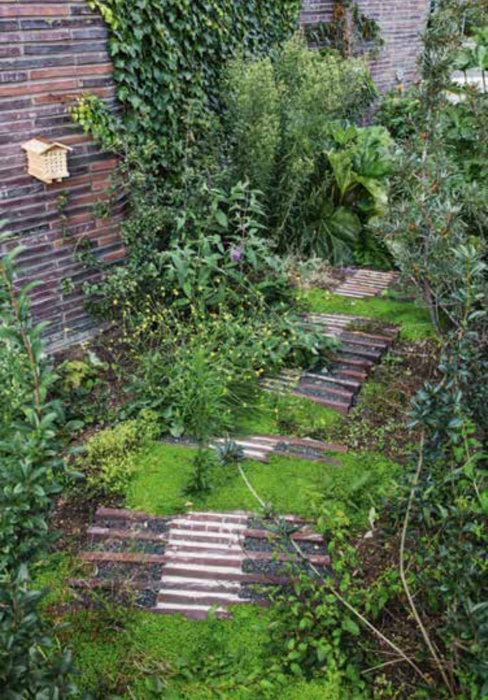
Ein System von kleinen Wegen mit Trittsteinen aus den gleichen Kolumba, die auch für die Fassade verwendet wurden, ermöglicht einen Durchgang durch das leicht kupte Gelände um das Gebäude.
