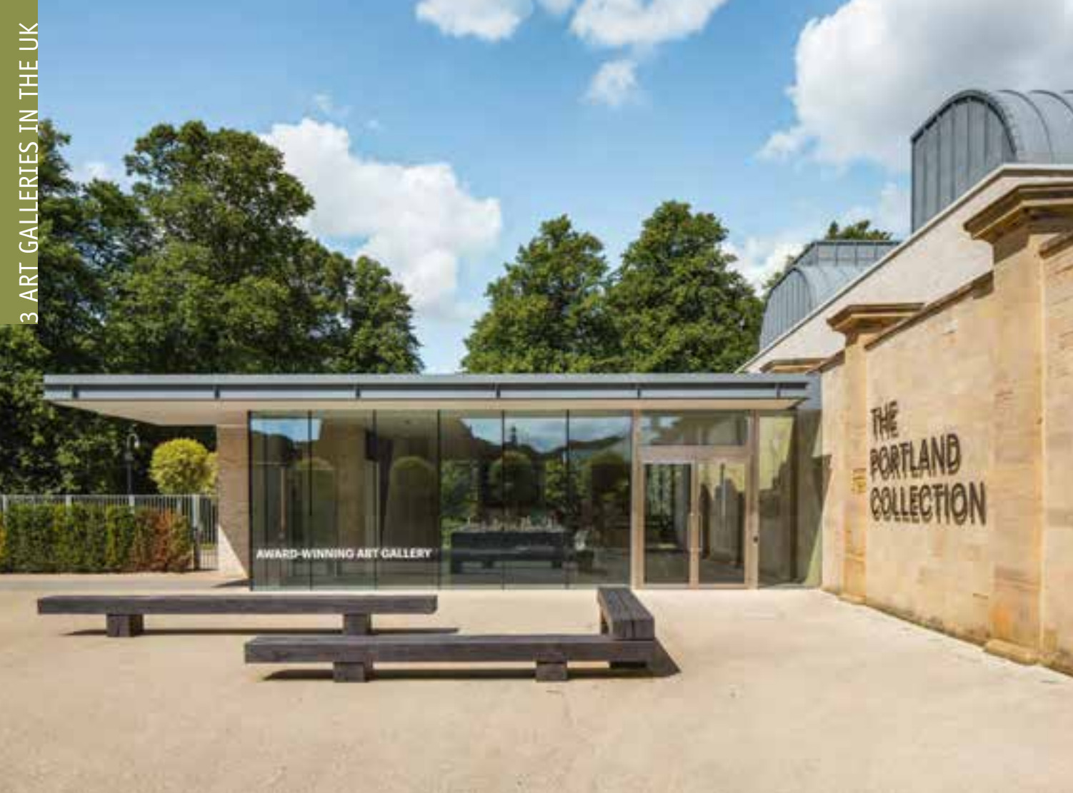
Der Zutritt zur Portland Gallery erfolgt durch einen niedrigen Pavillon mit gemauerten Fassaden aus den gleichen Ziegeln wie das Ausstellungsgebäude. Der Pavillon wurde nicht integriert, stößt jedoch an die Mauer der früheren Pferdetrainingsanlage.
