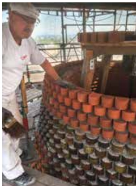
Der Turm wurde mittels eines Maurerzirkels aufgemauert.
