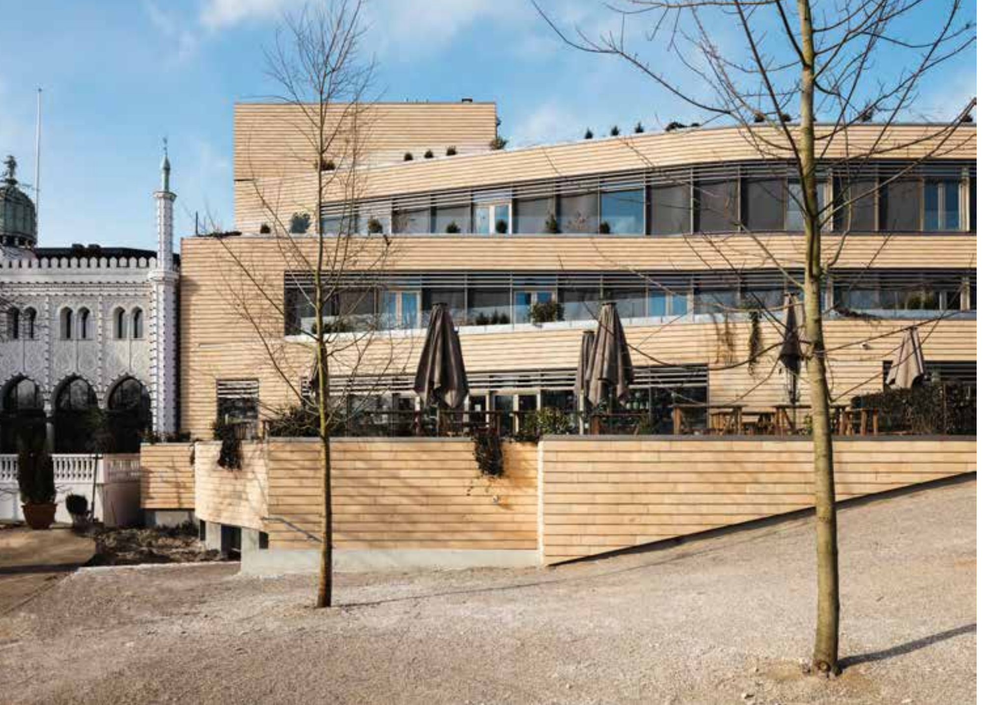
Durch die Ziegelverkleidung in warmen Farbtönen und die zahlreichen großen Terrassen zur Gartenseite wirkt das neue Gebäude freundlich und einladend.
