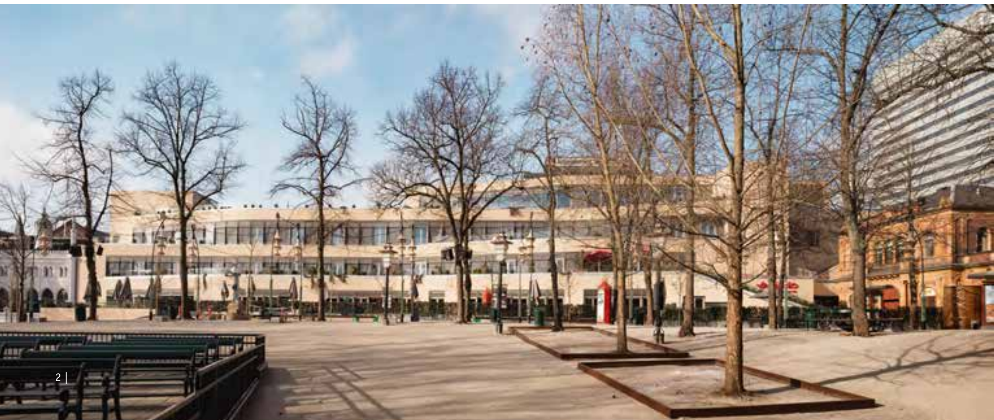
Durch die Unterteilung der Fassade in Terrassen wirkt das Gebäude vom Tivoli aus gesehen niedriger als seine dreizehn Meter. Tivoli und Pei Cobb Freed & Partners wünschten eine Ziegelverkleidung für die Fassade und ließen eine Sonderanfertigung von Petersen Cover entwickeln, deren gelb-grauer Farbton mit den Farben der beiden benachbarten Gebäude harmoniert, des Luxushotels Nimb und des Haupteingangs des Tivoli.
