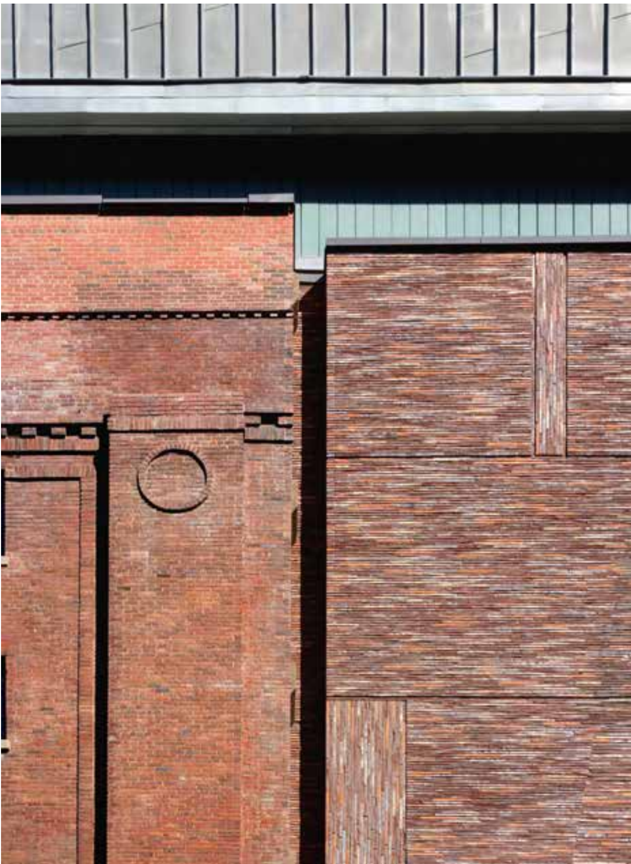
Die beiden Fassaden des Zwischentrakts wurden mit vier verschiedenen Kolumba in einem gedämpften, rot-grauen Farbenmix gemauert und harmonieren mit den Fassaden des alten Industriegebäudes.
