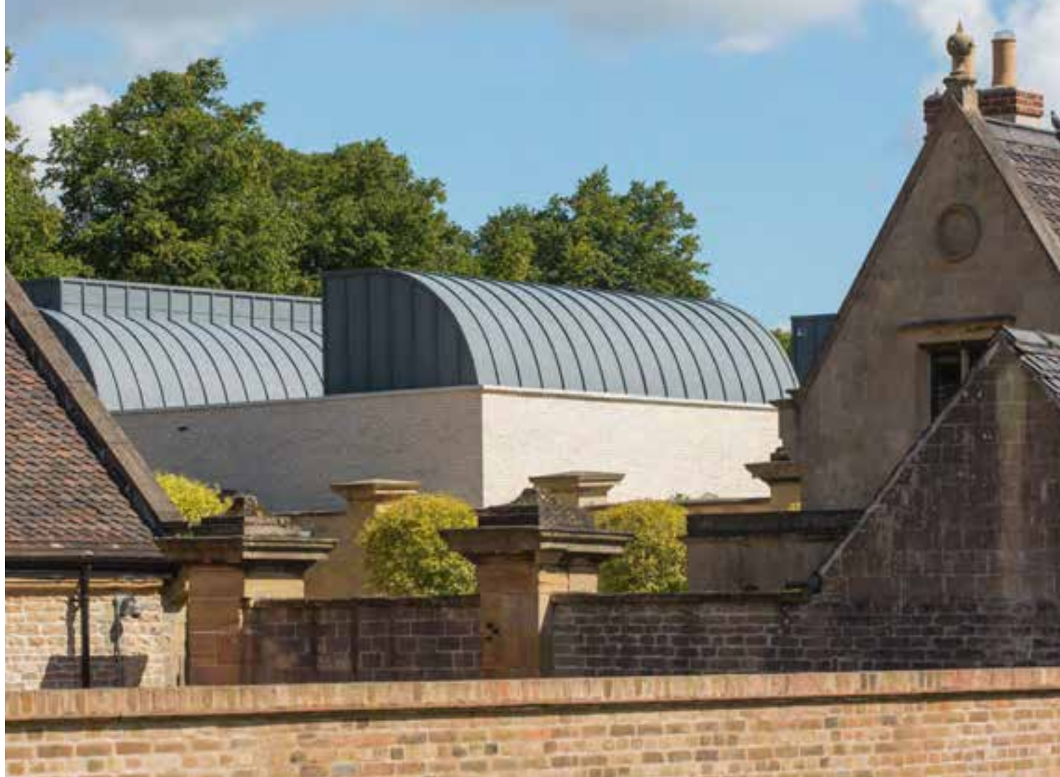
Die Nachbarhäuser der Galerie aus Ziegeln in unterschiedlichen Farben waren ausschlaggebend für die Entscheidung, für den Neubau Ziegelfassaden vorzusehen. Die Wahl fiel auf einen hellen Stein, der mit den historischen Mauern kontrastiert und zugleich harmonisiert.
