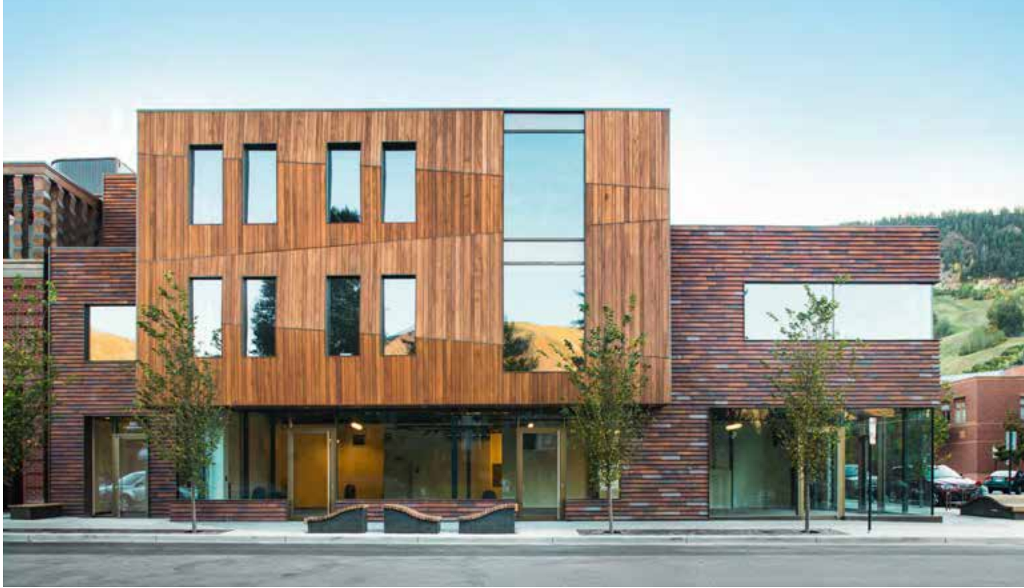
Die Architekten und der Bauherr entschieden sich dafür, Ziegel mit afrikanischem Mahagoni zu kombinieren, dessen warmer Farbton die breite, rostrote Farbpalette des C48 wunderbar ergänzt.
