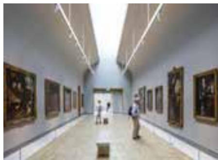
Die tonnenförmige, gespaltenen Deckenkonstruktion lässt indirektes Tageslicht in die Ausstellungsräume strömen.
