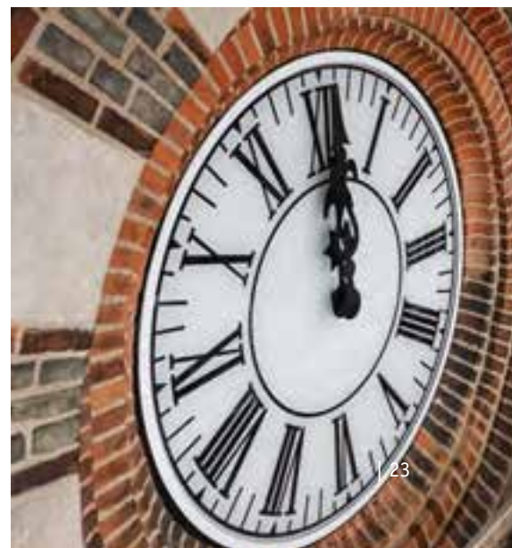
In den Umkränzungen der alten Uhren wurden zum Teil neue Formsteine eingefügt.
