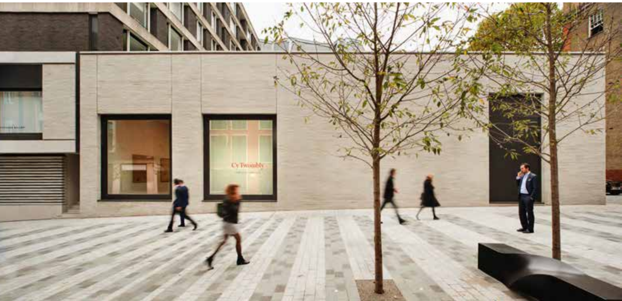
Wohnhaus, Galerie und Parkhaus nehmen zusammen einen ganzen Block in Mayfair ein. Die Galerie im Erdgeschoss und im ersten Geschoss des östlichen Teils des Zwischengebäudes zeichnet sich durch Ziegelfassaden aus, die direkt auf den Granitbelag von Grosvenor Hill treffen.
