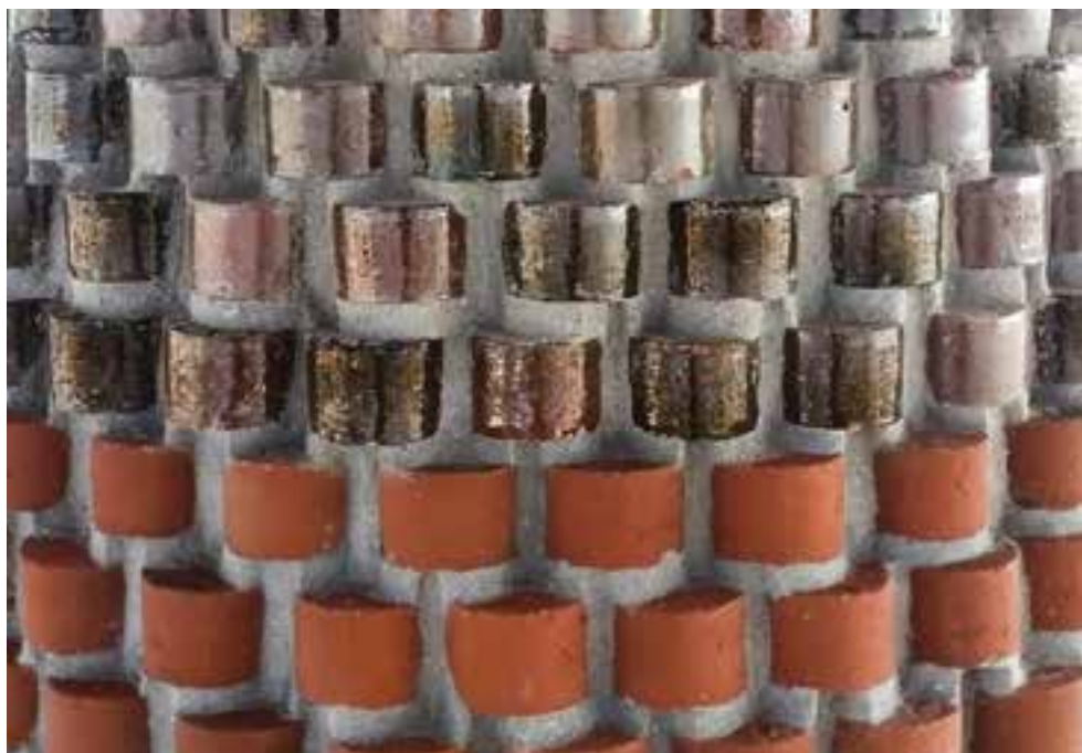
Teil des restaurierten Kirchturms mit glasierten und unglasierten Ziegeln.
