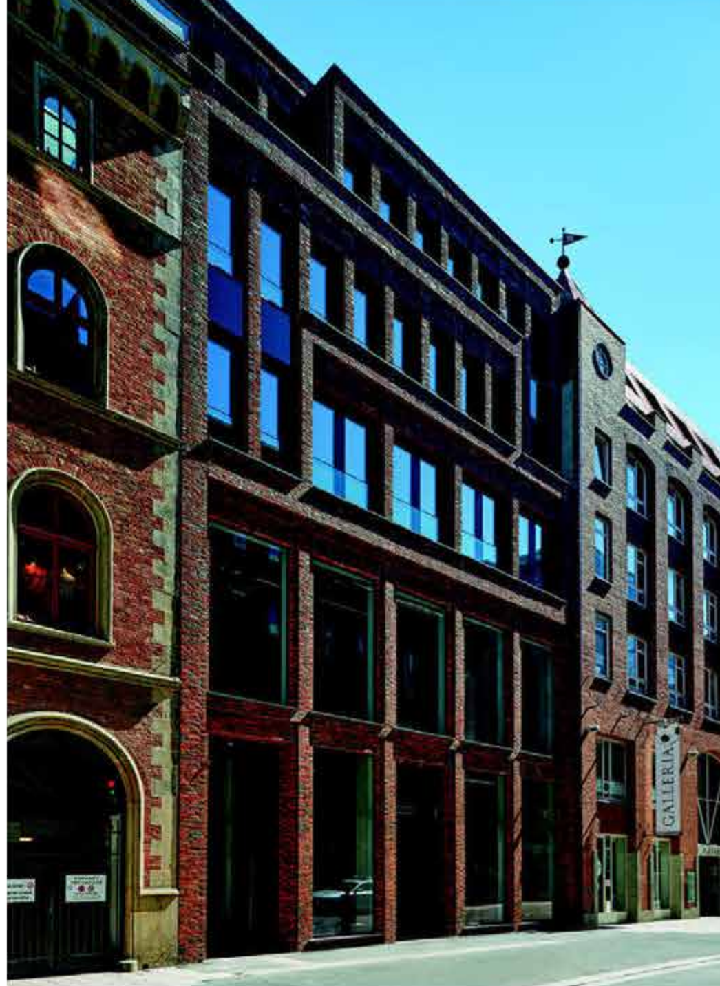
Die der Große Bleichen zugewandten Fassaden wurden nach den gleichen Prinzipien wie diejenige zum Fleet hin ausgeführt. Säulen, mit Ziegeln verkleidete horizontale Gliederungen und große Fenster, die so viel Tageslicht wie möglich ins Haus lassen.
