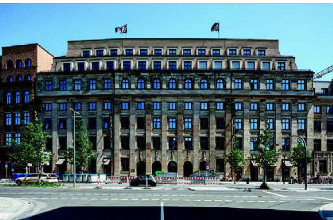
Der Geschossausbau vom Stadthaus wurde von der Fassade zurückgezogen und mit Petersen Cover in hellen, goldenen Farbtönen verkleidet, die sich im originalen Sandstein wiederfinden.
