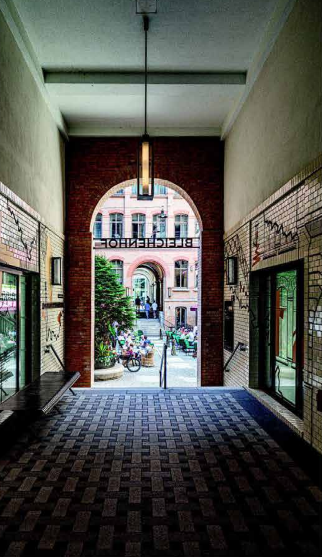
Das Stadthöfe-Quartier zeichnet sich durch die hohe Qualität von Materialien und Bauhandwerk aus. Die Wände der Passagen wurden mit glasierten Klinkern geschmückt, und die Böden zieren matte, in dekorativen Mustern verlegte Natursteinplatten.
