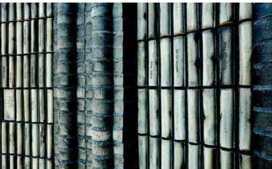
Runde Formsteine bilden das Innere der Bibliothek und teilen die Wände in »Regale« mit angeordneten »Büchern« auf. Die Bücher, gebrannt in helleren Farbtönen, wurden in neun Schichten übereinander gestapelt.
