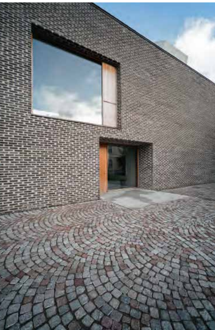
Die hier gebräuchlichen Kopfsteinpflastersteine aus Granit treffen ohne Übergang auf die Fassaden aus dunklen, wassergestrichenen Ziegeln.
