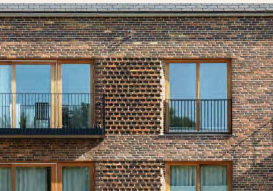
Die Neubauten zeichnen sich durch knappe Profile und Dächer ohne Überstand aus. Es wurden ausnahmslos natürliche Materialien verarbeitet: Gemauerte Fassaden, Schieferdächer sowie Fenster und Türen aus Eiche.
