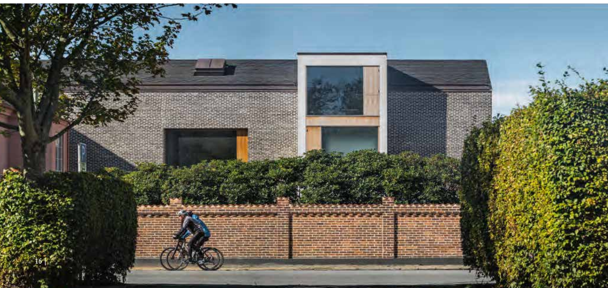
Der Anbau wurde als moderne Interpretation eines klassischen Langhauses der Region Schonen konzipiert. Die dunkelgrauen Fassaden harmonieren sowohl mit der rosa verputzten Fassade des Hauptgebäudes als auch mit der roten Ziegelmauer, die der Straße zugewandt ist.
