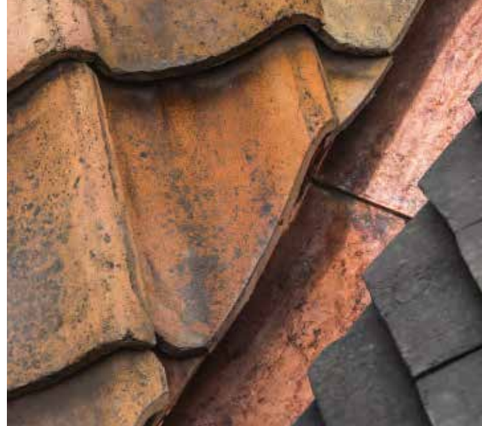
Zusammen mit Petersen Tegl entwickelten die Architekten den dunkelgrauen, handgefertigten Dachziegel mit den Maßen 265 x 182 x 20 mm.
