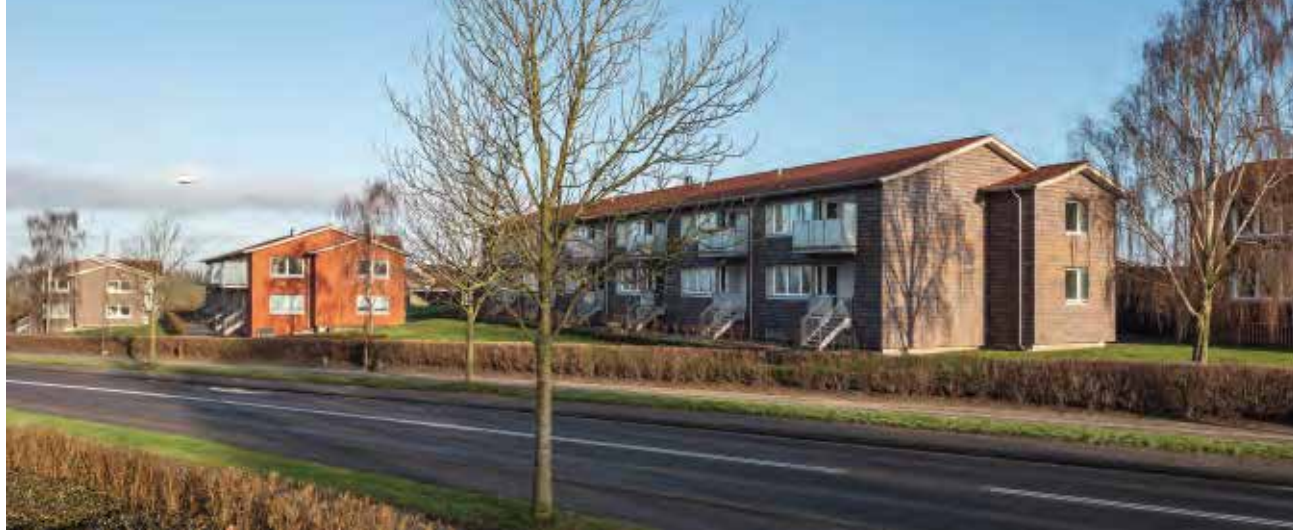
Die Wohnanlage Ringbakken besteht aus vier niedrigen Wohnblöcken, die von einer zur Anlage gehörenden Grünfläche umgeben sind. Die Renovierung der Fassaden verleiht der Anlage einen modernen, qualitativ hochwertigeren Ausdruck.
