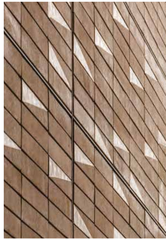
Der Metro-Stein, ein geringfügig geänderter, handgefertigter Kolumba, ist an einer leichten Stahlkonstruktion befestigt, hinter der sich die umfassende Kabelführung verbirgt.
