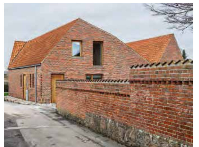
Für das in Vollmauerwerk ausgeführte Gemeindehaus entschieden sich die Architekten und der Bauherr für einen Kohlebrandziegel, dessen rote, graue und braune Farbtöne sich auch in der Kirche und der Friedhofsmauer wiederfinden.
