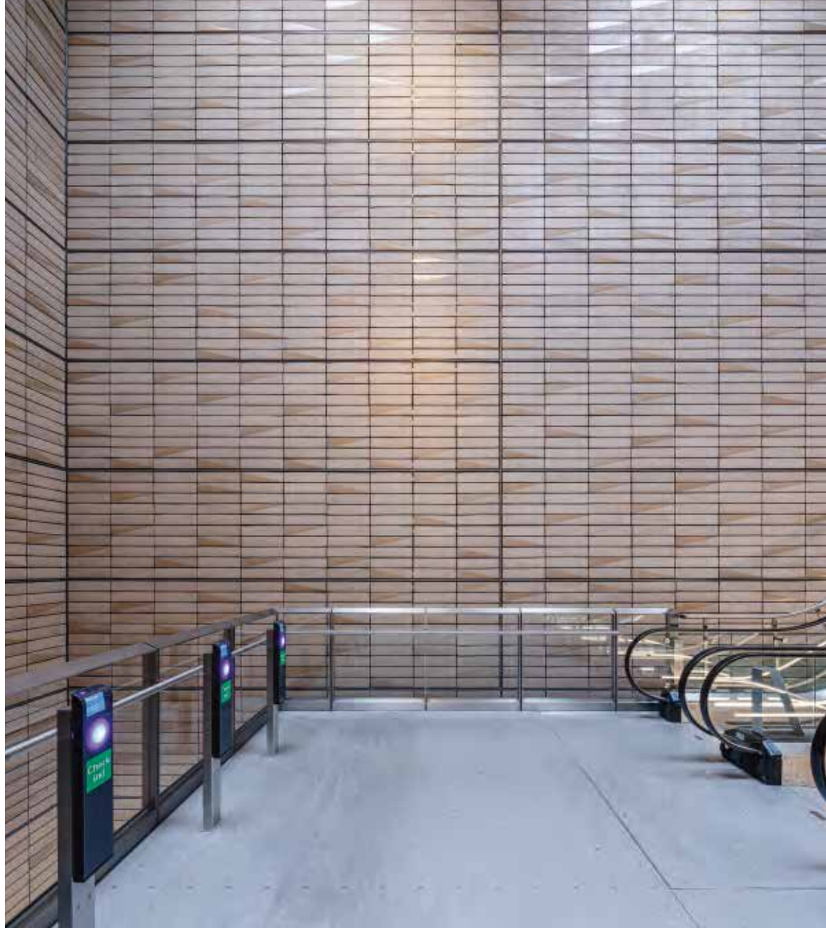
Der Metro-Stein, ein geringfügig geänderter, handgefertigter Kolumba, ist an einer leichten Stahlkonstruktion befestigt, hinter der sich die umfassende Kabelführung verbirgt.
