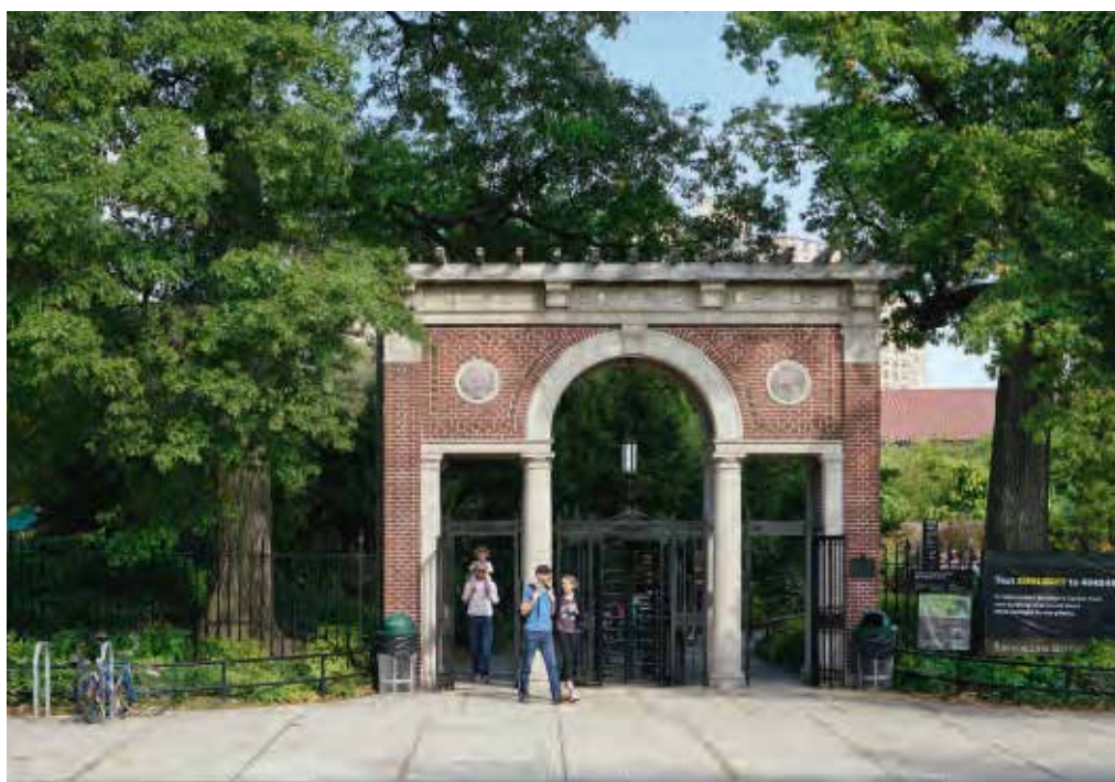
Das Portal wurde vom renommierten New Yorker Architekturbüro McKim, Mead and White entworfen, das Ende 19. Jahrhundert auch eine Reihe bekannter Gebäude an der Ostküste der USA entwarf. Foto: Tom Eckerle
