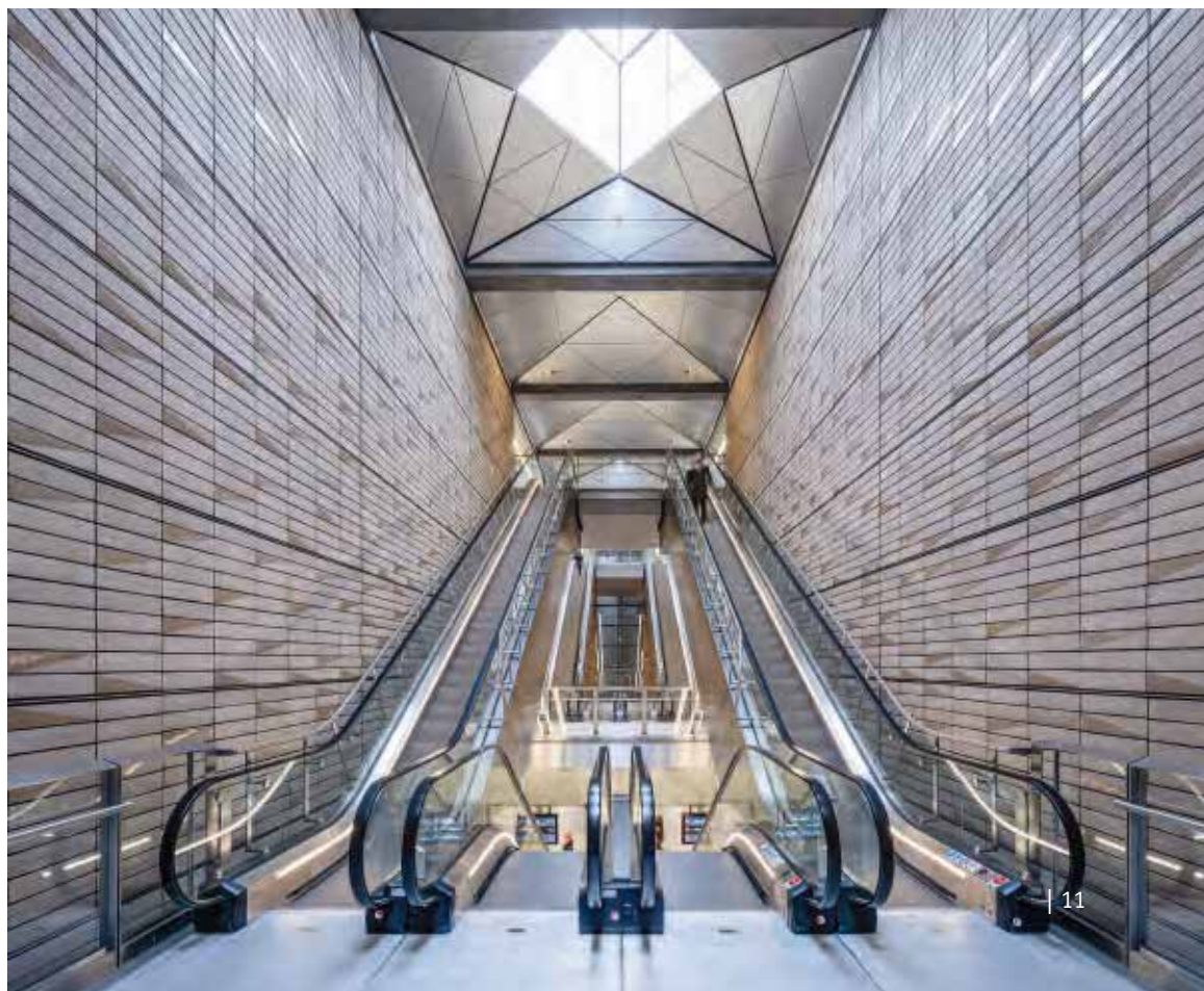
Das Tageslicht wird durch raffiniert gefaltete Origamidecken, die eine maximale Reflexion des Lichts ermöglichen, 20 Meter unter der Erde auf die Bahnsteige geleitet.
