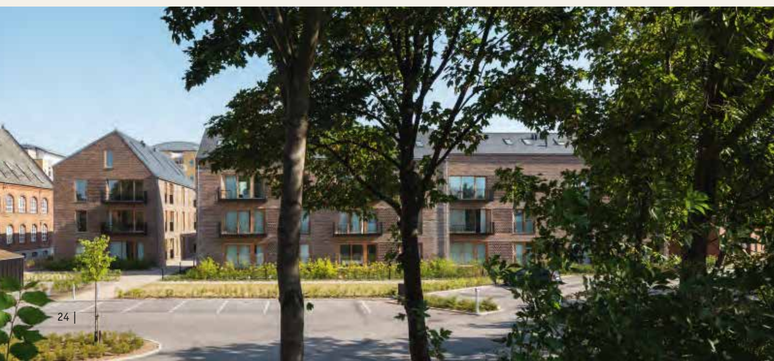
Die Häuser am Indiakaj grenzen an das denkmalgeschützte Kastell Kopenhagens an, das 1624 von König Christian IV als Festung erbaut wurde.
