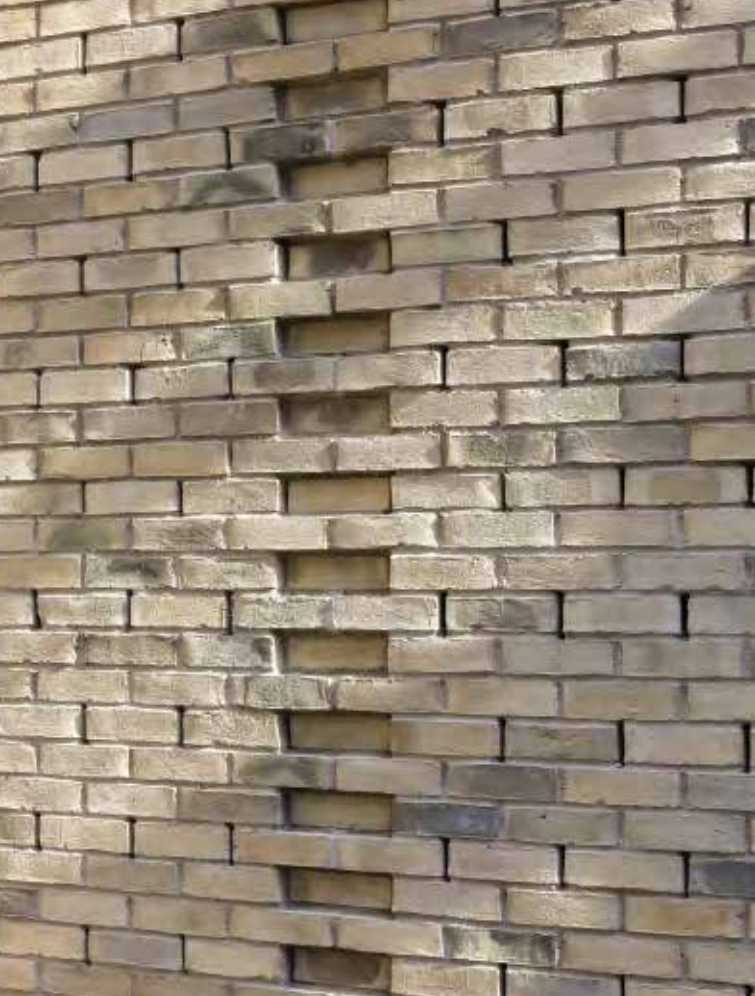
Die Mauer bildet eine Fassade zum überdachten Achterplaats und ist mit ihren offenen Fugen ein Teil der Belüftungsanlage. Sie dient außerdem als Akustikwand. Foto: Paul Kozlowski
