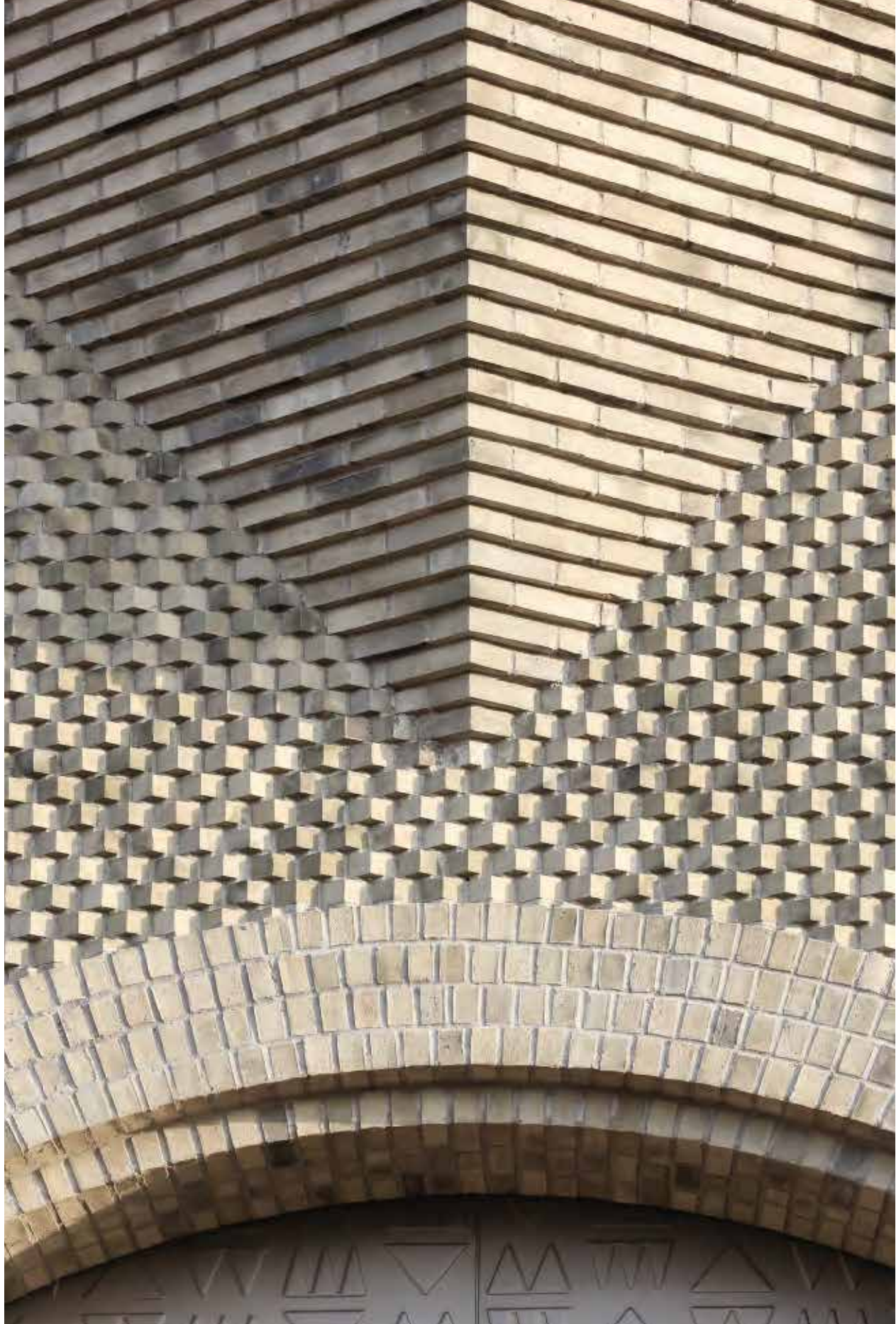
Petersen Tegl produzierte Formsteine mit einem Winkel von 30 Grad, damit die dem Lammermarkt zugewandten Erker im gleichen Winkel gebaut werden konnten. Visuell scheinen die Ziegel aus der Mauer herauszuwachsen. Foto: Paul Kozlowski
