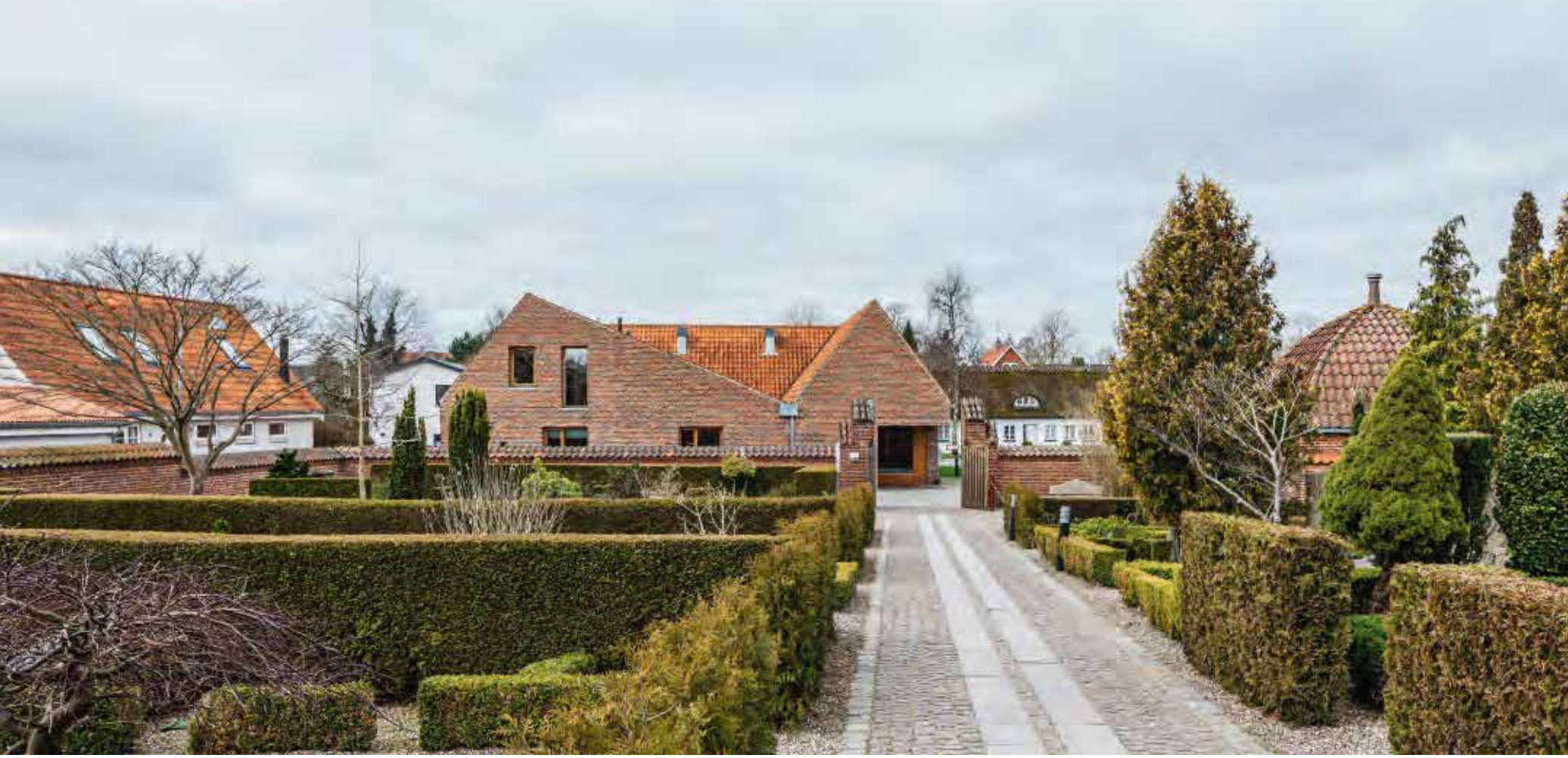
Das Gemeindehaus Vindinge fügt sich durch Größe und Material nahtlos in die benachbarte Häusergruppe des Dorfes ein. Den Neubau und die Kirche verbindet ein mit Kopfsteinpflastersteinen und größeren Granitquadern gepflasterter Weg.
