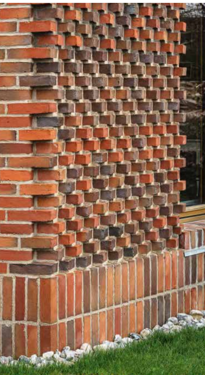
Klassische Details wie die Grenadierschicht des Sockels und das Sägezahn-Mauerwerk an den Ecken unterstreichen den Ausdruck des Gebäudes und schaffen einen Bezug zum Gemäuer der Kirche.
