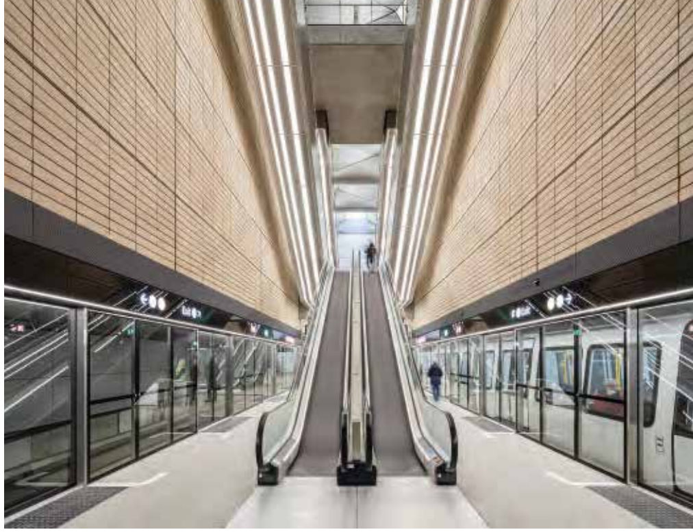
Die selbstfahrenden Züge der Kopenhagener Metro fahren im Zwei- bis Fünf-Minuten-Takt.
