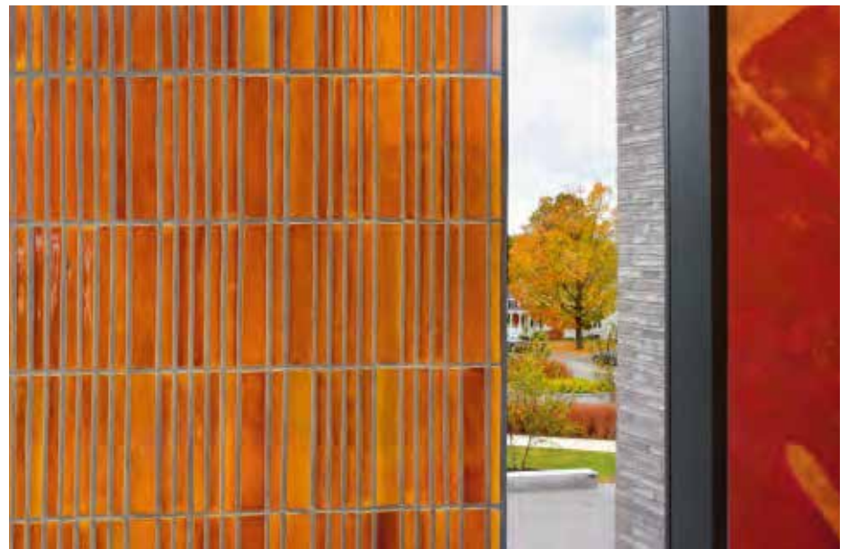
Für den Eingang zum Theater produzierte Petersen Tegl insgesamt fünf verschiedene gekrümmte und rechteckige Formsteine. Der größte Ziegel misst 489 x 511 mm. Danach wurden sie in der Ziegelei in drei verschiedenen Farben glasiert: Rot, Orange und Karamell. Entscheidend für die richtige Nuance war es, die Glasurschicht in der entsprechenden Dicke aufzutragen. Da der von Hand gefertigte Ziegel eine rustikale Oberfläche hat, verteilen sich die Farbpigmente ungleichmäßig, und der fertige Stein ist geflammt – und einfach schön.
