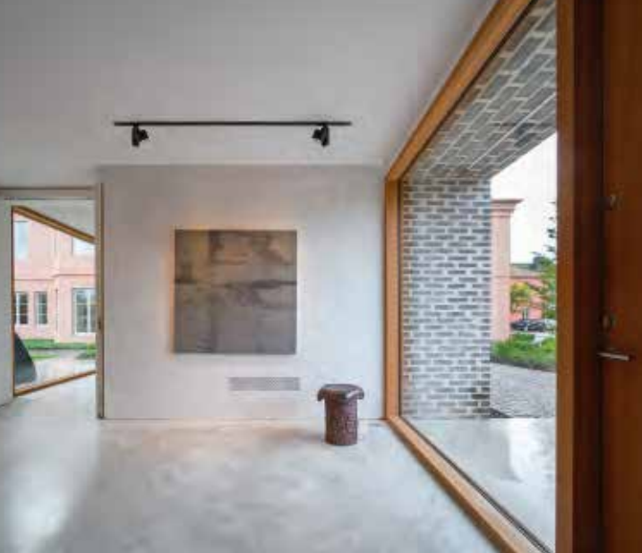
Der Boden aus Ortbeton wurde in den Garten hinein verlängert – ein Substitut für den nicht vorhandenen Sockel.
