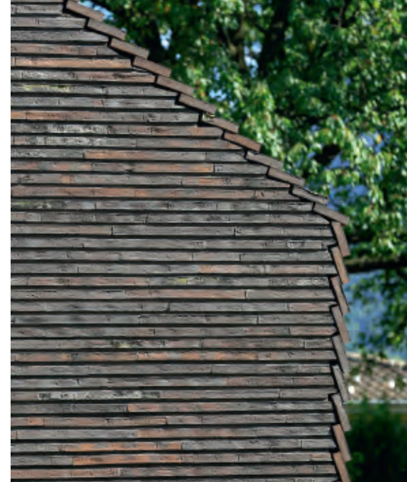
Die Kolumba-Steine der Giebelwände wurden sorgfältig zugeschnitten, sodass sie sich mit den Cover-Ziegelschalen der Dachfläche verflechten. Das Ergebnis ist ein gleichermaßen minimiertes und detailreiches Eck.
