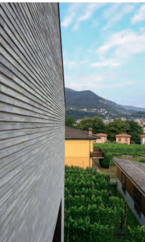
Das sanfte Mauerwerk mit zurückgezogenen Lagerfugen erzeugt ein diskretes Schattenspiel, das zusammen mit den Kolumba-Steinen die Längenausdehnung des Hauses unterstreicht.
