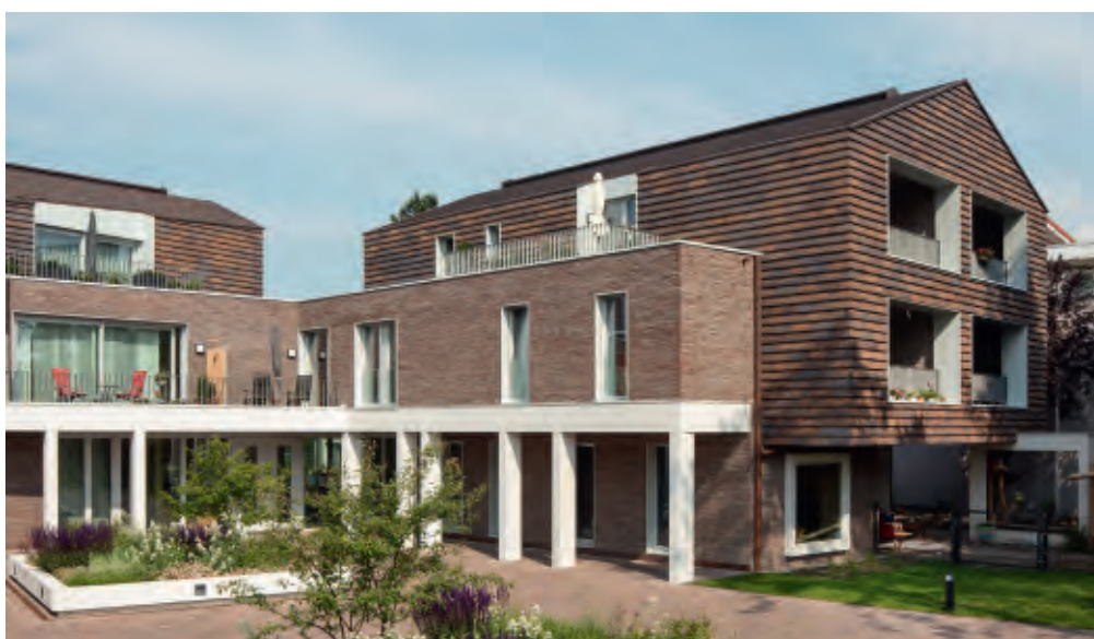
Nur das Erdgeschoss des Vierkandthofs ist zusammenhängend. Nach oben hin bilden die drei Seiten selbständige Gebäudeteile unter einem jeweils eigenen Satteldach.
