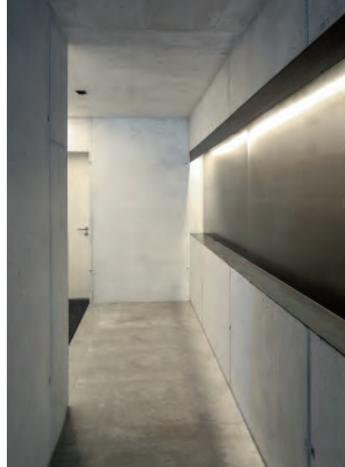
Im Ca' Ospiti weist die Einrichtung nur wenige Materialien auf. Der vor Ort gegossene Sichtbetonsockel ist im Inneren unbehandelt.
