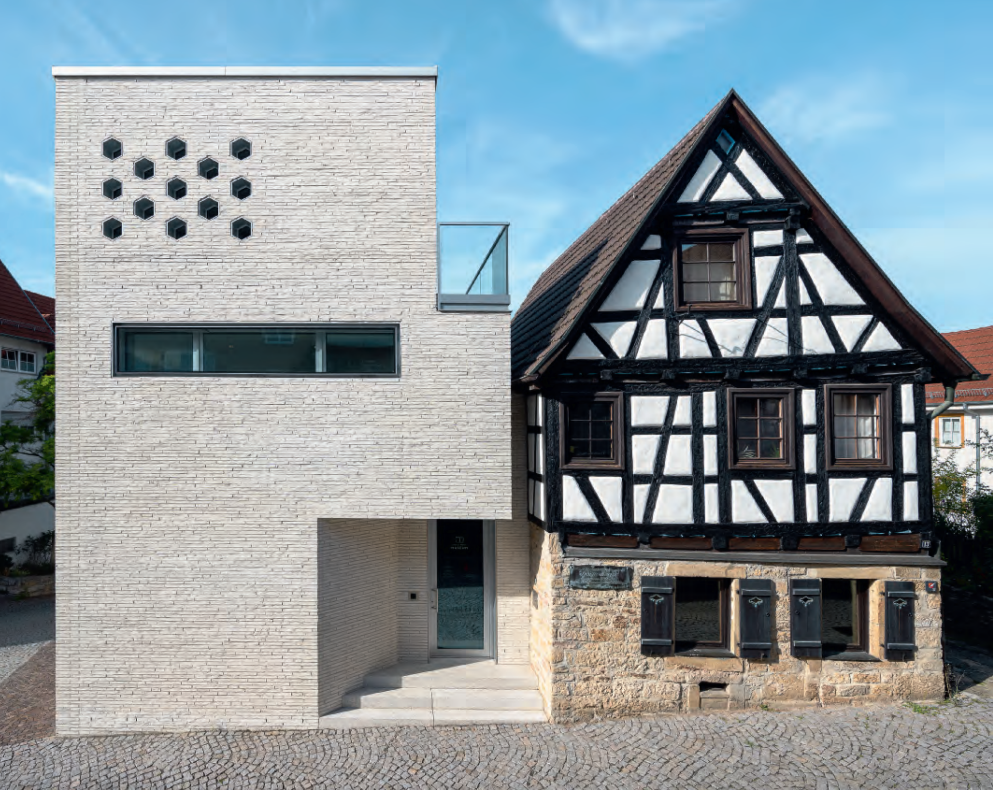
In Maßstab und Fassadenlinien bezieht sich der neue Museumsanbau in Marbach am Neckar deutlich auf das Fachwerkhaus aus dem Jahr 1711. Der Haupteingang des Museums befindet sich unter der vorkragenden Ecke am Göckelhof.
