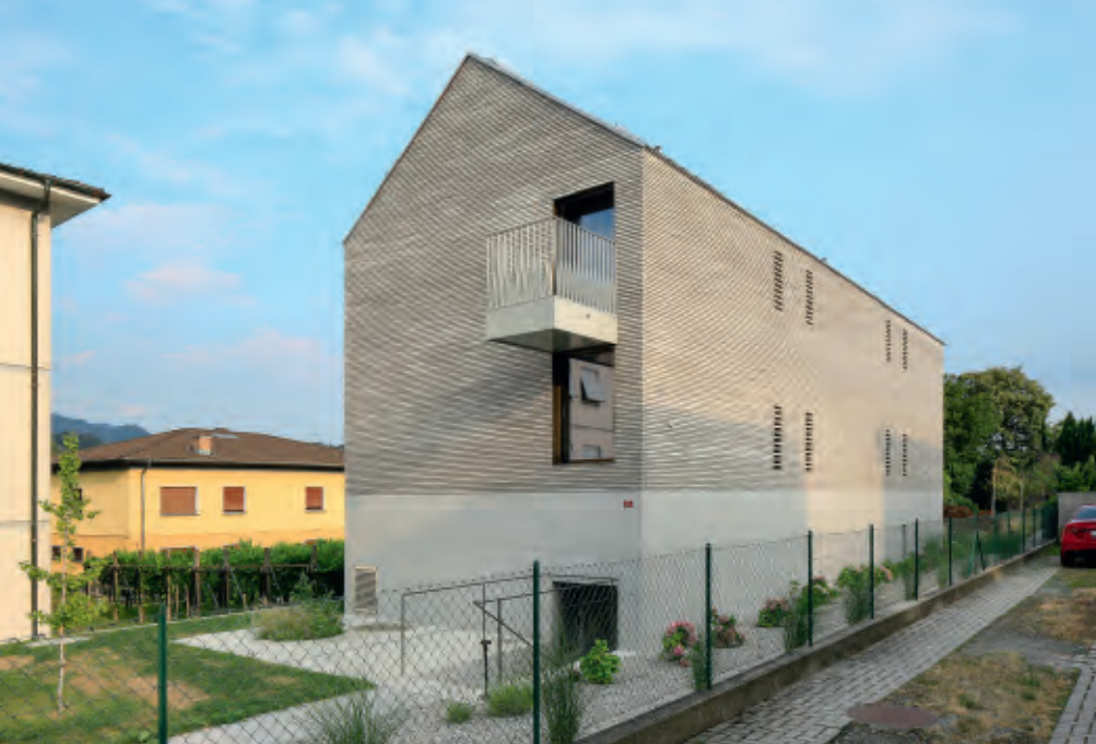
Entlang der nach Westen gerichteten Fassade verläuft ein Gartenweg zum Atelier. Um Störungen zu vermeiden wurden die Fenster durch Flechtmauerwerk ersetzt, das Licht in die dahinterliegenden, sekundären Räume des Wohnhauses hineinbringt.
