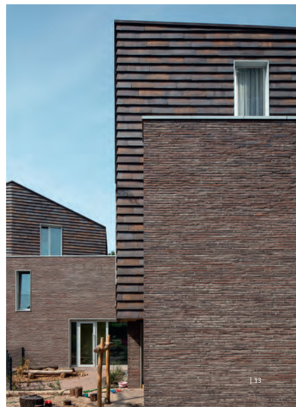
Die Anwendung von Kolumba und Cover in denselben braunroten Farbtönen verbindet das Gebäude, während die unterschiedliche Stofflichkeit der beiden Ziegel einen schönen Kontrast im Fassadendruck bildet.
