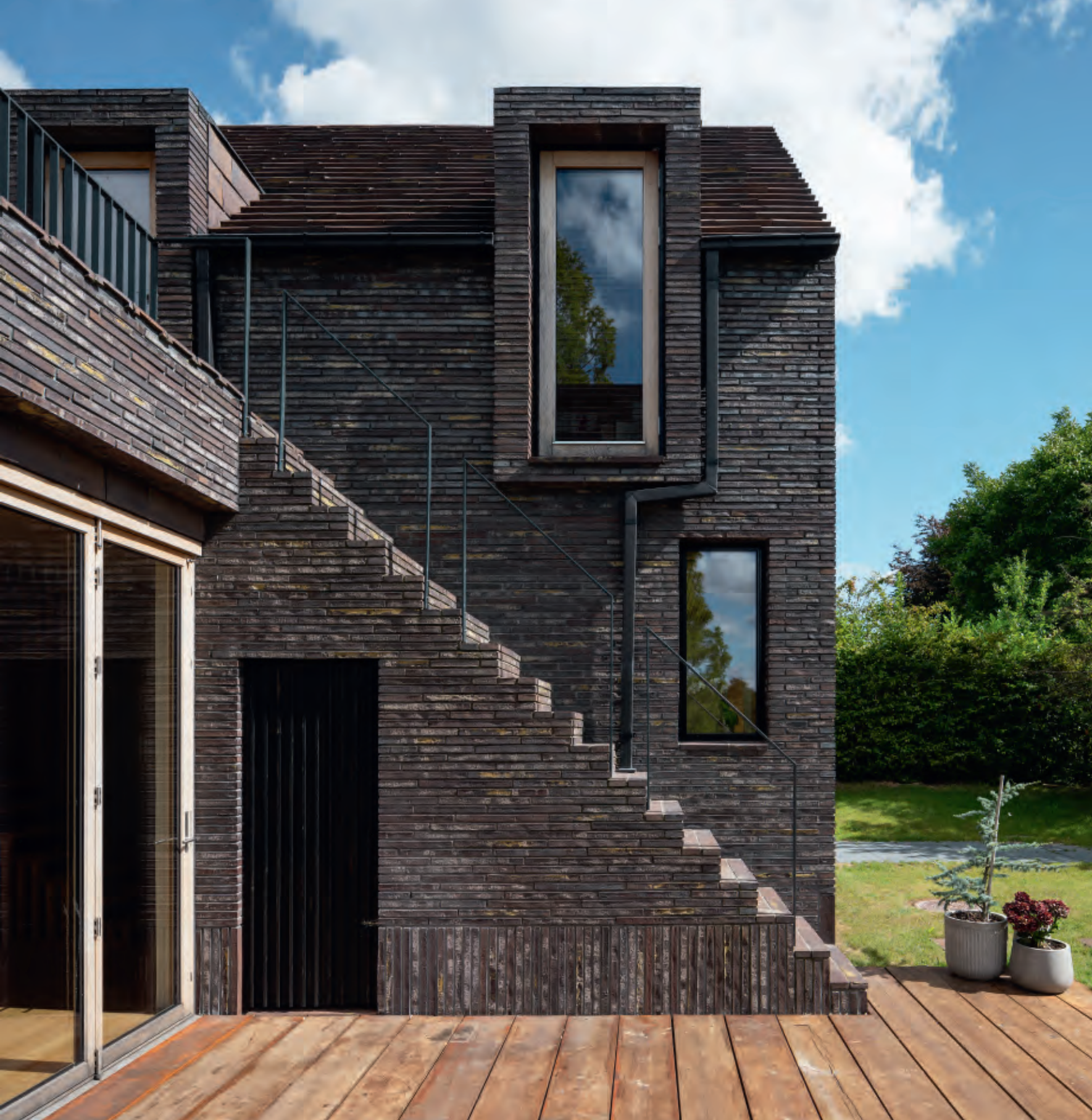
Auch eine gemauerte Treppe zur Dachterrasse wird zu einem markanten, dekorativen Element. Die Treppenstufen wurden als Ziegelfertigelement in K57 von Petersen Tegl gefertigt.
