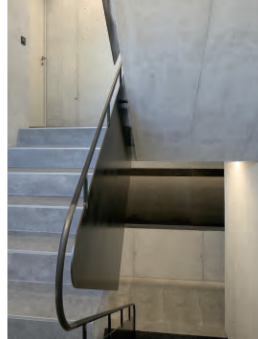
Die Betontreppe hat einen Handlauf sowie eine teilweise Abschirmung aus Eisen in einem unbehandelten Finish, das patiniert, wodurch die schwarze Grundfarbe mit grünen und blauen Farbtönen schillert.
