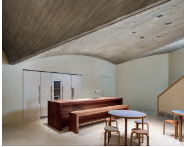
Die Decke im Keller hat keine tragende Funktion und ist vor Ort gegossen, weshalb sie als asymmetrisches Gewölbe geformt werden konnte.
