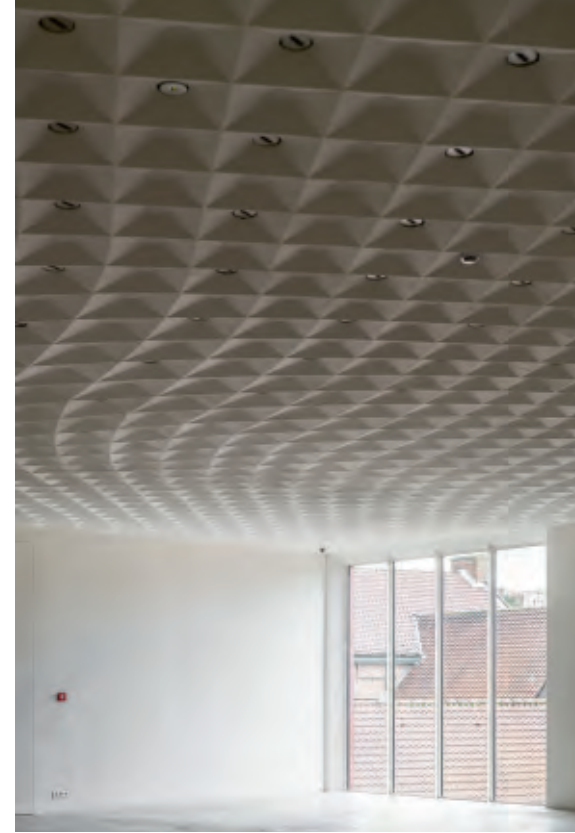
Vom großen Ausstellungsraum der oberen Etage eröffnet sich ein schöner Blick über den Garten. Die Kassettendecken kennt man von der Monumentalarchitektur des Altertums. Hier jedoch haben sie eine moderne Form gefunden. Die in Ortbeton gegossenen, wellenförmigen Linien scheinen den Weg des Besuchers durch den Raum widerzuspiegeln. Foto: Olmo Peeters
