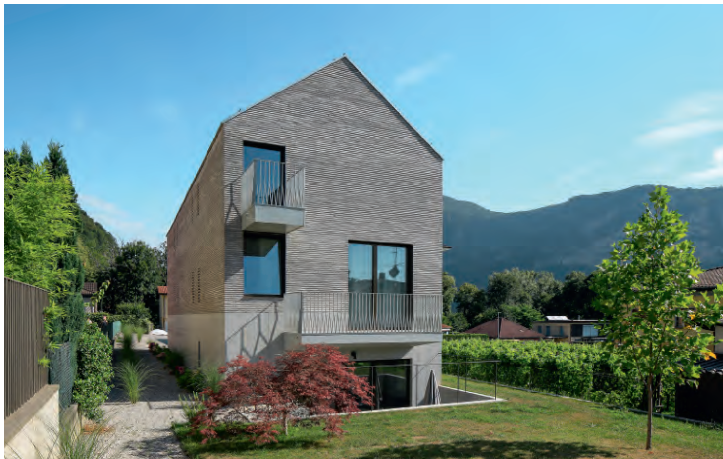
Im Untergeschoss befindet sich eine kleine Gästewohnung. Die Stützmauer scheint fast aus dem Sockel herauszuwachsen und bildet einen kleinen, halbprivaten Hofraum mit Zugang zum Garten.
