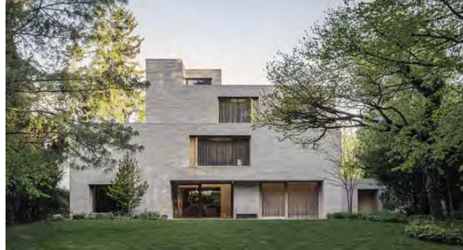
Haus am Englischen Garten, München, Deutschland Architekt: Baumstark Bielmeier Architekten und Axel Baudendistel Fritz Höger Award 2020 Stein: K51 Foto: Florian Holzherr
