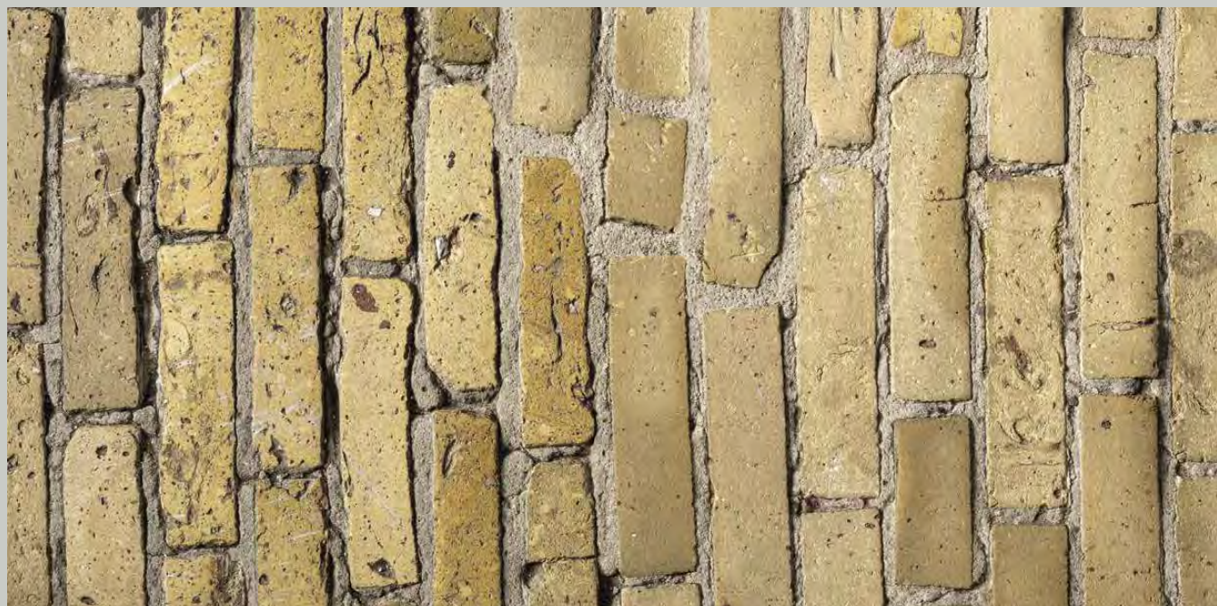
Seit 1990 produziert Petersen Tegl kontinuierlich ganz besondere Ziegel aus dänischem Blaulehm, die für die Reparaturen des Belags im spiralförmigen Gang des Turms verwendet werden.
