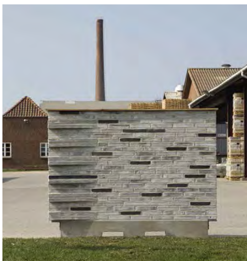
Bevor die finale Entscheidung über die Zusammensetzung des Steins für die zukünftigen Fassaden getroffen wurde, ließ man mehrere Mockups erstellen.
