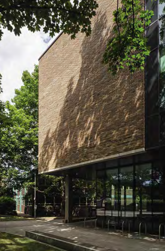
Das Gebäude zeichnet sich durch große und ruhige gemauerte Flächen aus.
