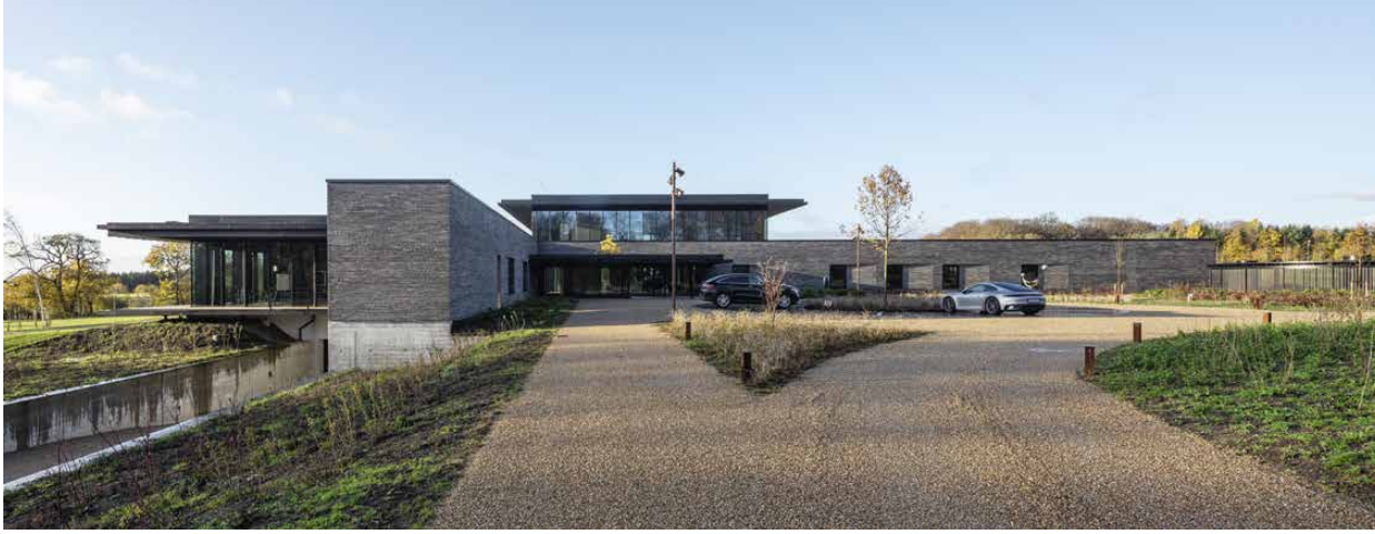
Von der Zufahrt aus sind die beiden unterschiedlichen Erscheinungsbilder der Fassade zu sehen: Die transparente Gartenfassade nach Südwesten und die dem Eingang zugewandte, schwerere, mit Ziegeln verkleidete Mauerfläche, die sich orthogonal zum Haupteingang erstreckt und das Gebäude mit dem Gelände verbindet.
