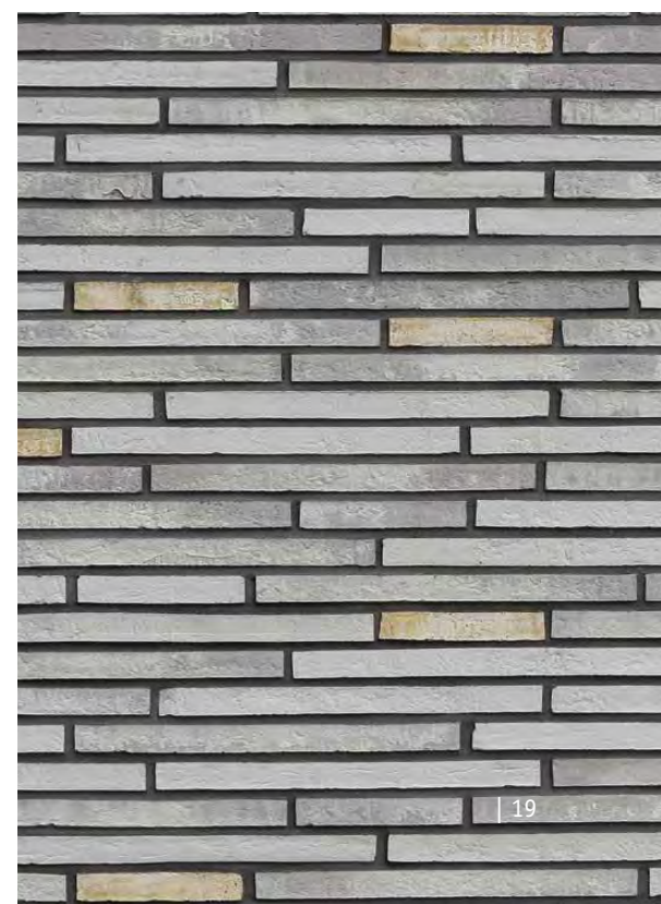
Die Entscheidung für die Kombination aus hellgrauen und gelben Steinen ist das Ergebnis einer ausführlichen Untersuchung verschiedener Steine und Steinmischungen, unter anderem bei unterschiedlichen Witterungsbedingungen.
