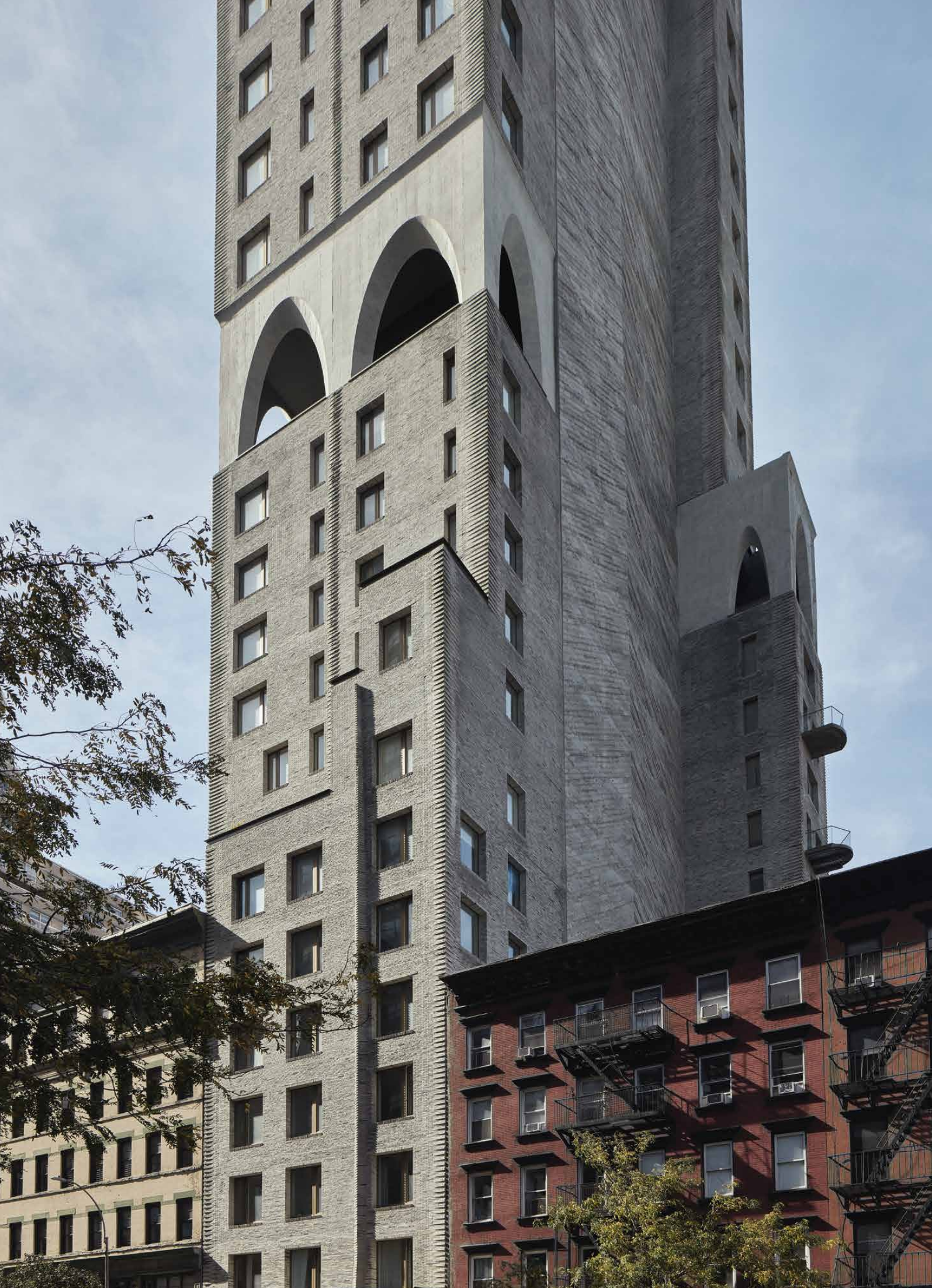
180 East 88th Street wurde als Ortbetonkonstruktion errichtet, die Fassade wurde mit Ziegelsteinen verkleidet, die einzeln vor Ort vermauert wurden. Eine vertikale Partie der Fassade an der Nordseite des Turms wurde aus Beton errichtet, ebenso bestehen die Gürtel am Gebäude aus vor Ort gegossenen, parabolischen Bögen.
