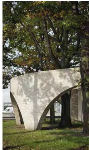
Drei Transformatorstationen Brabo 2, Antwerpen, Belgien Architekt: Van Belle & Medina Architects EUMiesAward 2022, nominiert Stein: D72 Foto: Stijn Bollaert
