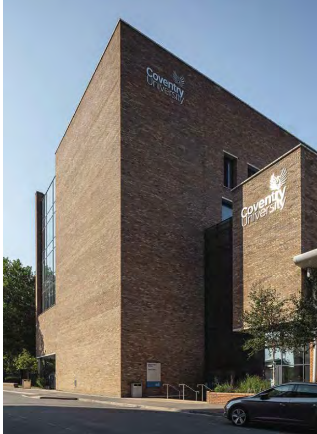
Der Eingang zum Alison Gingell Building zeigt nach Nordosten.
