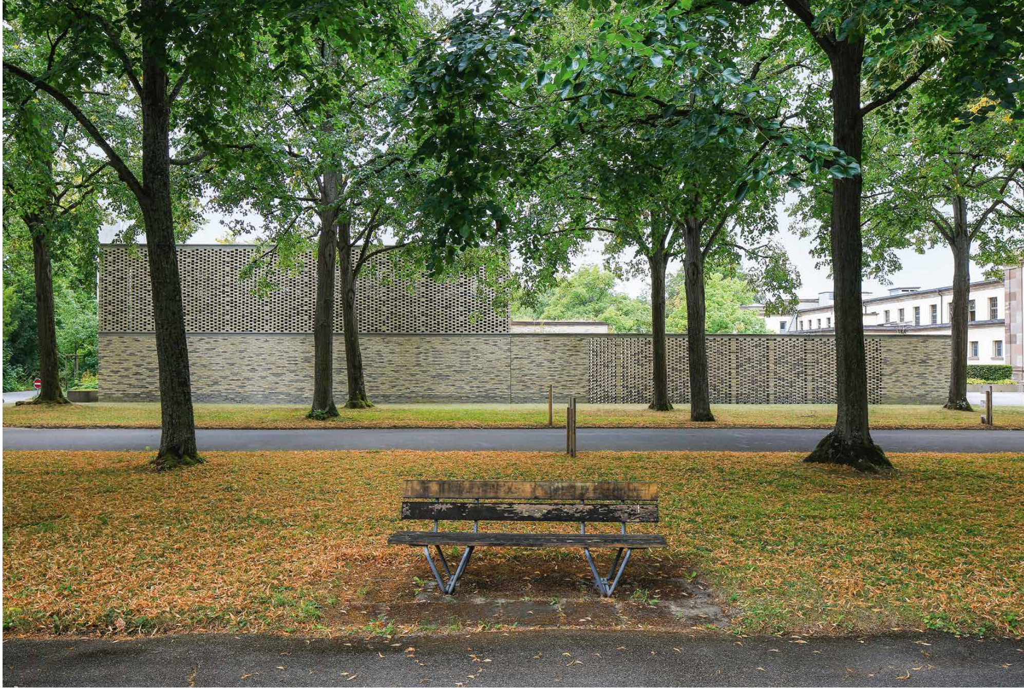
Das Krematorium auf dem Friedhof am Hörnli liegt an einer existierenden Lindenallee. Der Architekt Bernhard Maurer entschied sich für eine Mischung aus D71 und D91, um einen camouflagartigen Effekt zu erzielen, der das Gebäude mit seiner Umgebung verschmelzen lässt.
