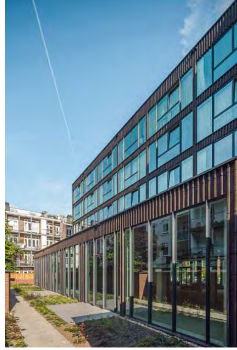
Auch die Fassade zum Hof ist mit Ziegeln verkleidet, wobei das Erdgeschoss vorgezogen ist.
