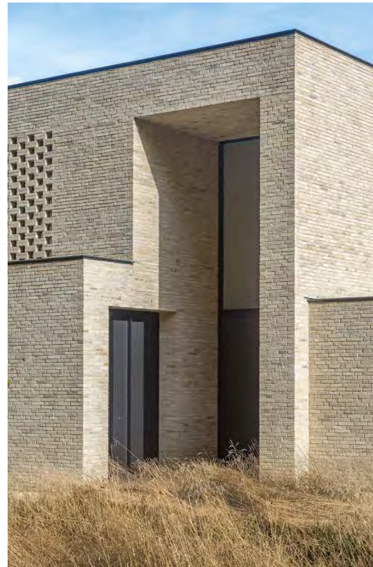
Der Zugang zum Wohnhaus und zum Designstudio erfolgt über eine 5,35 Meter hohe Nische mit einem großen Glasausschnitt über dem Haupteingang des Wohnhauses.
