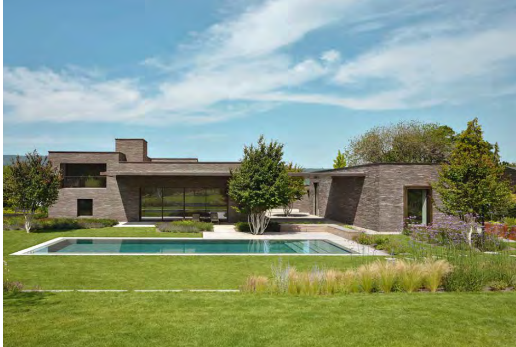
Die offene Wohnküche öffnet sich mit einer riesigen Glasfront zum Garten und einem Pool. Die gesamte Glasfläche kann zur Seite geschoben und in den flankierenden Wänden versteckt werden.
