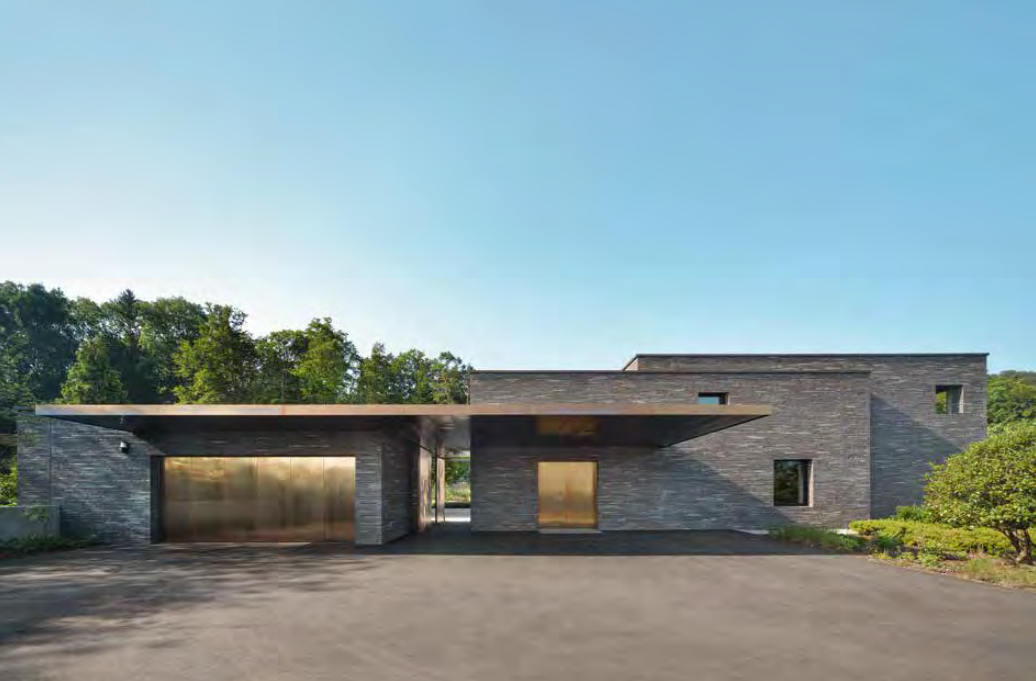
Der Zugang zum Haus und zur Garage liegt unter einem großen Vordach, das wie die Tür und das Tor mit Kupfer verkleidet ist. Vom Eingang des Hauses kann man in den Garten blicken.
