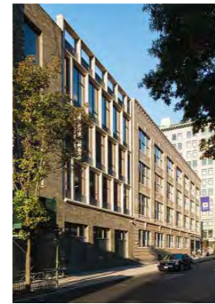
14 383 Lafayette Street, Manhattan Architekt: Ennead Architects Fertiggestellt: 2016 Ziegel: D54 DNF Foto: Aislinn Weidele/Ennead Artikel auf S. 4
