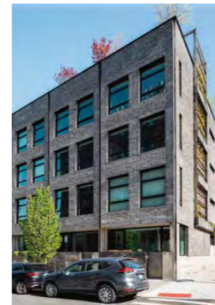
24 59 South 4th Street, Brooklyn Architekt: Arcus Design Group Fertiggestellt: 2015 Ziegel: D54 FF Foto: Dean Kaufman Artikel auf S. 10
