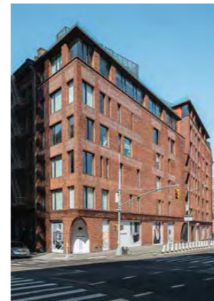
20 100 Franklin Street, Manhattan Architekt: DDG Partners Fertiggestellt: 2018 Ziegel: K4, K33, K43, D33 FF, D43 FF Foto: Dean Kaufman Artikel auf S. 5
