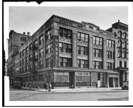
Teil dieses Projekts war die Restaurierung und der Umbau eines Industriegebäudes von 1916.
