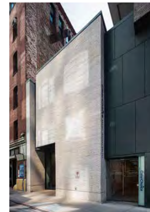
27 415 Red Hook Lane, Brooklyn Architekt: Ennead Architects Fertiggestellt: 2018 Ziegel: K11 Foto: Dean Kaufman Artikel auf S. 11
