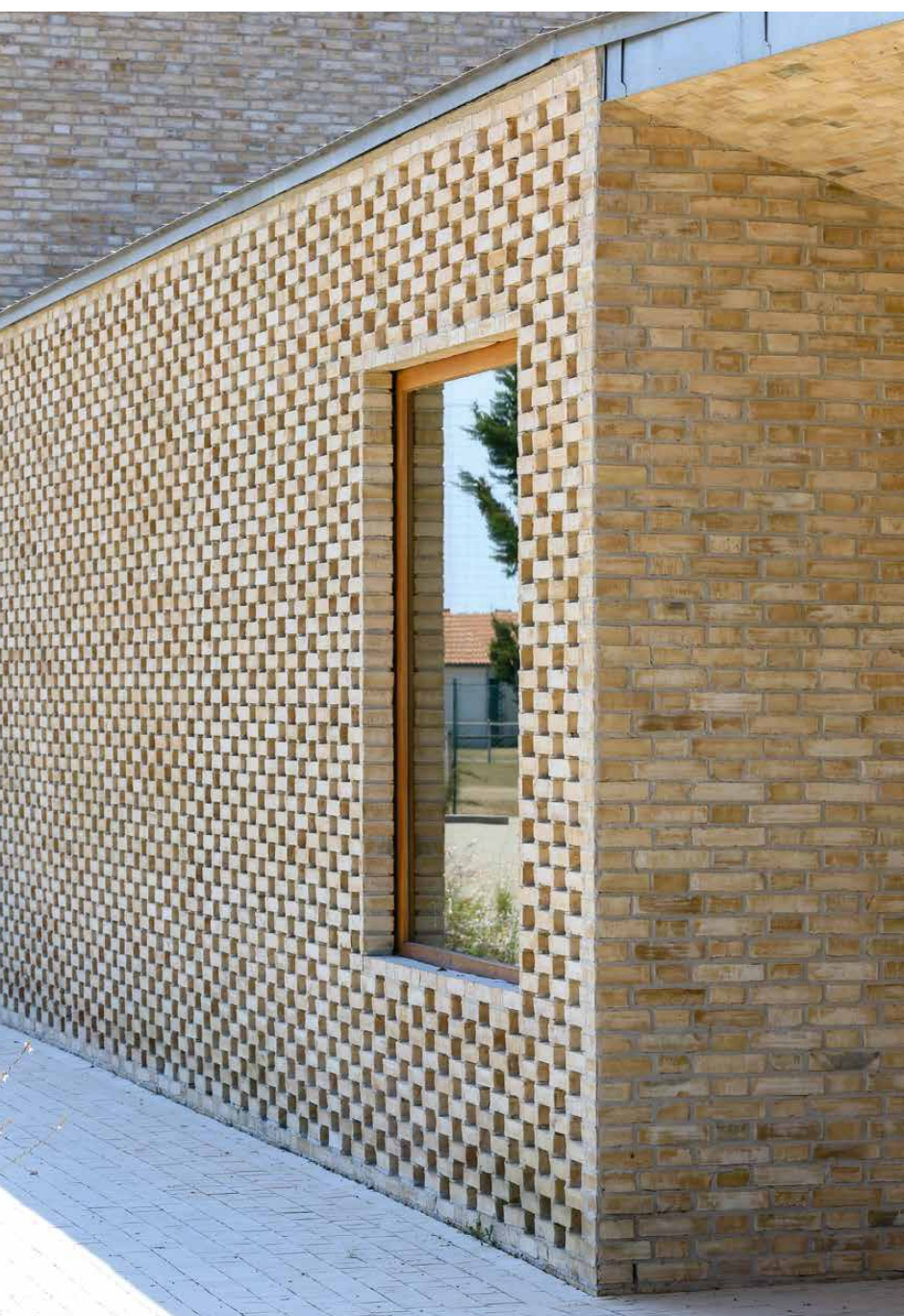
Die Fassaden wurden auf drei verschiedene Weisen gemauert. Teilweise im geschlossenen flämischen Verband, teilweise als Reliefmauerwerk und teilweise als sogenannte Mashrabiya, ein Lüftungsgitter nach arabischem Vorbild. Das Mauerwerk der Fassade ist bis ganz ins Gelände herabgeführt. Foto: Paul Kozlowski
