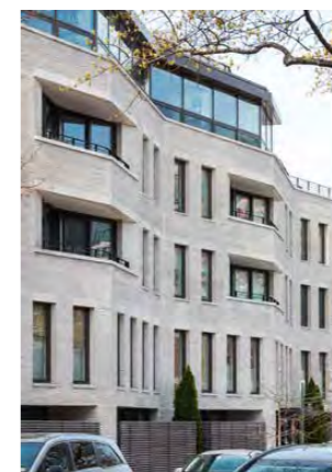
34 280 Marks Avenue, Brooklyn Architekt: DXA Studio Fertiggestellt: 2016 Ziegel: K11 Foto: Dean Kaufman
