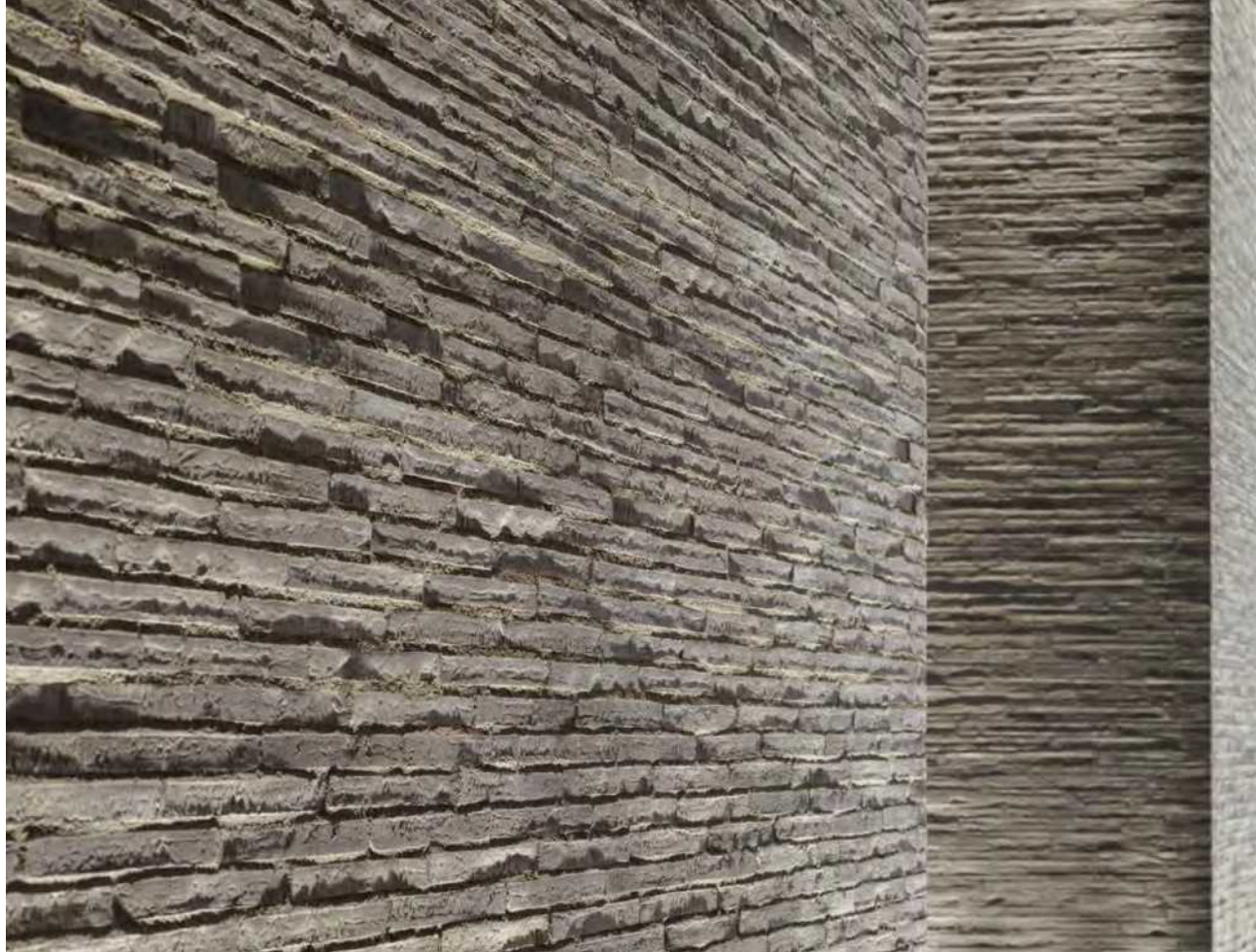
»Wall Grazing« hebt die Unregelmäßigkeiten der handgefertigten Steine hervor und dramatisiert die Textur der Lobbywand.
