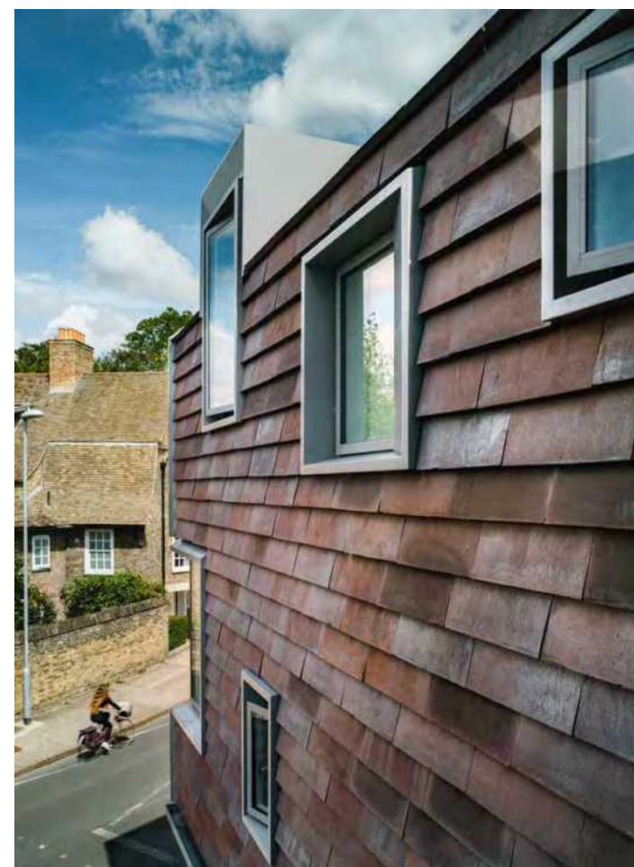
Unter anderem sind die Dachgauben und Fensterrahmen mit grau lackiertem Aluminium verkleidet, alles Sonderanfertigungen.
