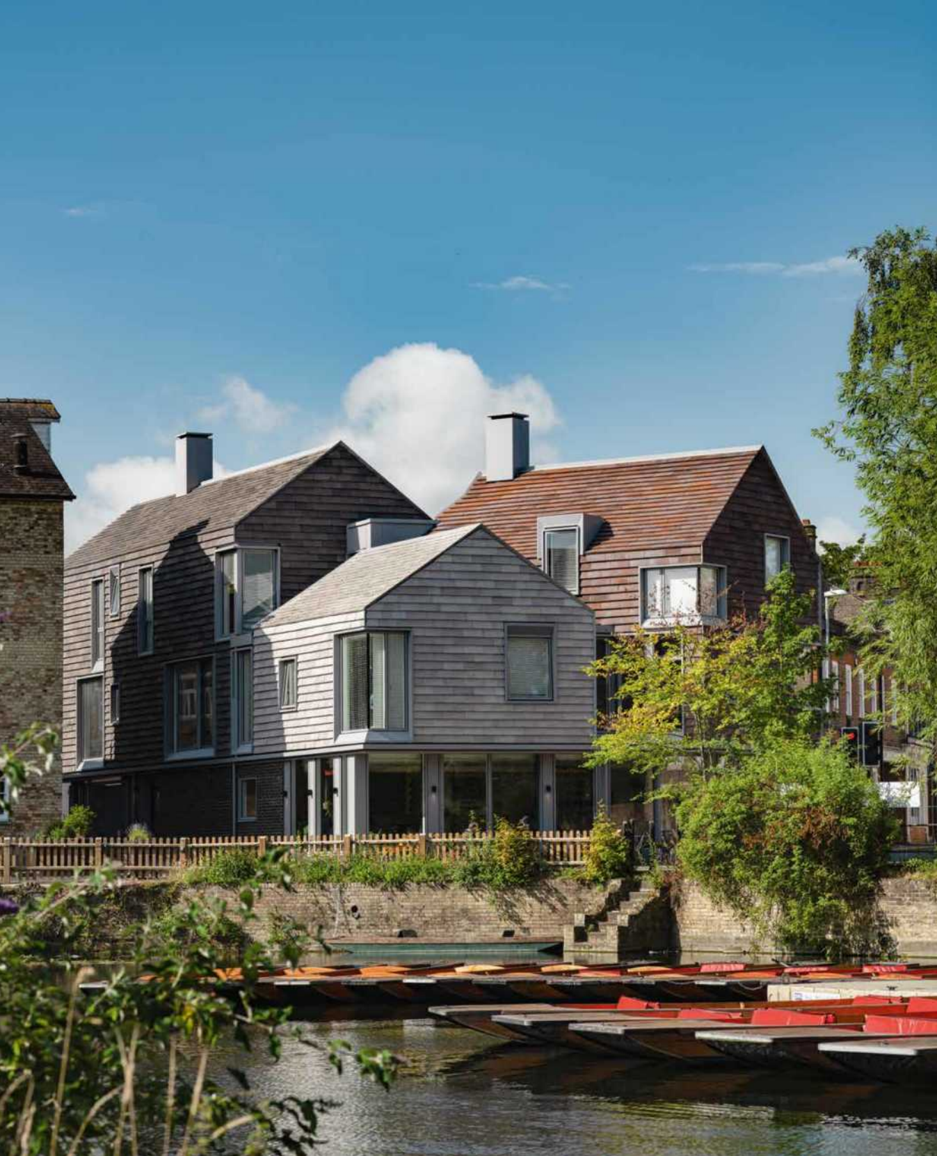
Der Neubau setzt sich aus drei kleineren Einheiten zusammen, die egal aus welcher Richtung man sich ihnen nähert, als einzelne Häuser wahrgenommen werden. Die drei Gebäudeteile sind mit jeweils einer eigenen Variante von Cover verkleidet, deren Farbtöne sich in den Fassaden und Ziegeldächern der umliegenden Häuser wiederfinden.
