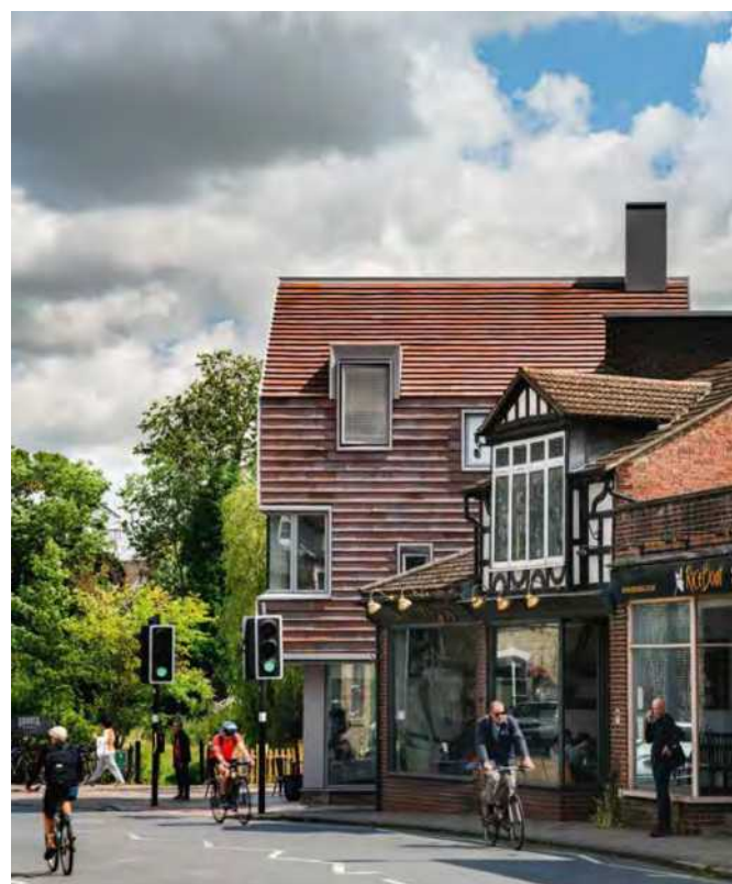
Die Schornsteine des Hauses sind ein wichtiger optischer Aspekt und dienen der Belüftung.
