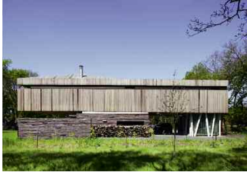
Der lange, mit tropischem Holz verkleidete Baukörper mit seinen beidseitigen Auskragungen ruht auf dem gemauerten Fundament.
