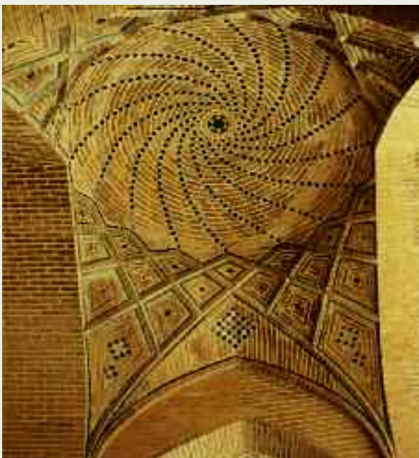
< Konstruktion und Ausschmückung der al Wakil-Moschee sind organisch miteinander verbunden. Die Gewölbe der Moschee in Shiraz aus dem Jahre 1760 ziert ein raffiniertes Ziegelmuster.
