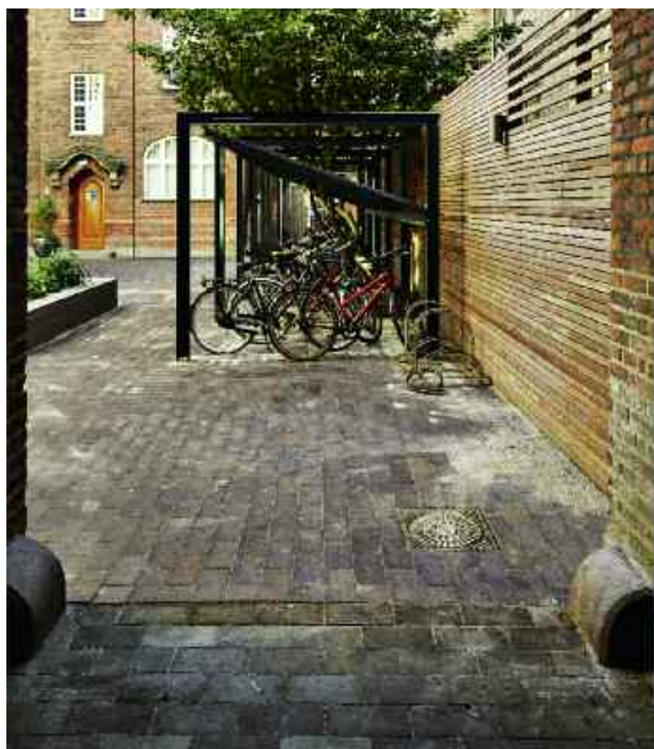
Im Zuge der Renovierung wurde auch an die Fahrradfahrer gedacht. Der Torweg wurde mit schalldämpfendem Holz im gleichen Format wie die Klinker ausgelegt.
