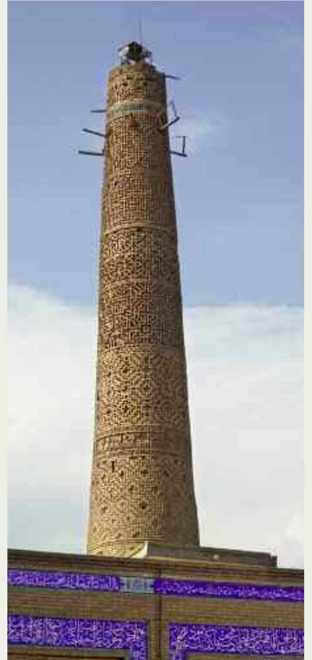
> FMinarett der Freitags-Moschee in Damghan, seldschukisch, um 1058. Die Ziegelsteine wurden in Mustern gemauert.
