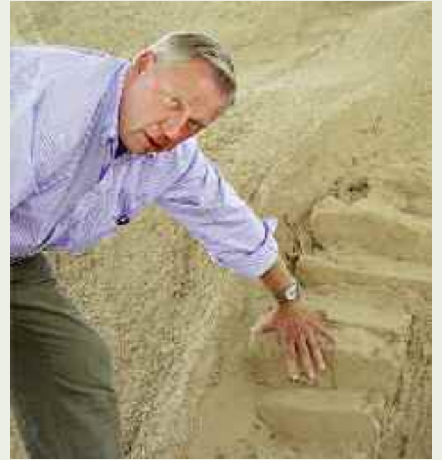
Christian Petersen untersucht die 3.500 Jahre alten Ziegel in Choga Zanbil. Die Zikkurat besteht aus einem Kern ungebrannter Lehmziegel, ummantelt von einer 2 m dicken Schicht gebrannter Ziegel.
