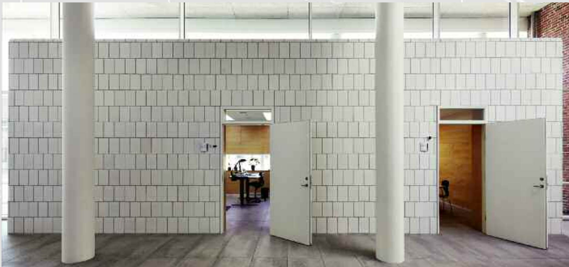
Die rechteckige, mit Fliesen verkleidete Einheit mit Büro und Besprechungsraum wurde wie ein Möbel im Haus platziert und nicht mit der Decke verbunden.
