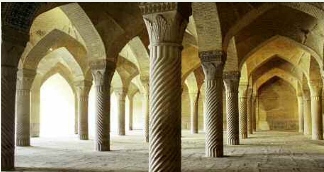
al Wakil-Moschee in Shiraz, erbaut 1722. Es wurden fast ausschließlich Ziegel verwendet. Die 48 monolithischen Säulen im Gebetsraum wurden allerdings aus Naturstein gehauen, so dass Säule und Kapitäl eine Einheit bilden.
