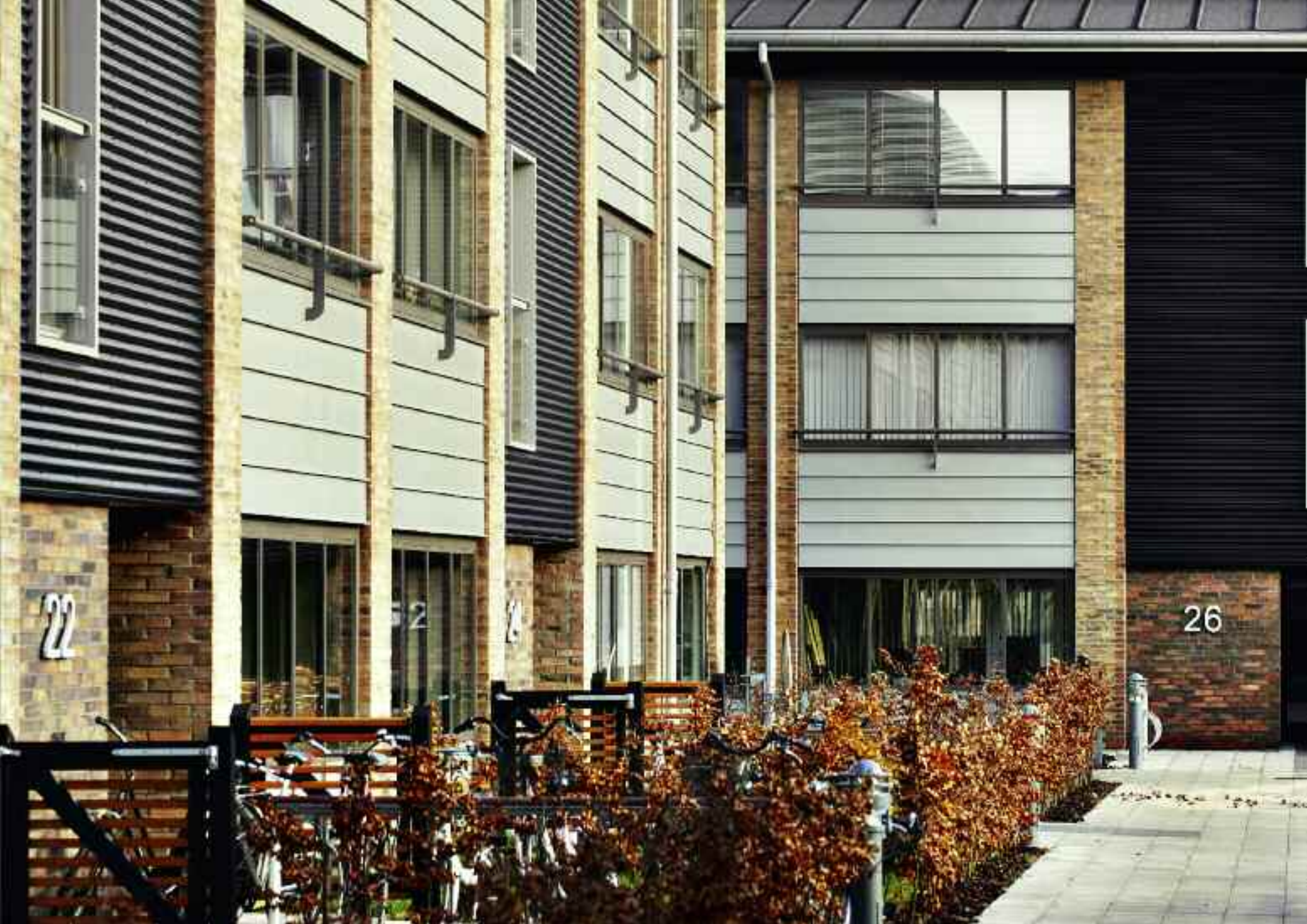
Auch die Fassaden zum Hof sehen nach der Renovierung völlig anders aus. Das Mauerwerk wurde erneuert, die Betonbrüstungen durch Zink ersetzt und die Türen wurden durch schwarz gestrichene Sinusplatten in voller Fassadenhöhe markiert.
