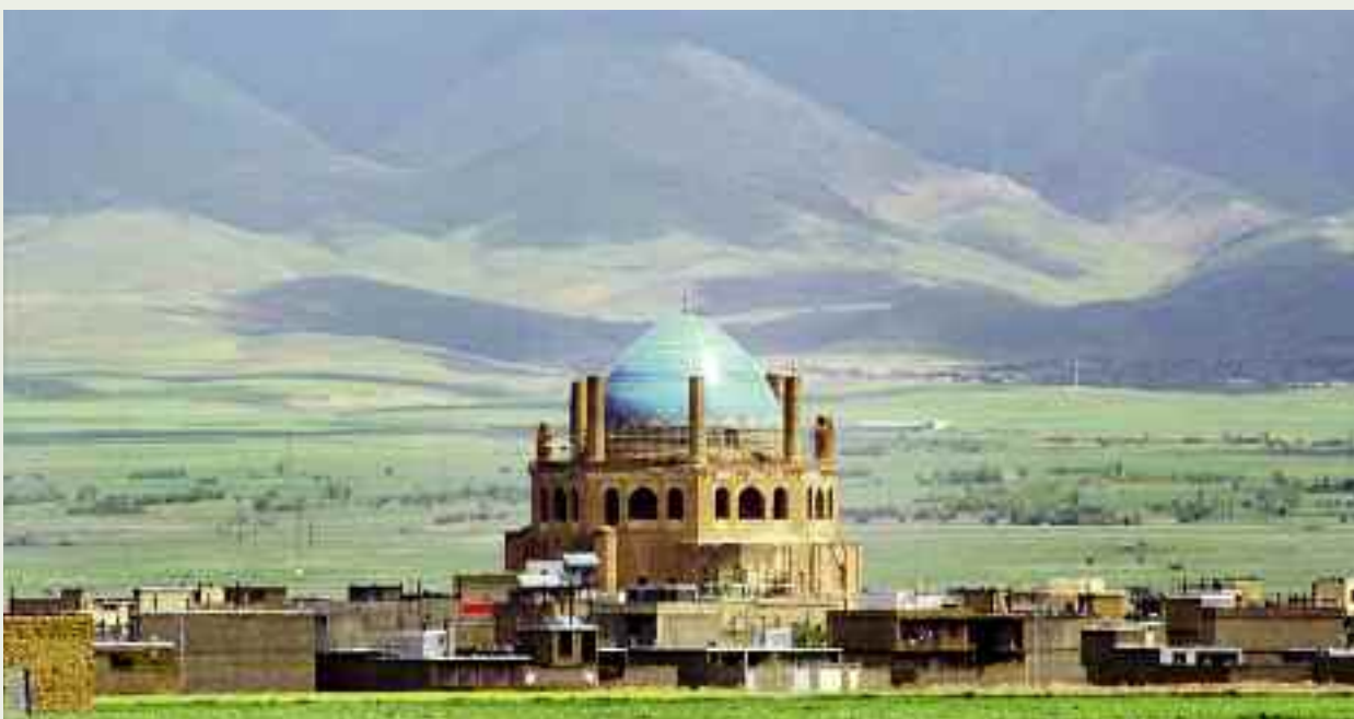
Das Grabmal des Mongolenherrschers Oldjaitu in Sultaniyeh erhebt sich über den Dächern des Dorfes. Das 51 m hohe Gebäude ist ein oktogonaler, grau-gelber Ziegelbau. Die große Kuppel imponiert mit einem Innendurchmesser von 25 m.
