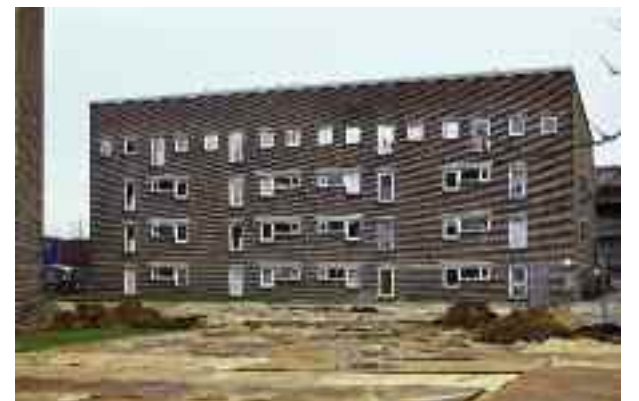
Gjesingparken vor der Renovierung: dunkle Fassaden, Balkonbrüstungen und Fensterstürze aus Beton und Dächer ohne Überhang.
