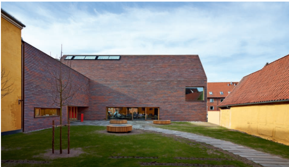
Die Platzierung der neuen Flügel im Hof ermöglichte es, das Museum von innen her zu errichten. Die Fassaden konnten somit freier ausgeformt werden, als wenn das Gebäude der Straße zugewandt wäre.
