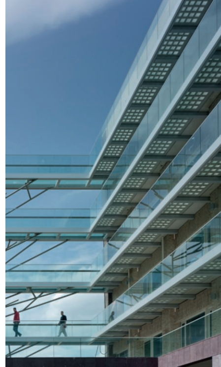
Die Geschosse sind über den Hof hinweg durch Fußgängerbrücken miteinander verbunden, die von astförmigen Stahlkonstruktionen gehalten werden. >
