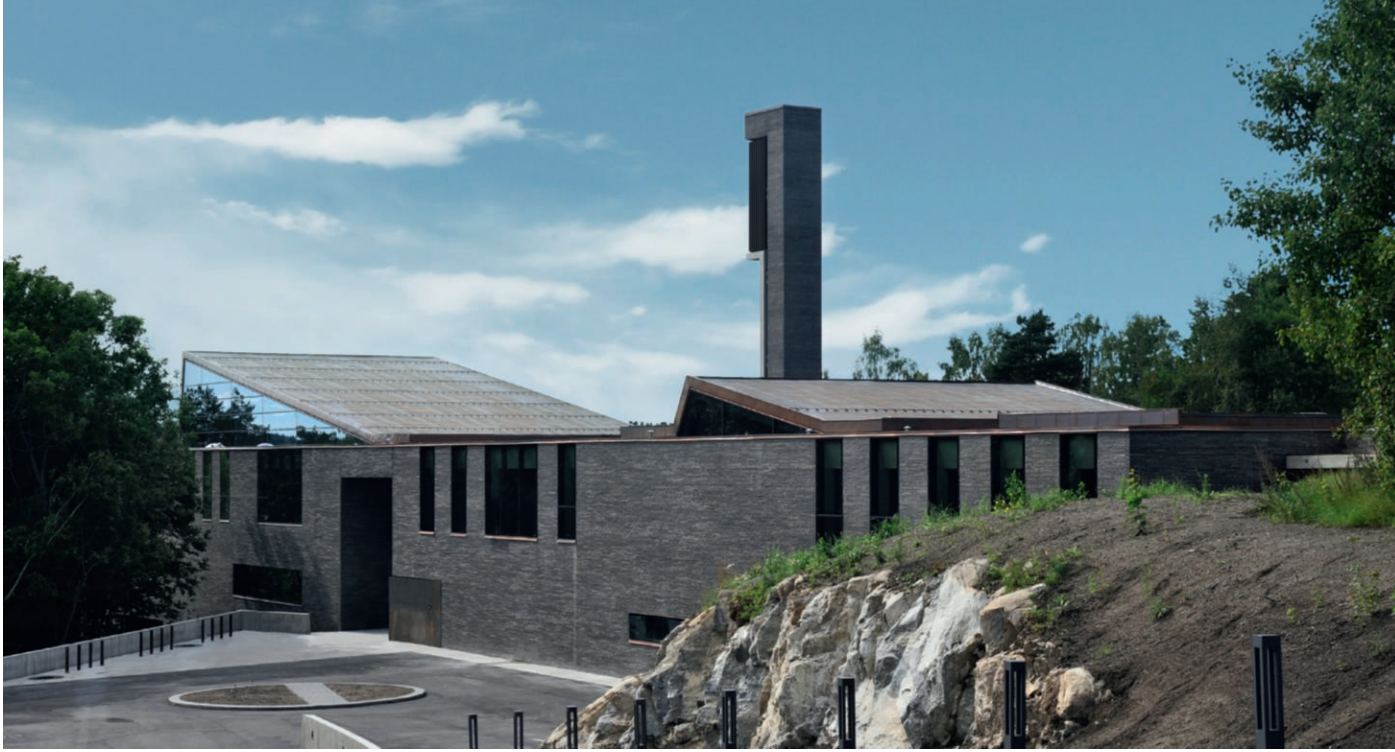
Man erreicht den Haupteingang des Gebäudes aus östlicher Richtung. Von dort aus wird man durch ein großes Portal zum zentralen Platz der Anlage geleitet.
