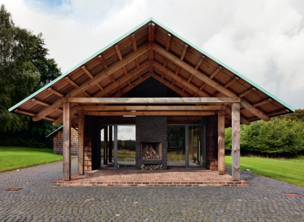
Die Dachkonstruktion der Jagdhütte wurde in pommerscher Kiefer errichtet. Der nicht isolierte Dachüberstand ist mit Kupfer verkleidet und über Dreiecksleisten mit Pappe belegt.
