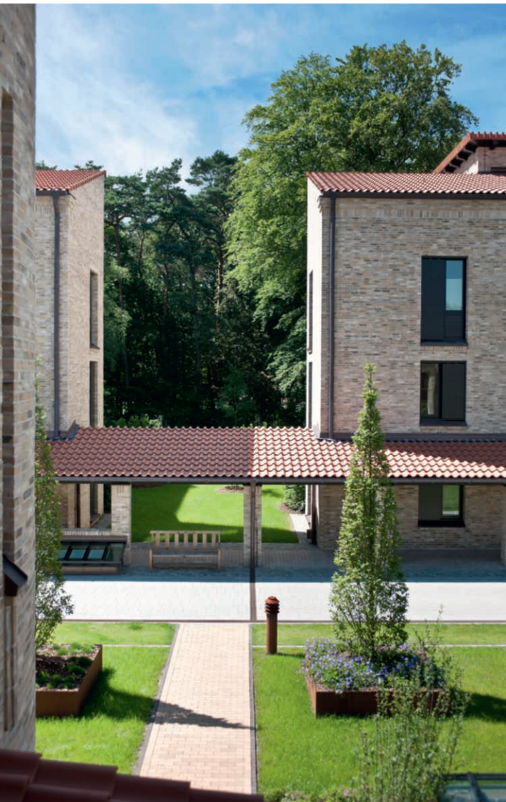
Das Hanna Reemtsma Haus ist eine Seniorenwohnanlage, die als aktives, variiertes Wohnviertel in einer abwechslungsreichen Gartenanlage geplant wurde, die an eine Lichtung im Wald erinnert.
