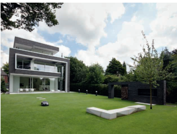
Eine zwei Meter hohe Gartenmauer aus Kolumba-Steinen mit integriertem Grill dient außerdem zur Aufbewahrung von Kaminholz und Gartengeräten.
