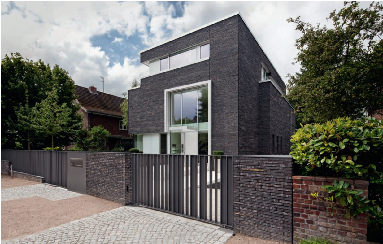
Der Bauherr und der Architekt Thomas Delius entschieden sich für speziell hergestellte Kolumba-Steine mit einem größeren Anteil an gelbem Lehm und Sandzuschlag.
