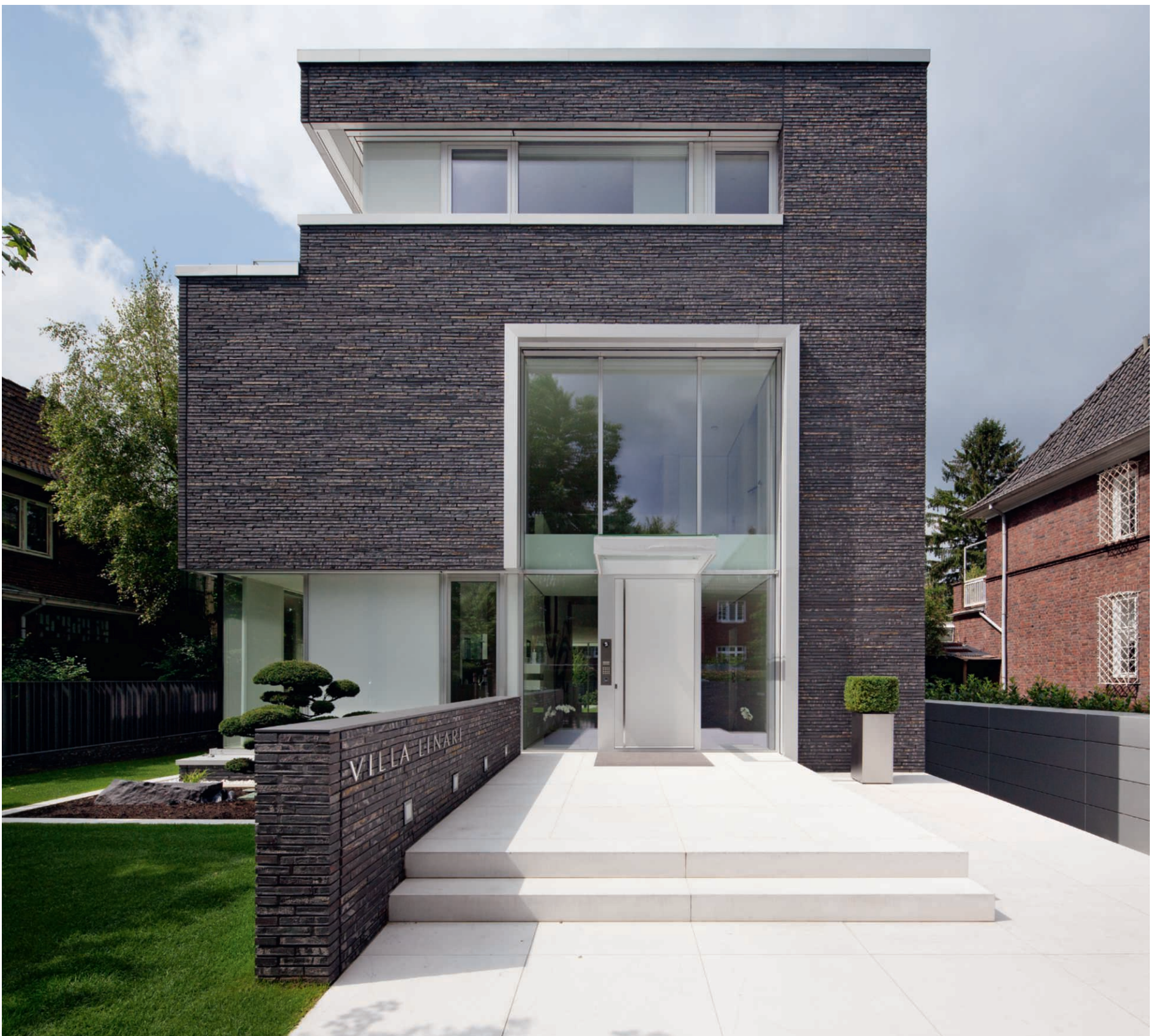
Am Hauseingang bildet der markante Kolumba-Stein einen spannungsreichen Kontrast zu den feingliedrigen Glasfassadenprofilen aus Aluminium und zu den weißen Kalksteinplatten, die innen und außen als Bodenbelag dienen.
