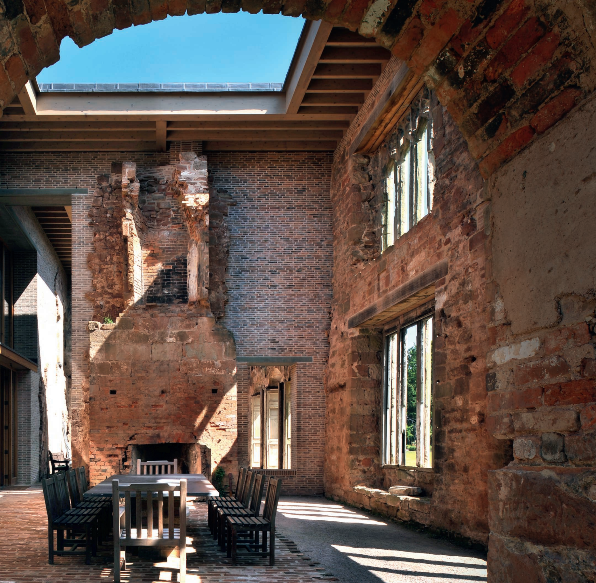
Im großen, doppelhohen Raum befindet man sich gleichzeitig draußen und drinnen. Die unbehandelten Mauern der Ruine werden von einem schmalen Dach geschützt.
