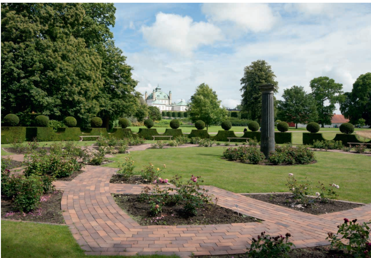
Die Klinker messen 240 x 120 x 50 mm – ein gutes Format für das Blattmuster des Gartenplans. Die Klinker wurden aus fettem englischen Ton hergestellt, der in rötlichen, braunen und bläulichen Nuancen changiert.
