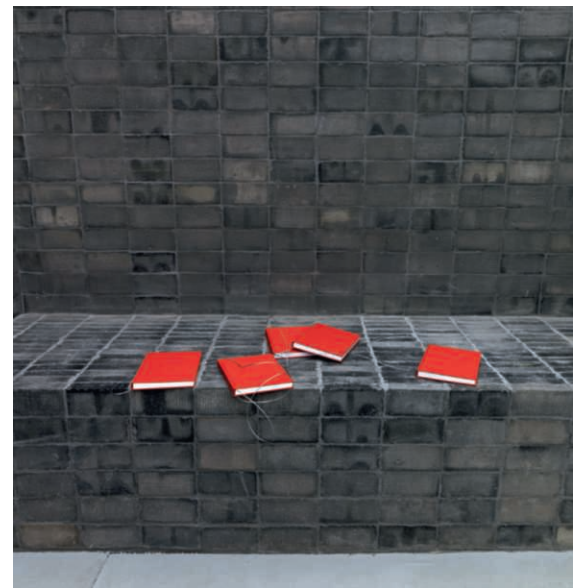
Eine eingebaute Bank in der räumlichen Installation ist genauso aufgemauert wie der Kasten draußen.
