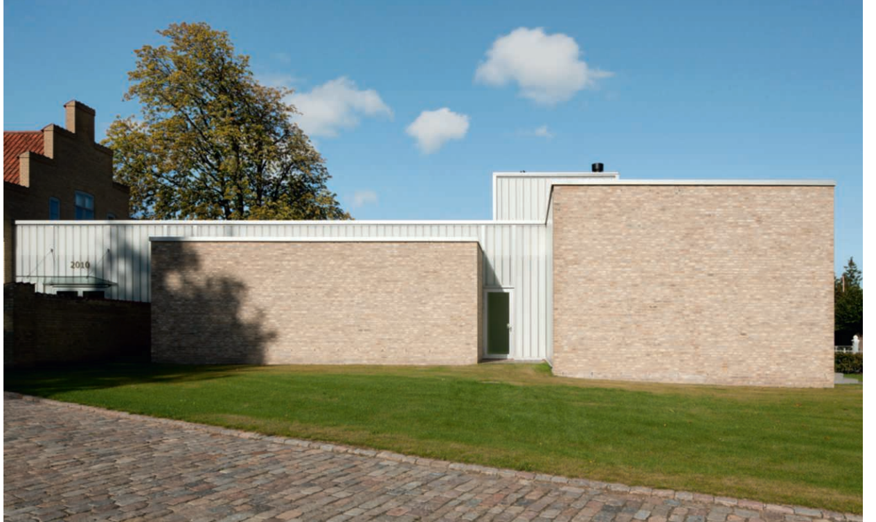
Der neue Anbau mit den ruhigen, klar definierten Fassaden demonstriert die Kunst, Wirkmittel sparsam einzusetzen.
