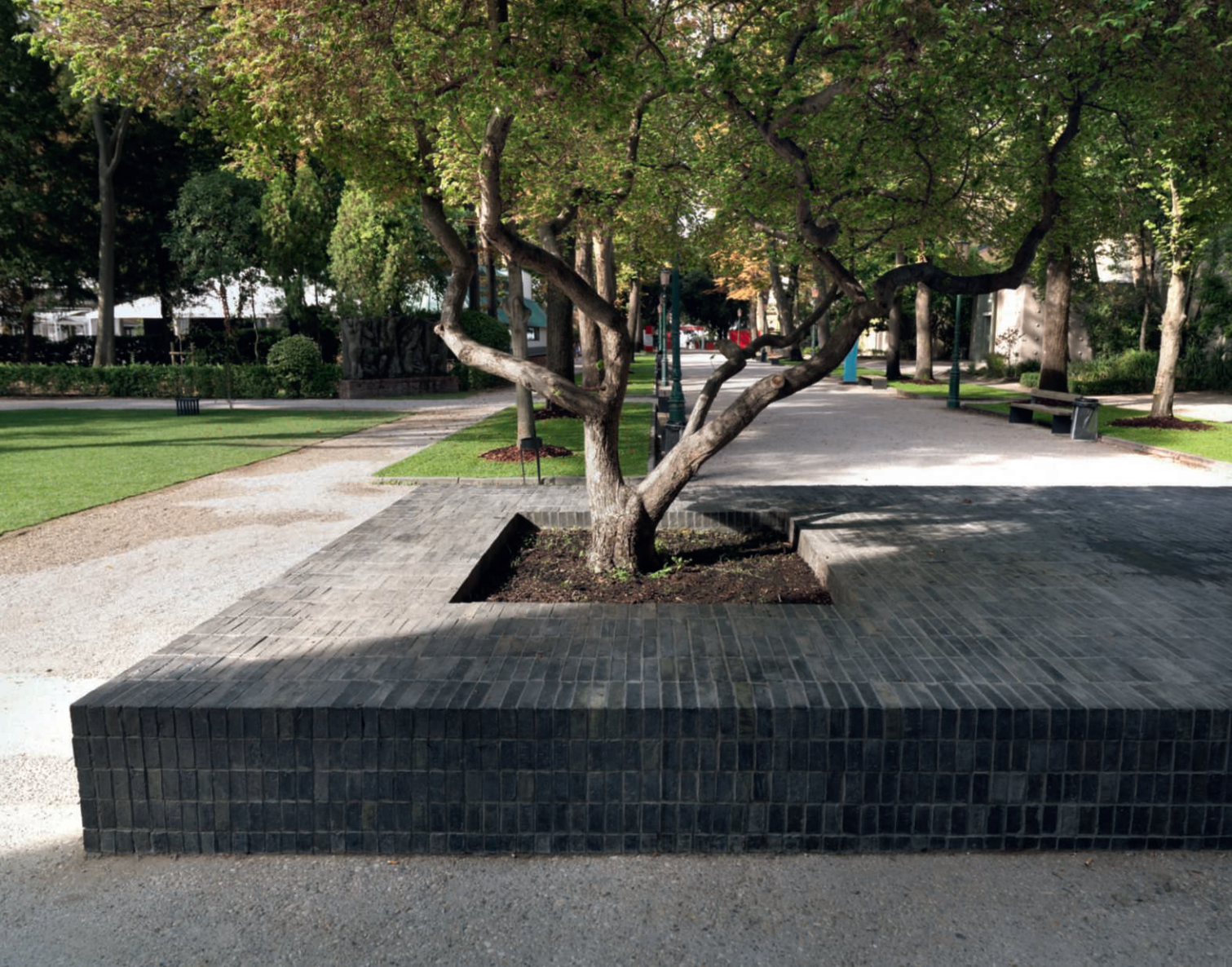
Für die Architekturbiennale 2012 in Venedig schufen die Architekten Kuehn Malvezzi eine Installation, »Komuna Fundamento«, die zentral am Palazzo delle Esposizioni platziert ist. Einem Teil der Installation begegnet man bereits außerhalb des Pavillons, in Form eines vermauerten Kastens, der den Höhenunterschied im Terrain ausgleicht.
