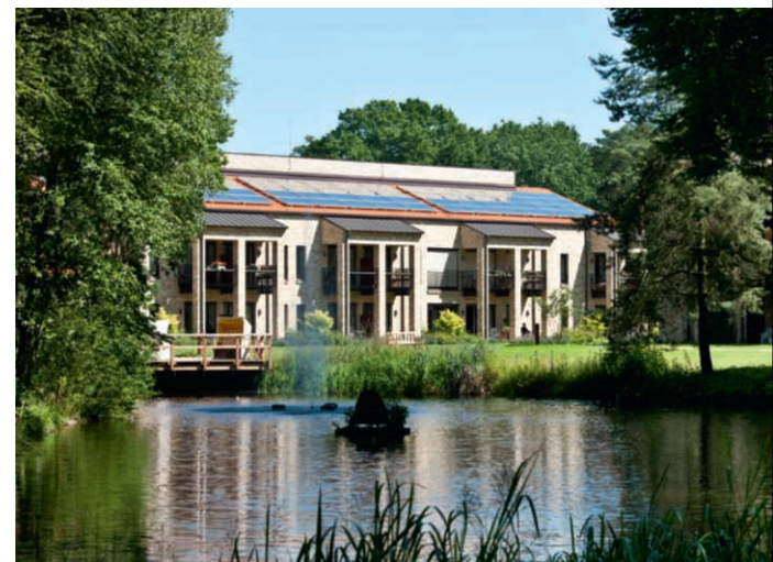
Nach Süden gewandte Dachflächen sind mit Solaranlagen zur Unterstützung der Heizung ausgestattet, einer hauseigenen Holzpellet-Heizung.
