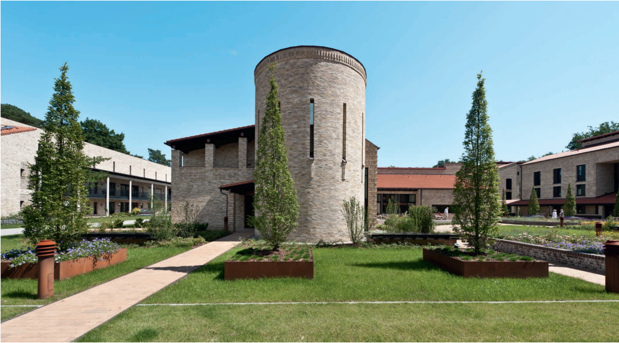
Materialien, Baukörper und Dimensionen verbinden sich zu einem Gesamteindruck, der an die Renaissance denken lässt.
