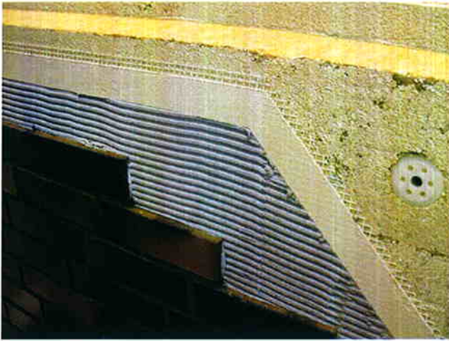
Bild 8. Klinkerriemchen als Deckschicht von WDVS bilden eine robuste und wartungsfreie Wandbekleidung Fig. 8. Clinker tiles as top layer of ETICS form a robust and maintenance-free wall covering
