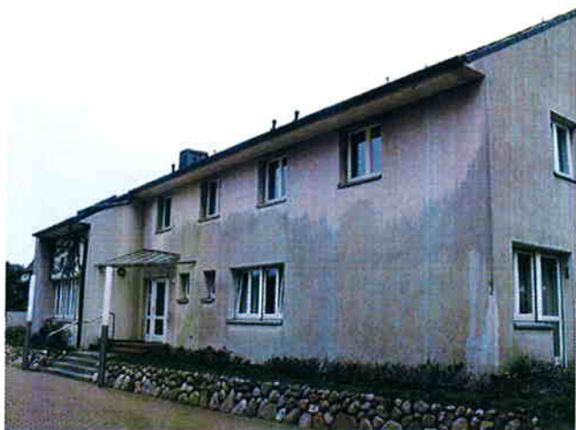
Bild 5. Die hohe Schlagregenbeanspruchung in Norddeutschland begünstigt zusätzlich den Algen- und Pilzbefall bei Fassaden aus WDVS
